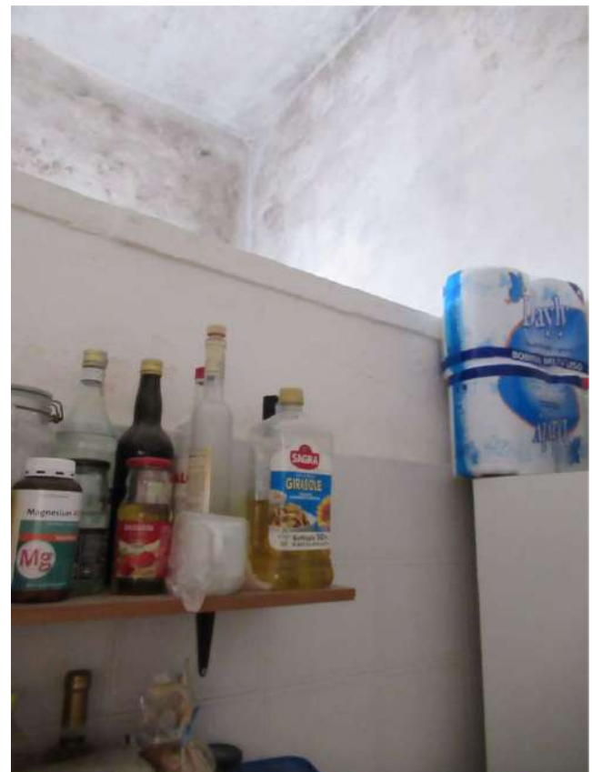
23 Ripostiglio con divisorio aperto
