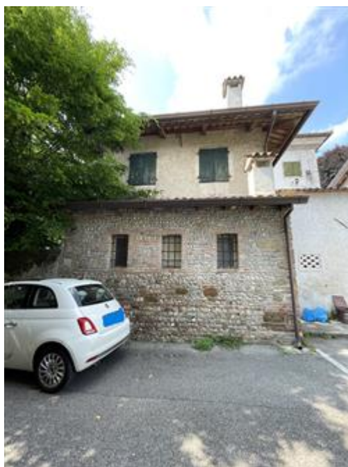
Prospetto laterale su stradina.
