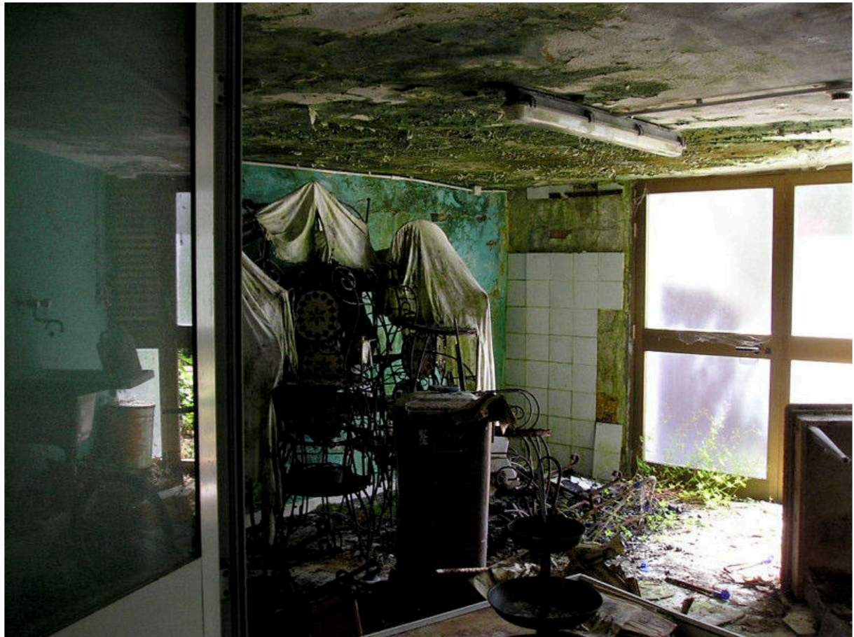
FOTOGRAFIA 39 - Piano Seminterrato / Servizi sottostanti Lastrico Ingresso
