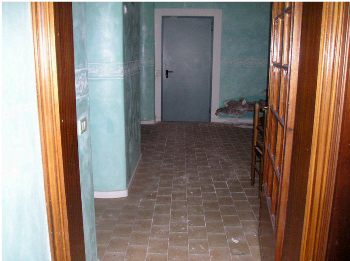
FOTOGRAFIA 30 - Piano Seminterrato / Ingresso Sala Pranzo - Porta REI
