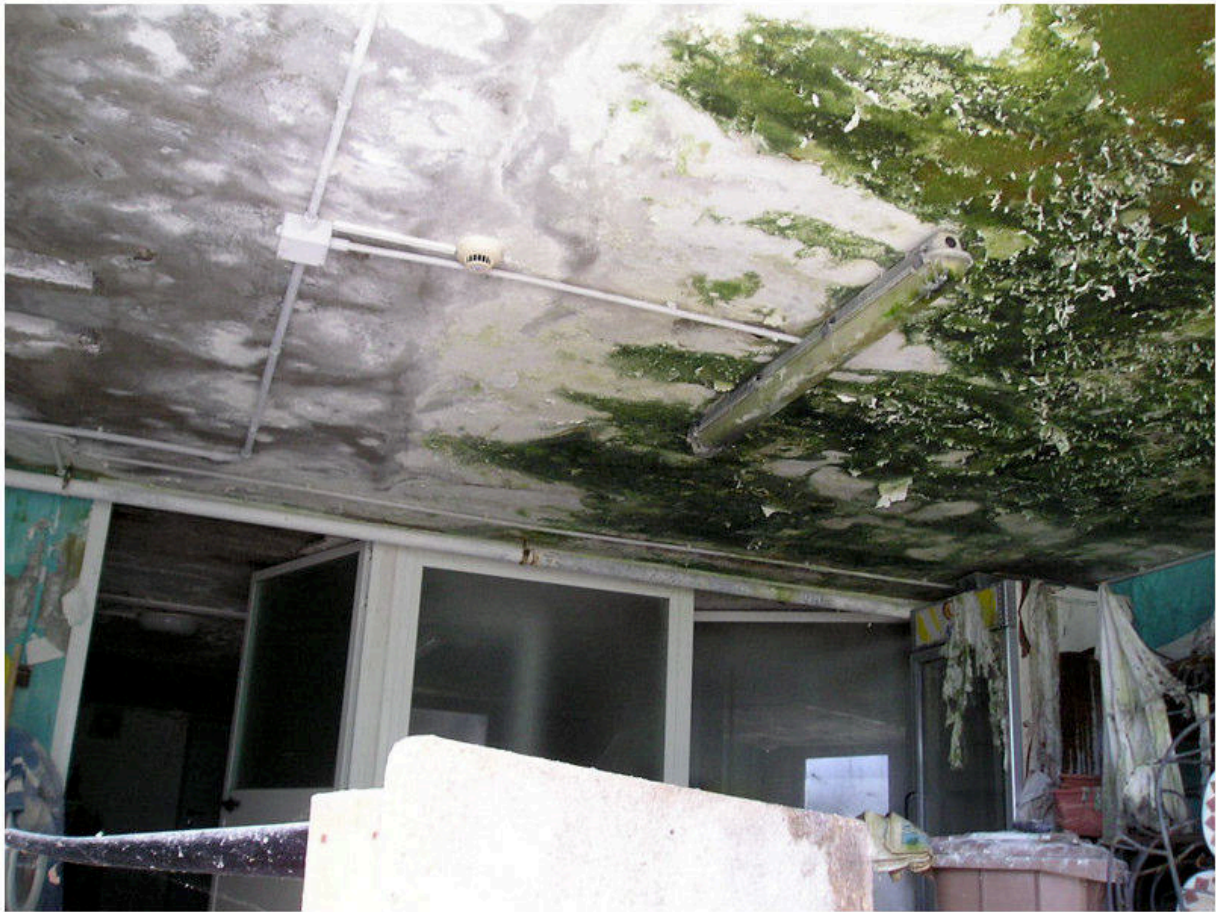
FOTOGRAFIA 41 - Piano Seminterrato / Servizi sottostanti Lastrico Ingresso
