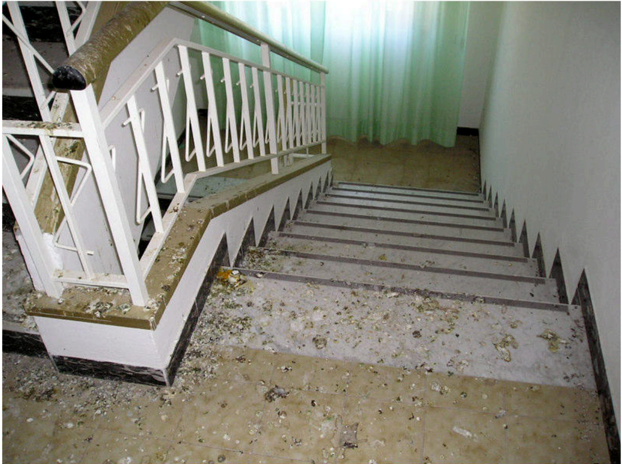
FOTOGRAFIA 55 - Piano Secondo / Vano Scala
