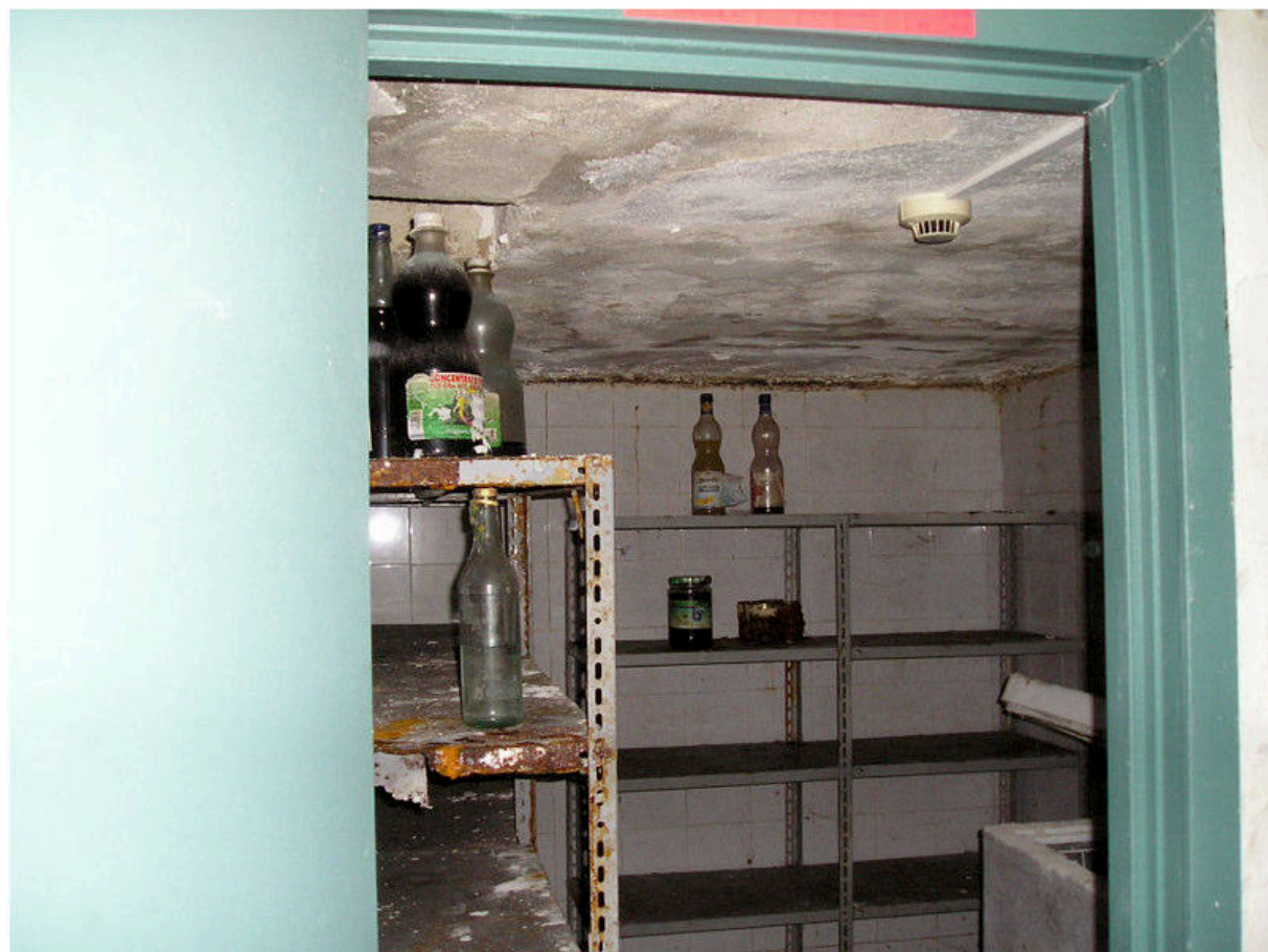
FOTOGRAFIA 44 - Piano Seminterrato / Servizi sottostanti Lastrico Ingresso
