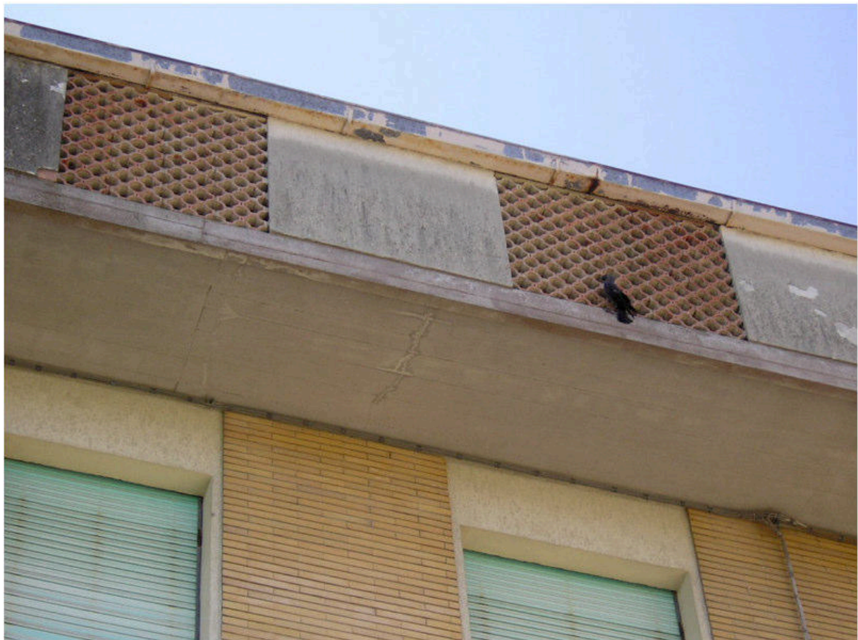
FOTOGRAFIA 08 - Esterno Edificio / Gronda
