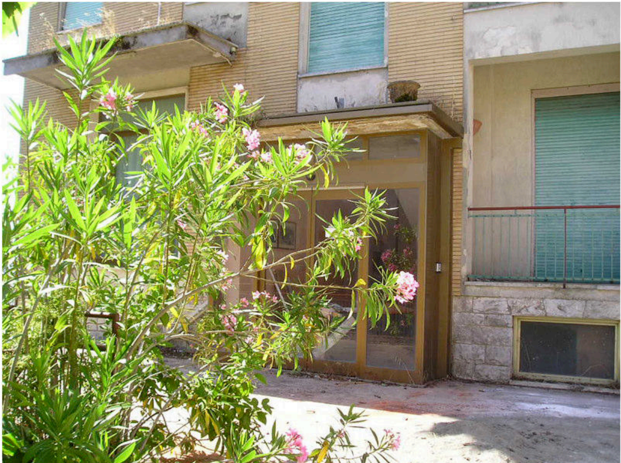
FOTOGRAFIA 02 - Esterno Fronte Ingresso
