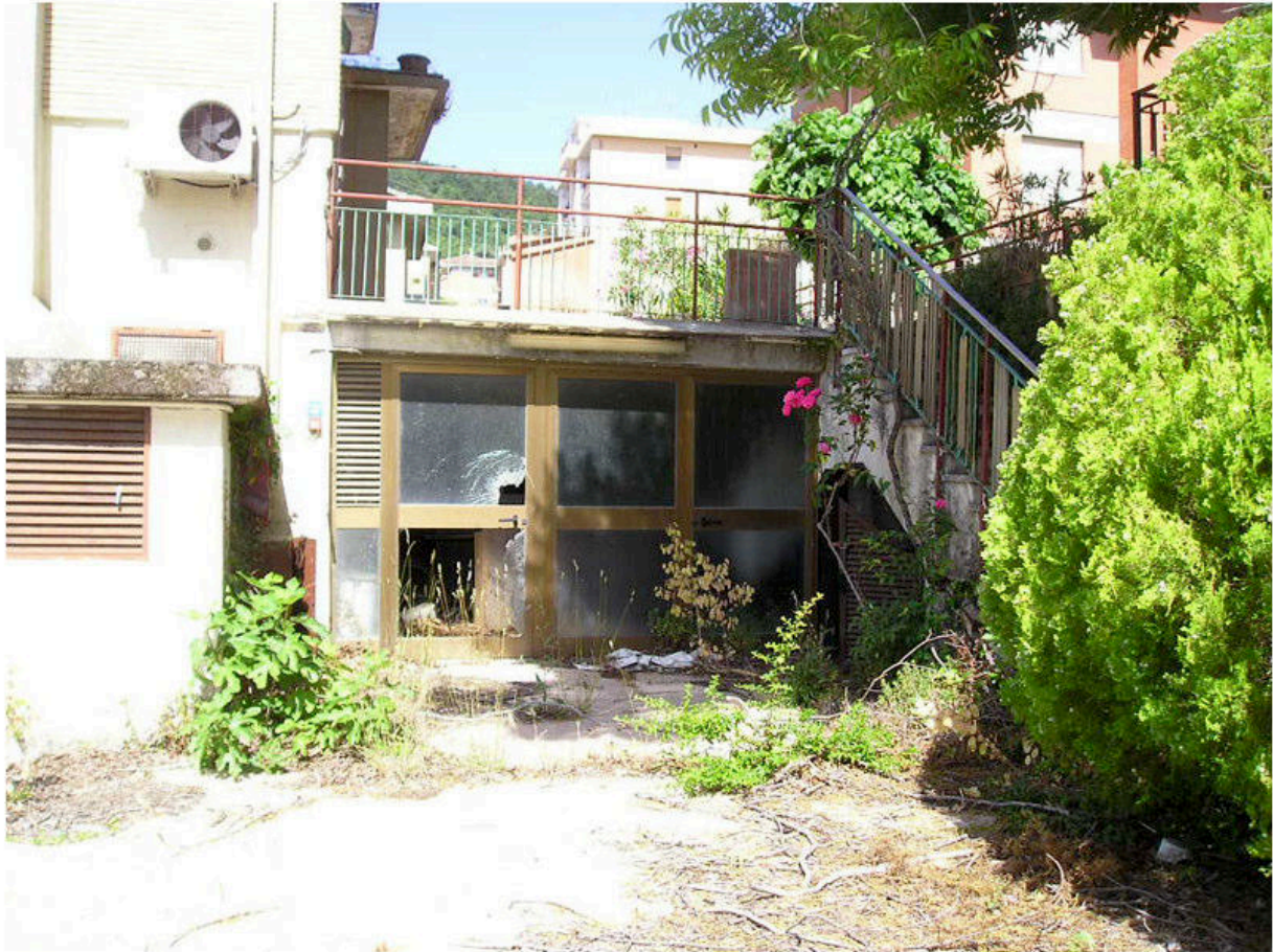
FOTOGRAFIA 07 - Esterno Edificio / Resede
