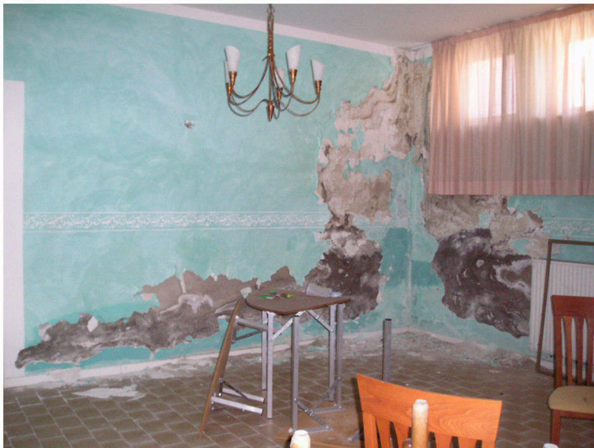
FOTOGRAFIA 31 - Piano Seminterrato / Sala da Pranzo
