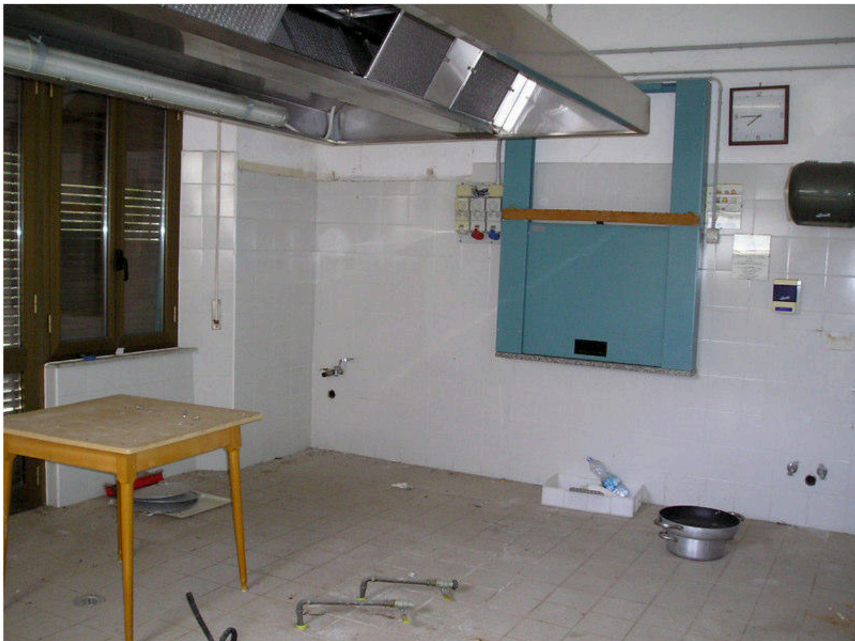
FOTOGRAFIA 34 - Piano Seminterrato / Cucina
