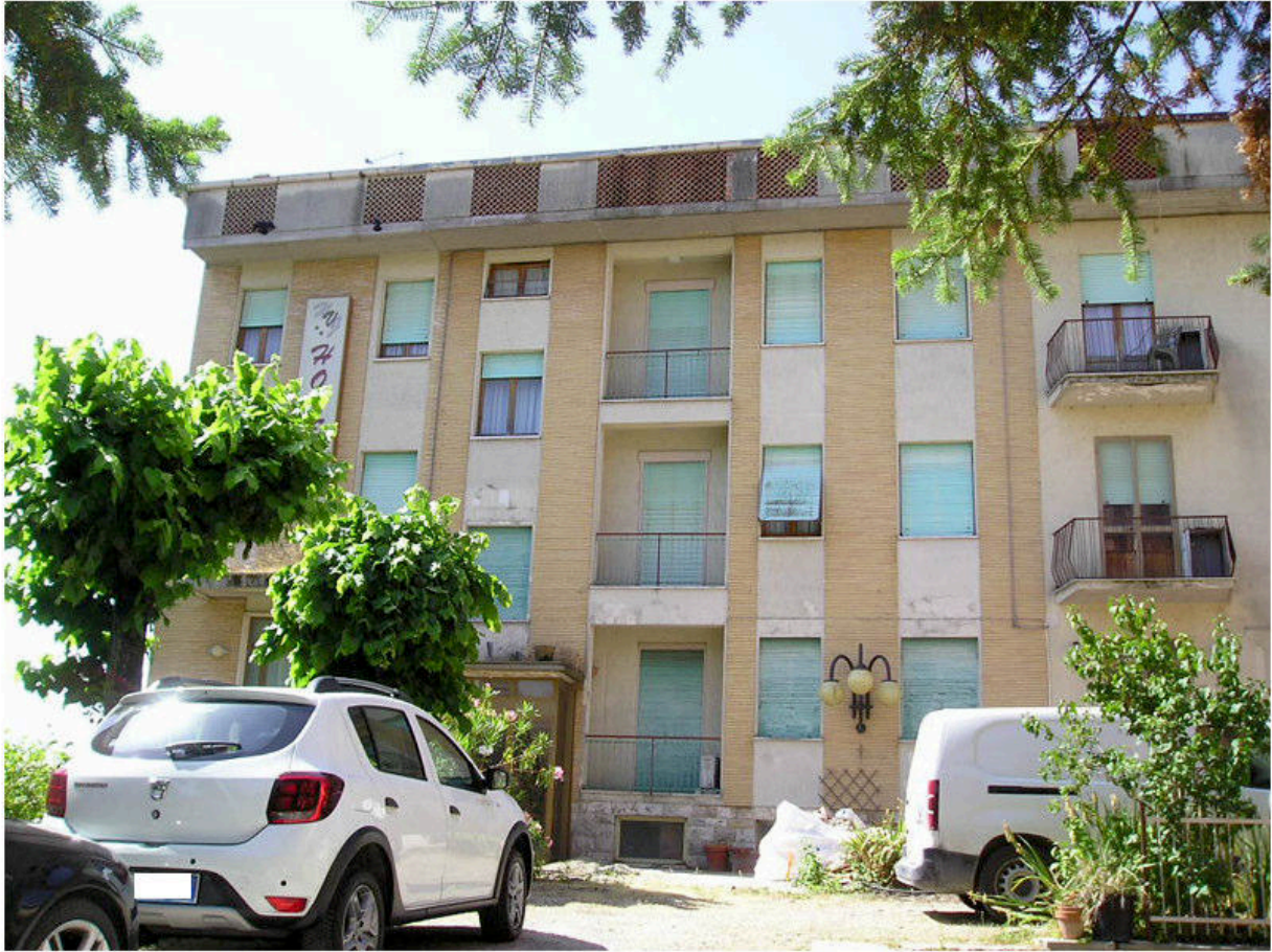
FOTOGRAFIA 01 - Esterno Fronte Edificio
