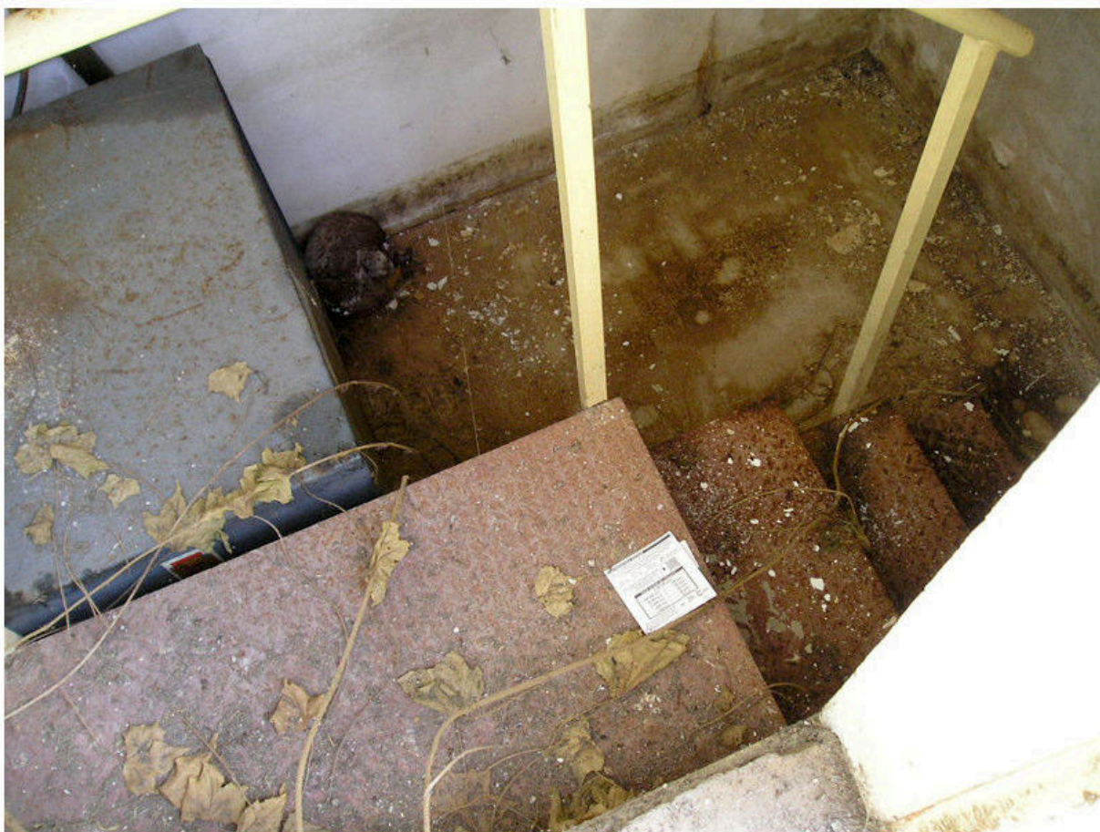
FOTOGRAFIA 49 - Piano Seminterrato / Vano Tecnico Ascensore
