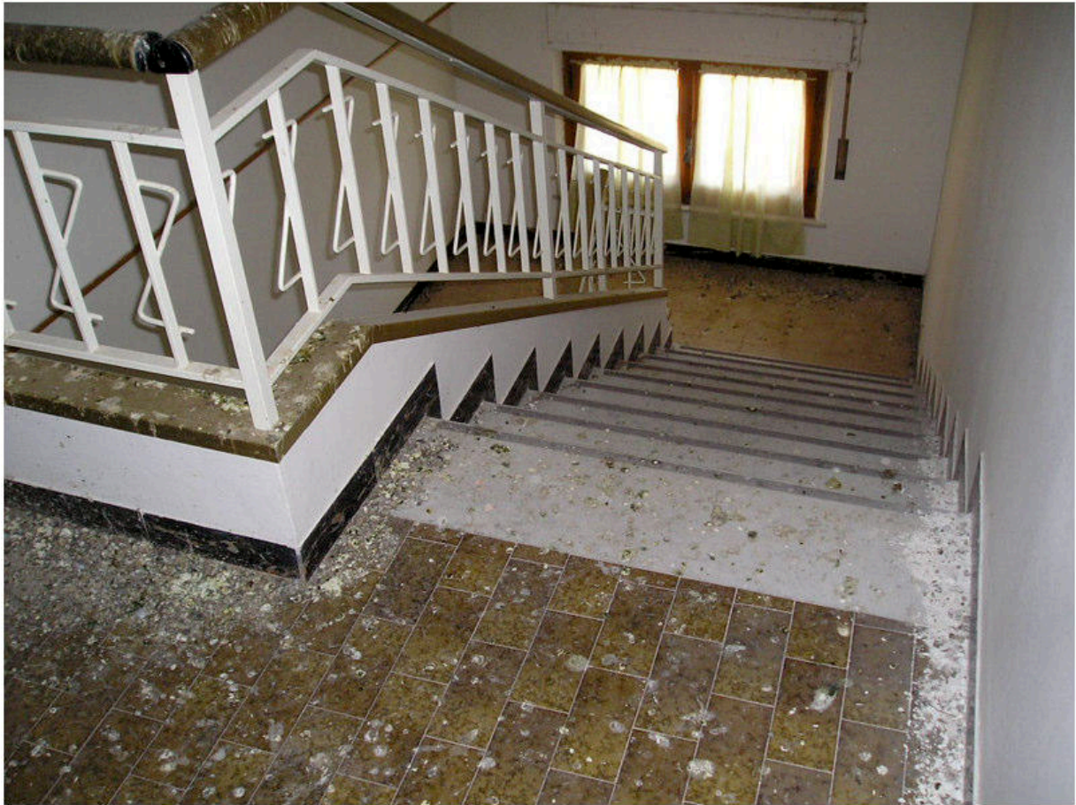
FOTOGRAFIA 59 - Piano Terzo / Vano Scala
