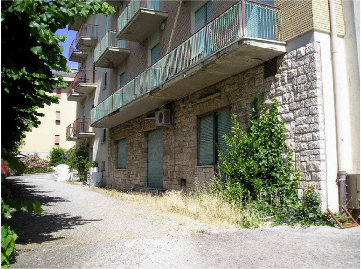
FOTOGRAFIA 09 - Esterno Edificio / Resede
