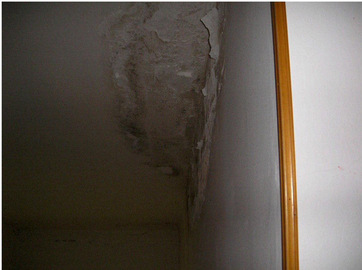
FOTOGRAFIA 64 - Piano Terzo / Solaio Copertura
