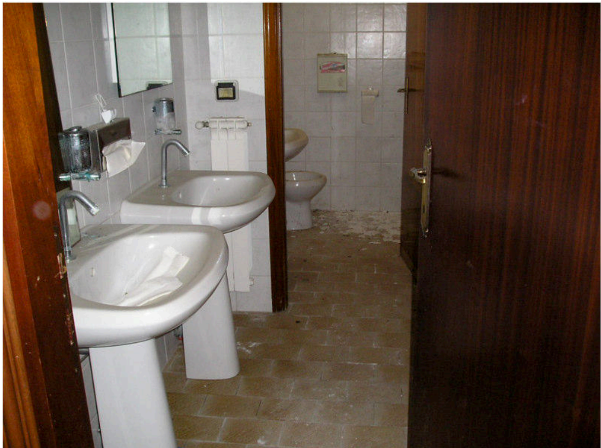
FOTOGRAFIA 36 - Piano Seminterrato / Servizio Igienico
