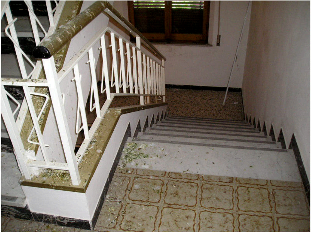
FOTOGRAFIA 51 - Piano Primo / Vano Scala
