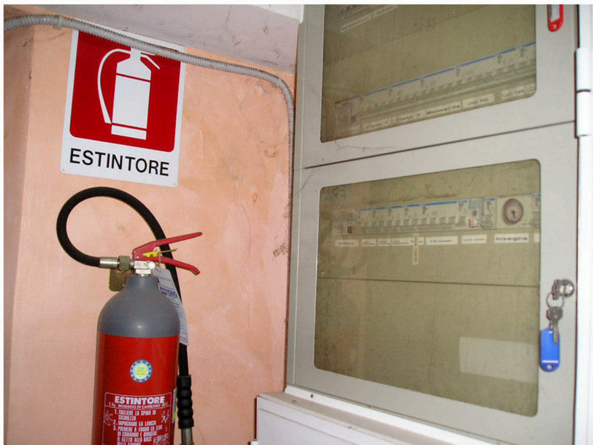
FOTOGRAFIA 37 - Piano Seminterrato / Area Quadri
