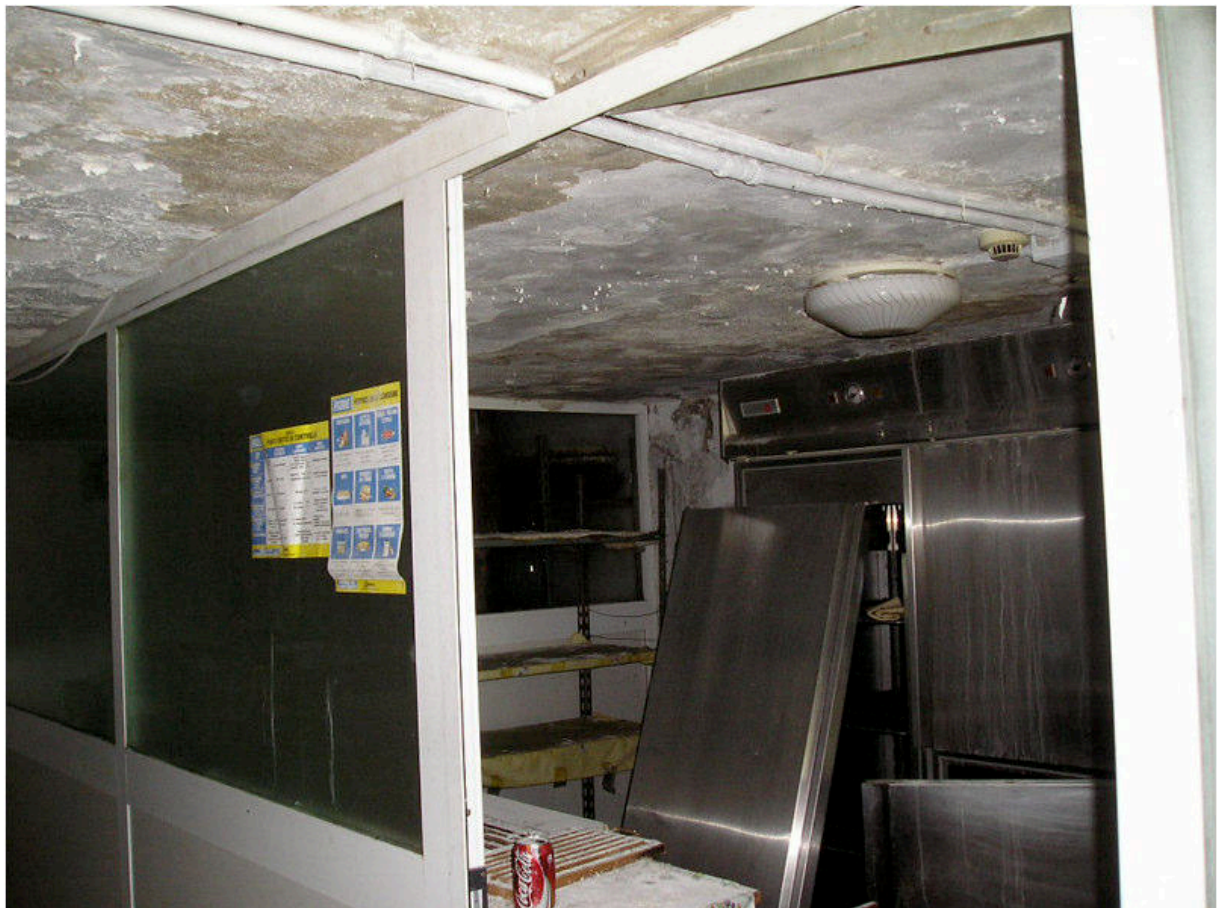
FOTOGRAFIA 42 - Piano Seminterrato / Servizi sottostanti Lastrico Ingresso
