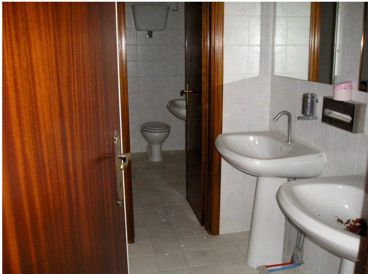
FOTOGRAFIA 28 - Piano Terreno / Servizio Igienico
