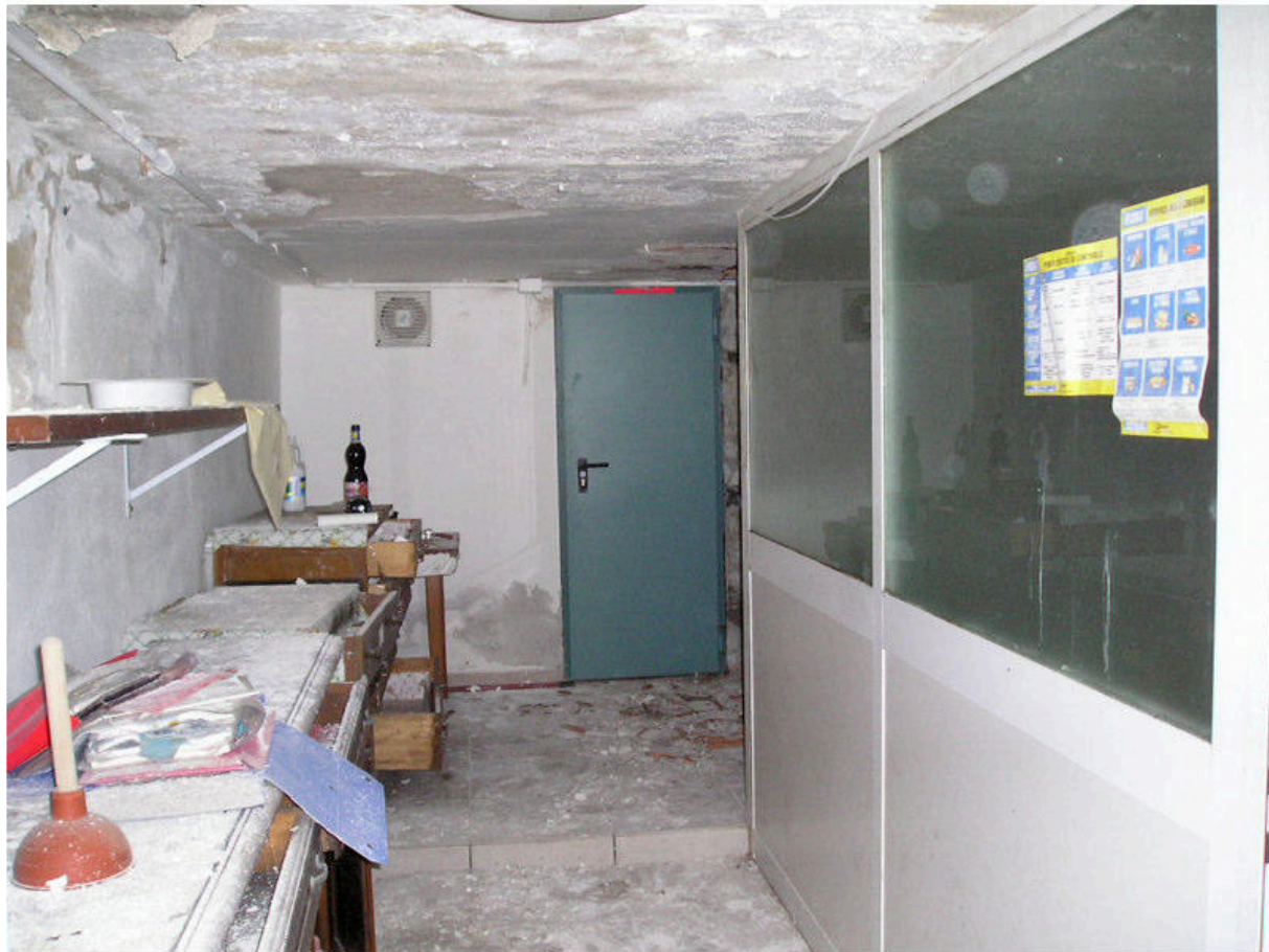
FOTOGRAFIA 43 - Piano Seminterrato / Servizi sottostanti Lastrico Ingresso
