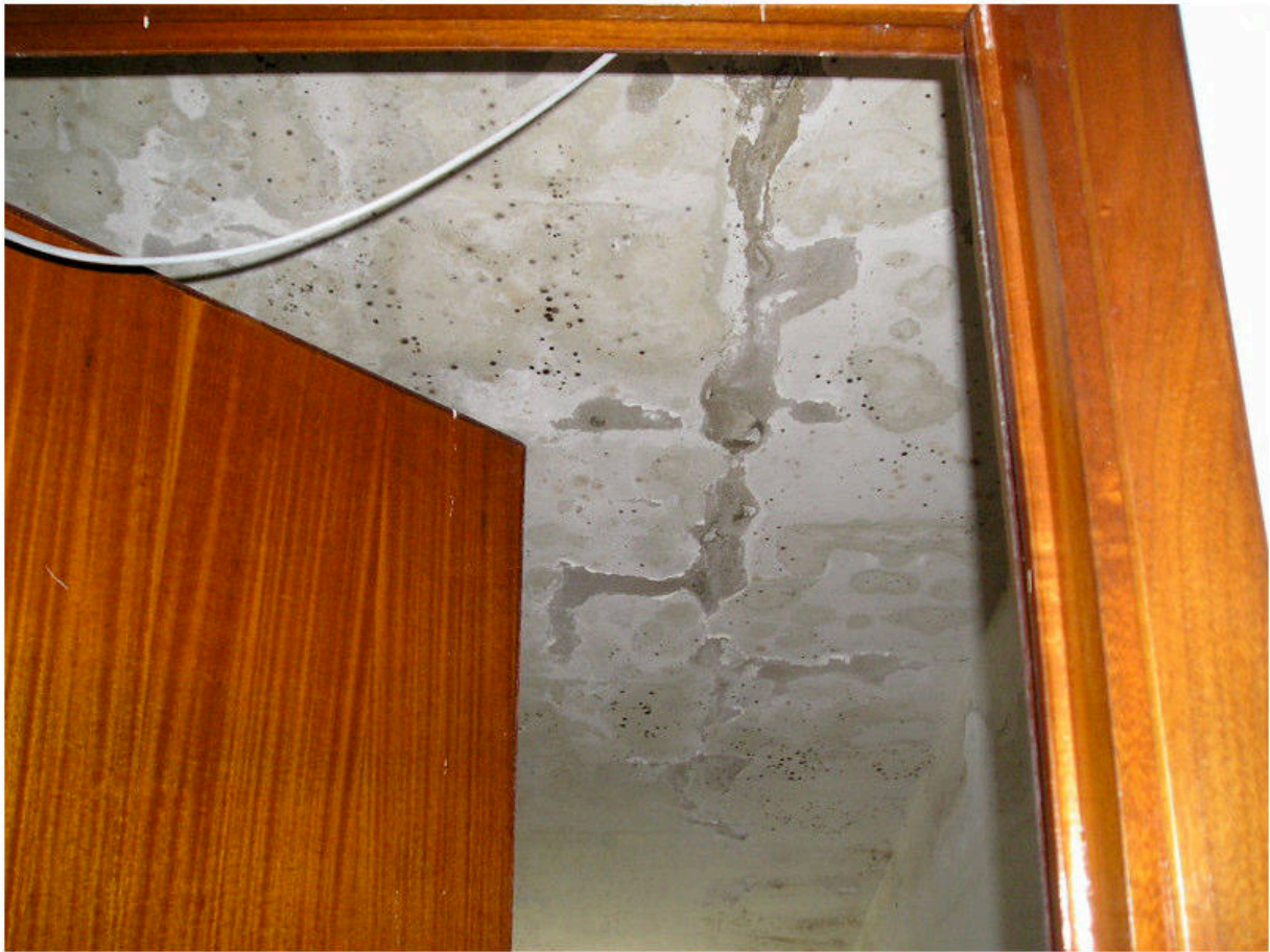
FOTOGRAFIA 63 - Piano Terzo / Solaio Copertura
