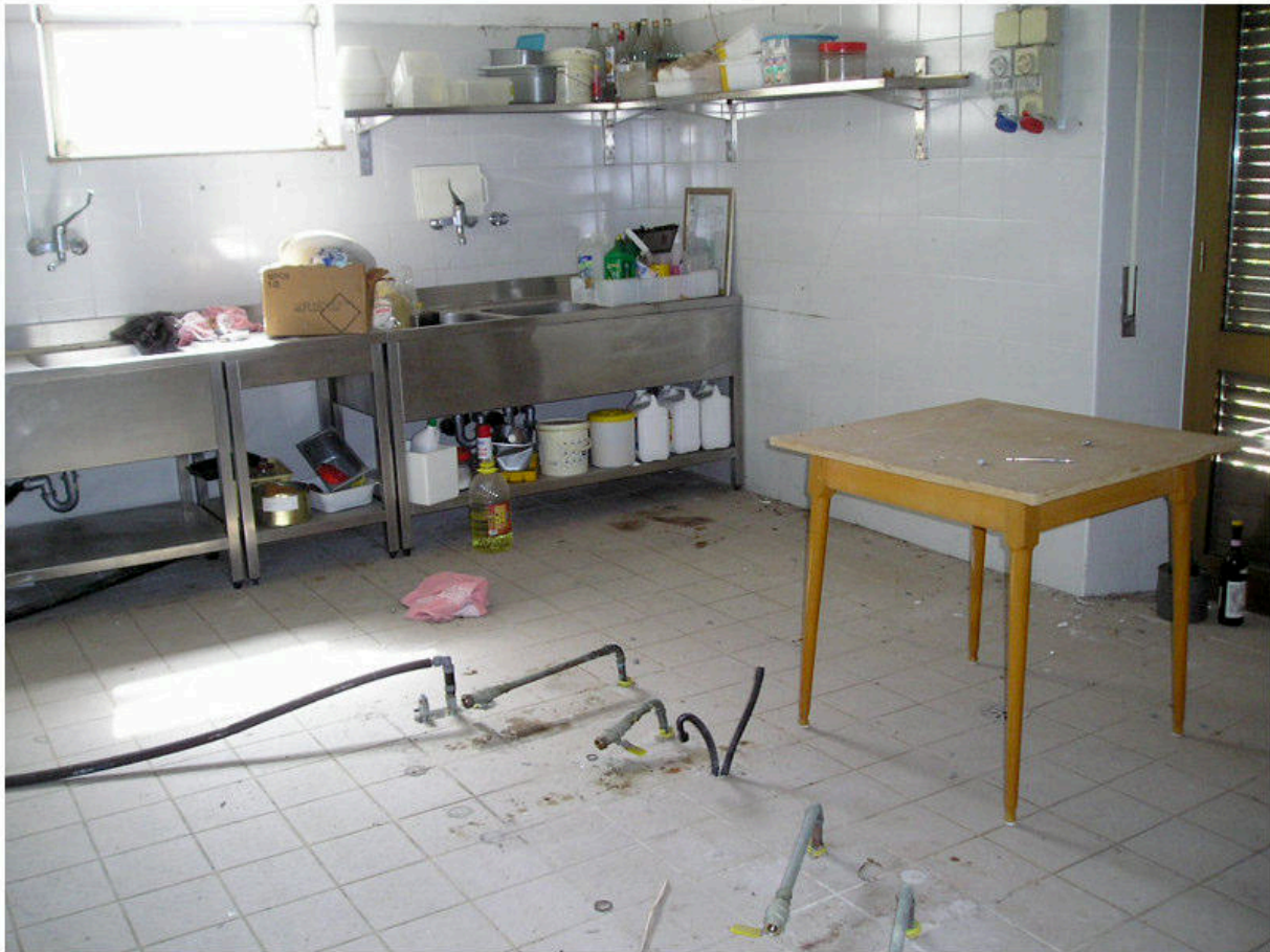
FOTOGRAFIA 33 - Piano Seminterrato / Cucina
