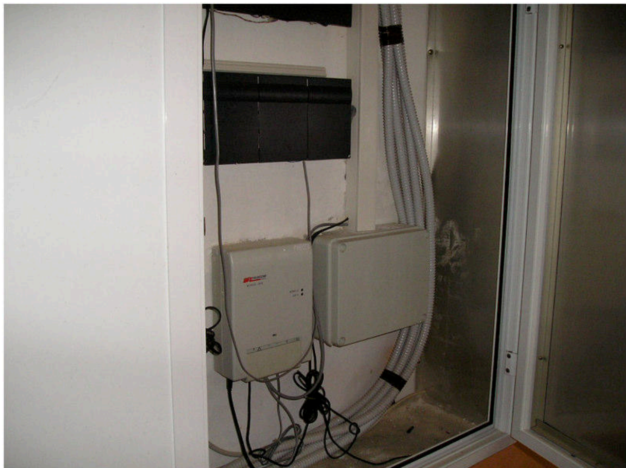
FOTOGRAFIA 38 - Piano Seminterrato / Area Quadri
