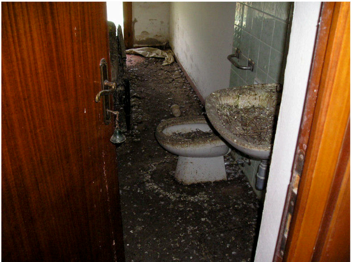
FOTOGRAFIA 62 - Piano Terzo / Servizio Igienico Tipo
