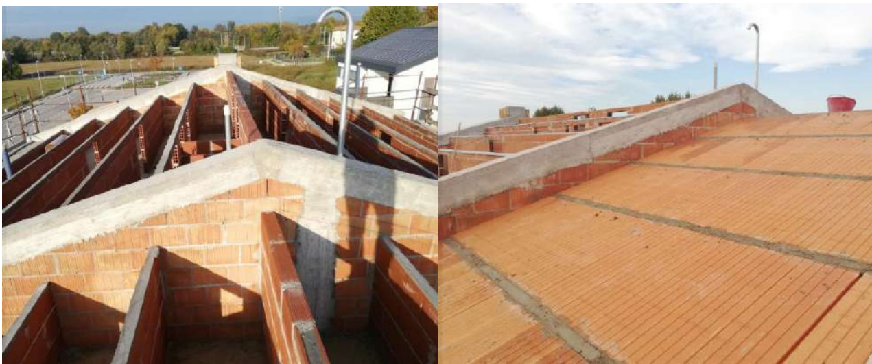
Immagini relative a tipologie di tetti a muricci e tavelloni
