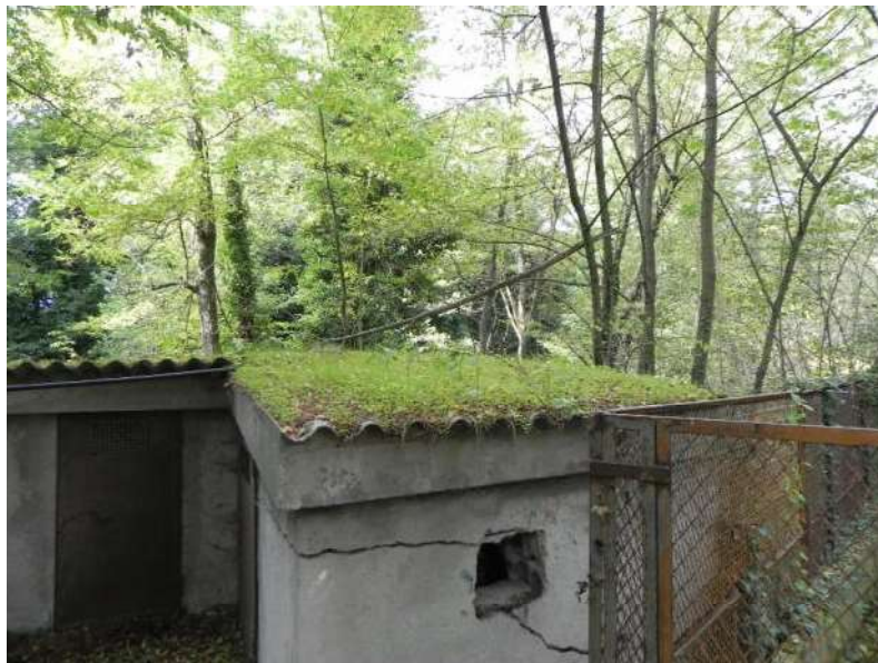
rudere che veniva utilizzato negli anni 80 per la depurazione delle acque reflue
