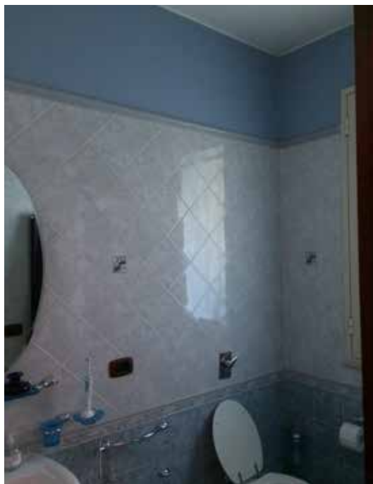
Foto 17. Piano terra. Servizio igienico.
