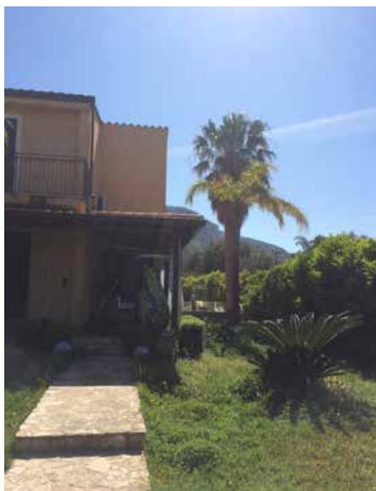
Foto 2. Corte, viottolo d'ingresso al piano terra.
