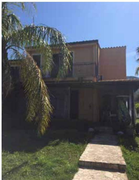
Foto 1. Corte, viottolo d'ingresso al piano terra.
