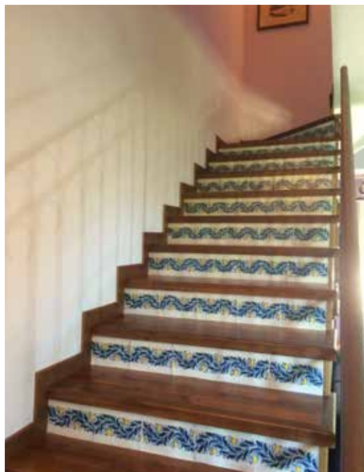
Foto 27. Scala d'accesso al primo piano.
