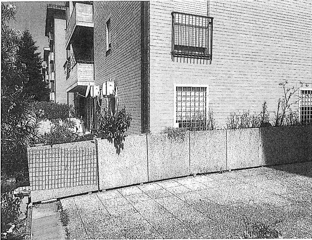
Foto n. 3 – Come foto n. 2: lati sud (a sinistra) ed est dell'appartamento.
