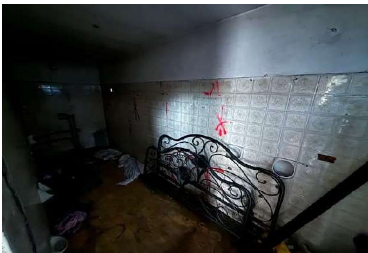
ripostiglio piano terra
