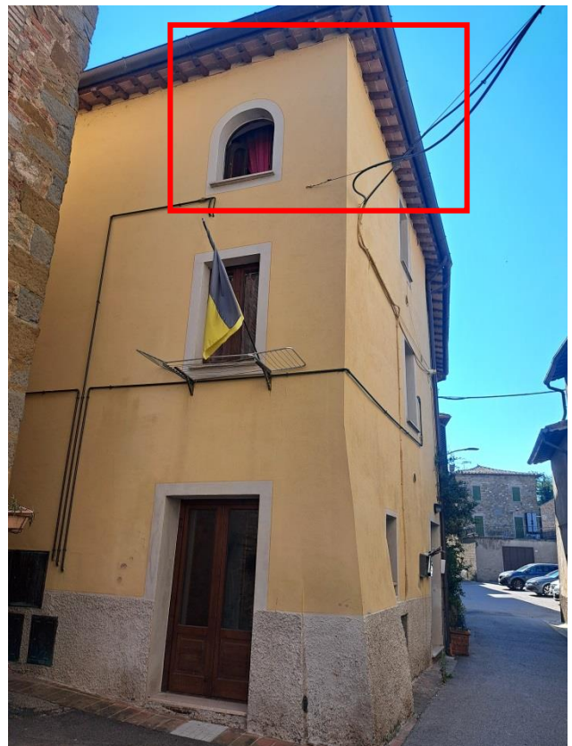
FOTO 2 (Vista esterna da Via Marta)
