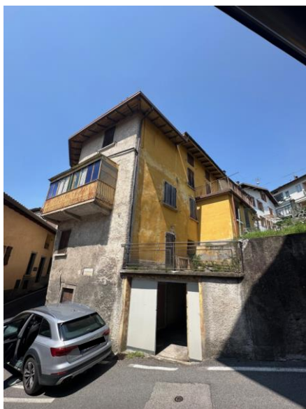
esterno sub 704-705 e box sub 702
