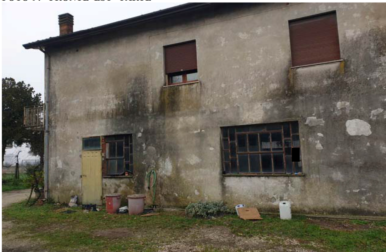
FOTO 04 - FRONTE EST - PARTE
