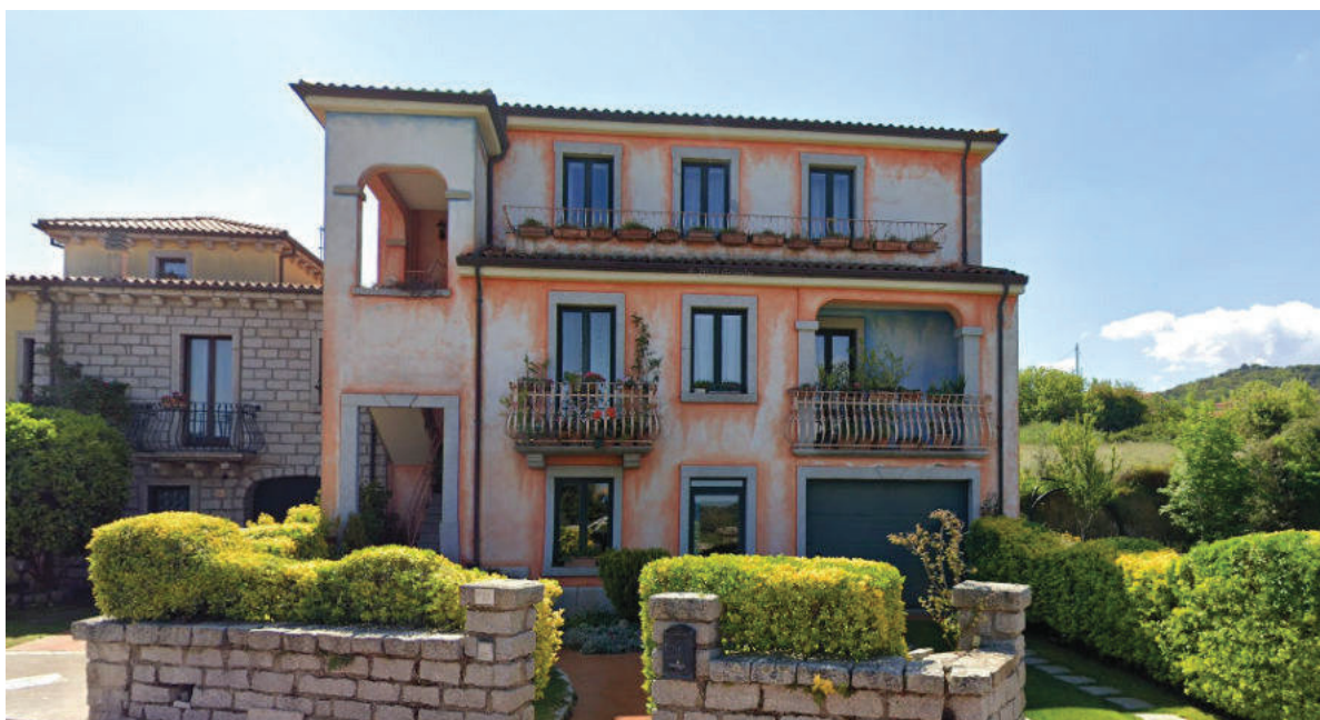
Foto n° 1 – Vista d'insieme prospetto principale –
