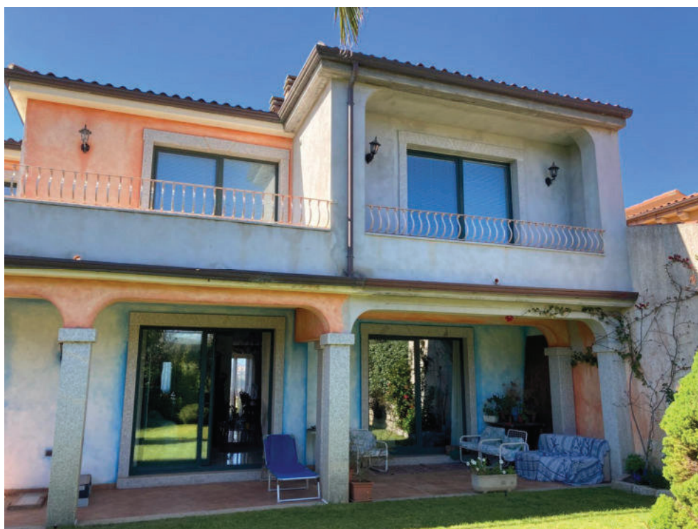
Foto n° 2 – Vista sul retro prospetto –
