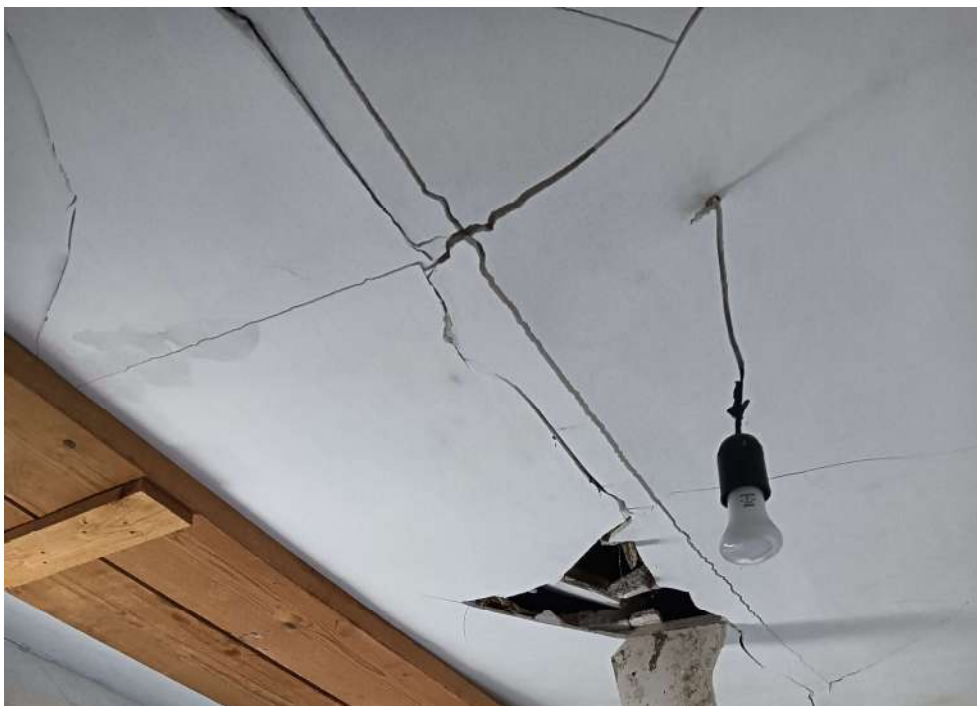
Foto 1 - Interni piano primo
