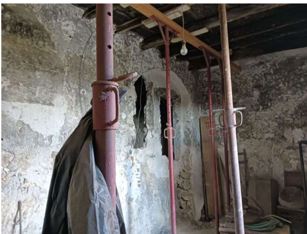
Foto 2 - Interni piano primo
