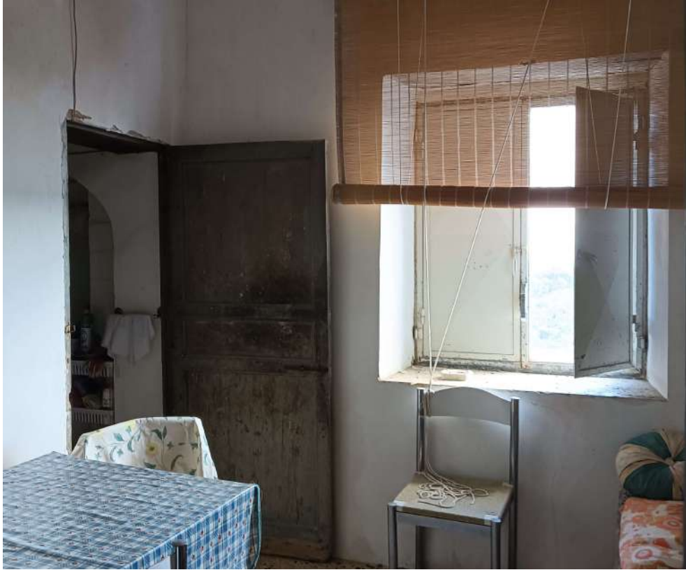
Foto 5 – Interni piano primo
