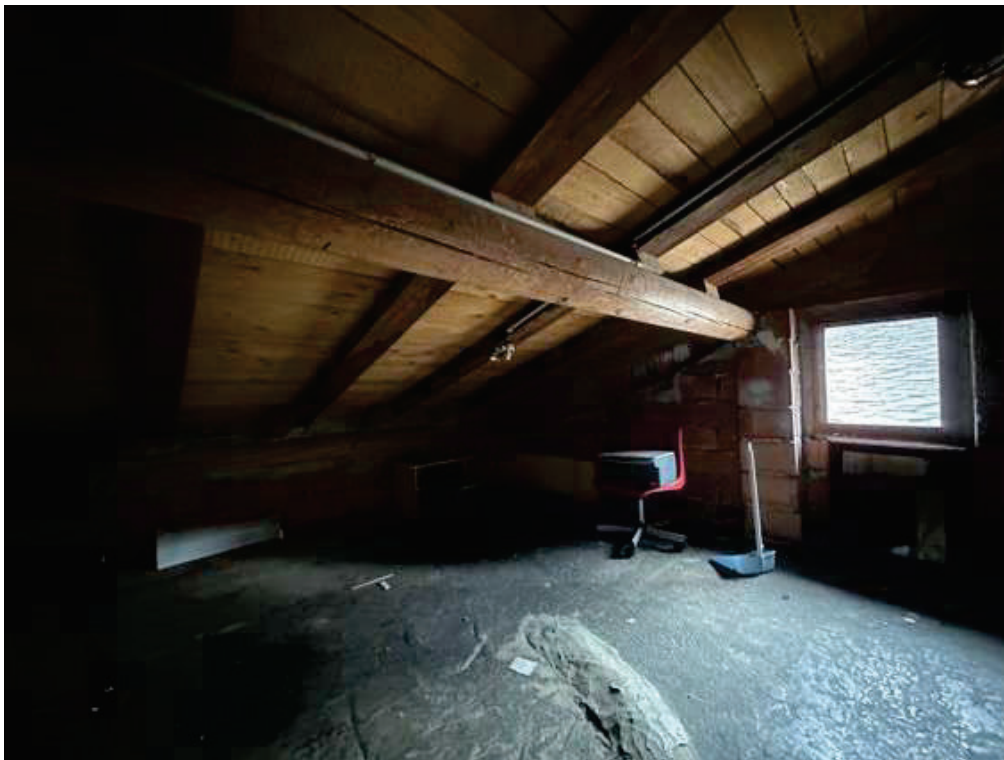
Fotografia E.40 - Solaio sottotetto_sub.15-d
