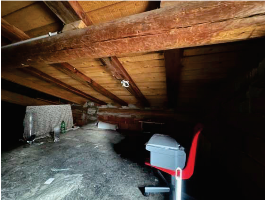
Fotografia E.41 - Solaio sottotetto_sub.15-e
