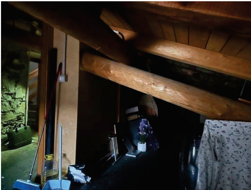
Fotografia E.38 - Solaio sottotetto_sub.15-b
