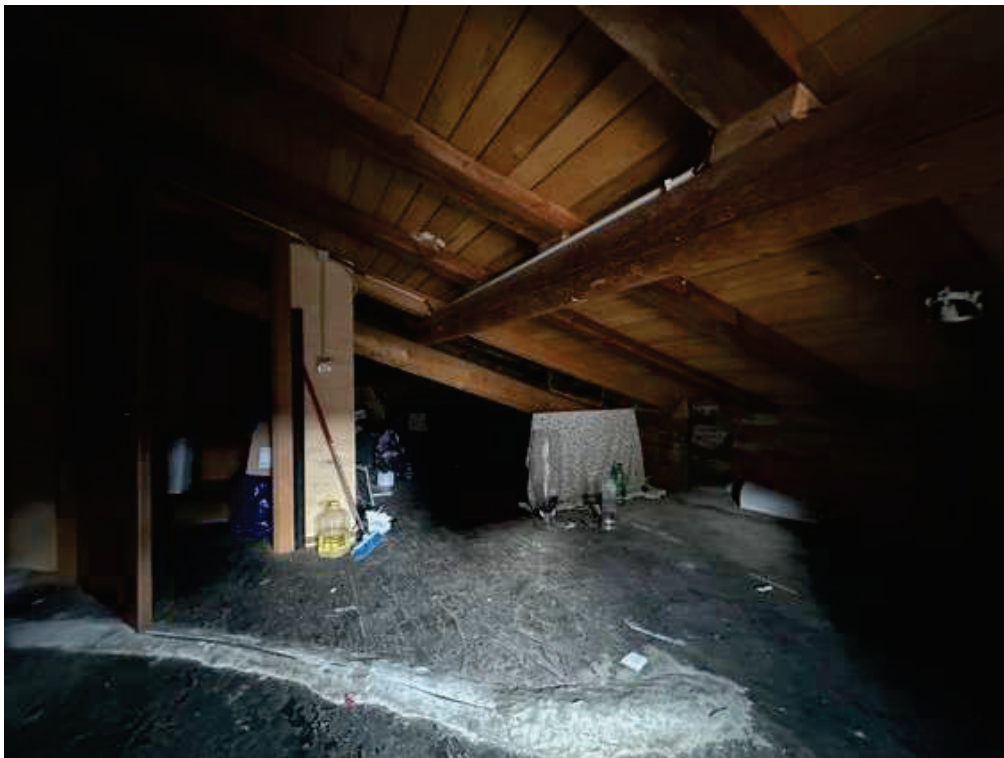
Fotografia E.42 - Solaio sottotetto_sub.15-f
