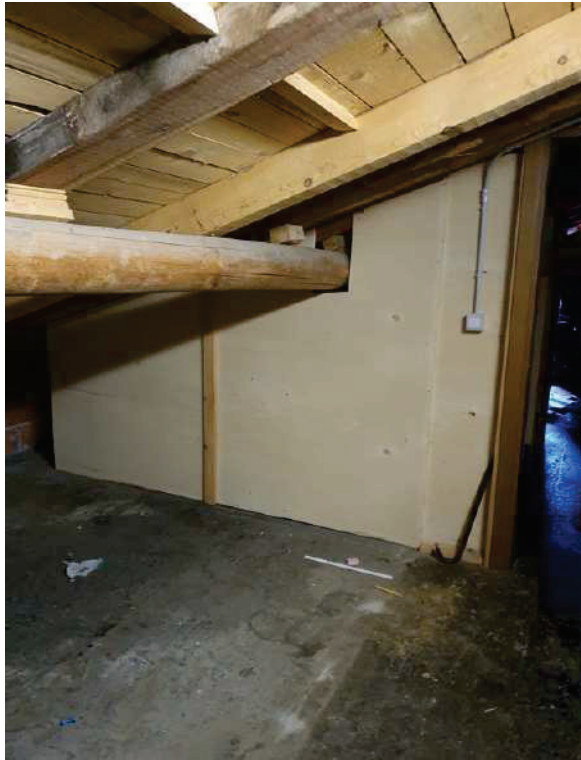
Fotografia E.51 - Solaio sottotetto sub.16 - Post modifica della dividente
