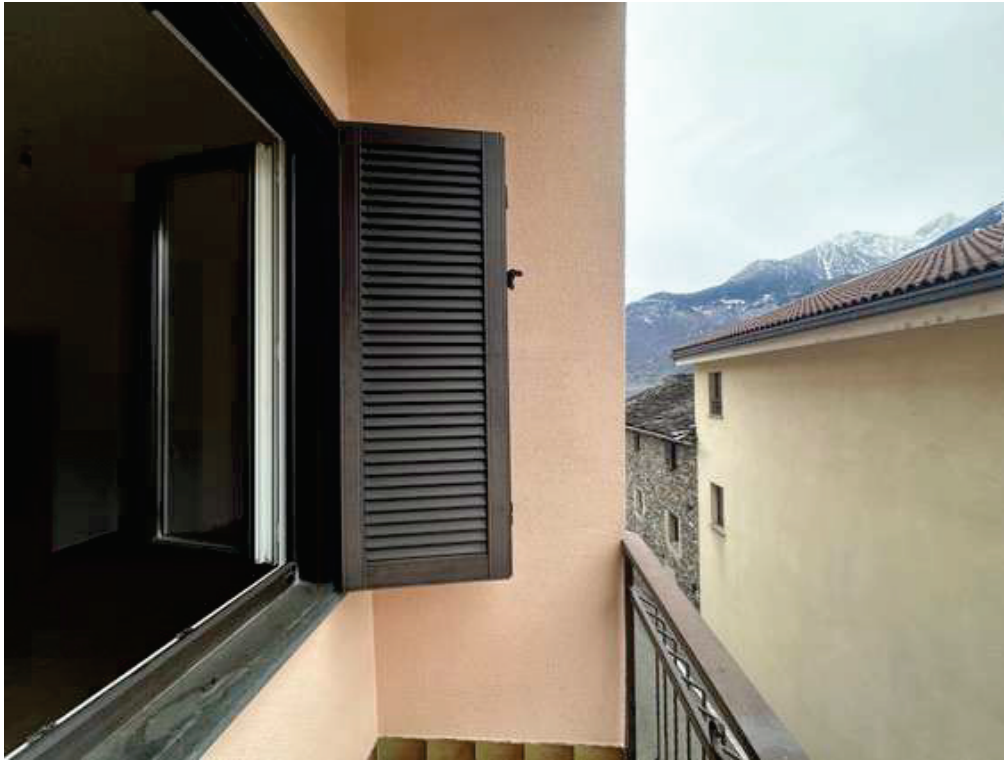
Fotografia E.33 - Appartamento piano primo: Balcone Camera_3_a
