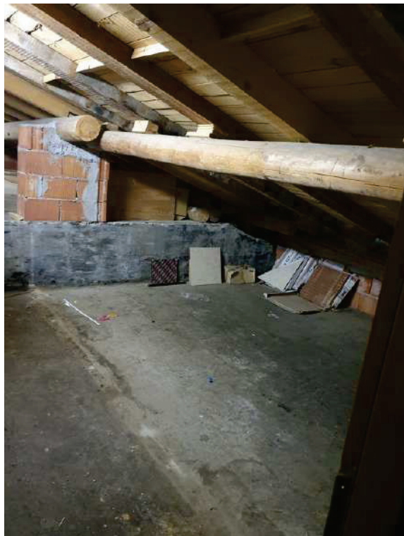
Fotografia E.52 - Solaio sottotetto sub.16 - Post modifica della dividente
