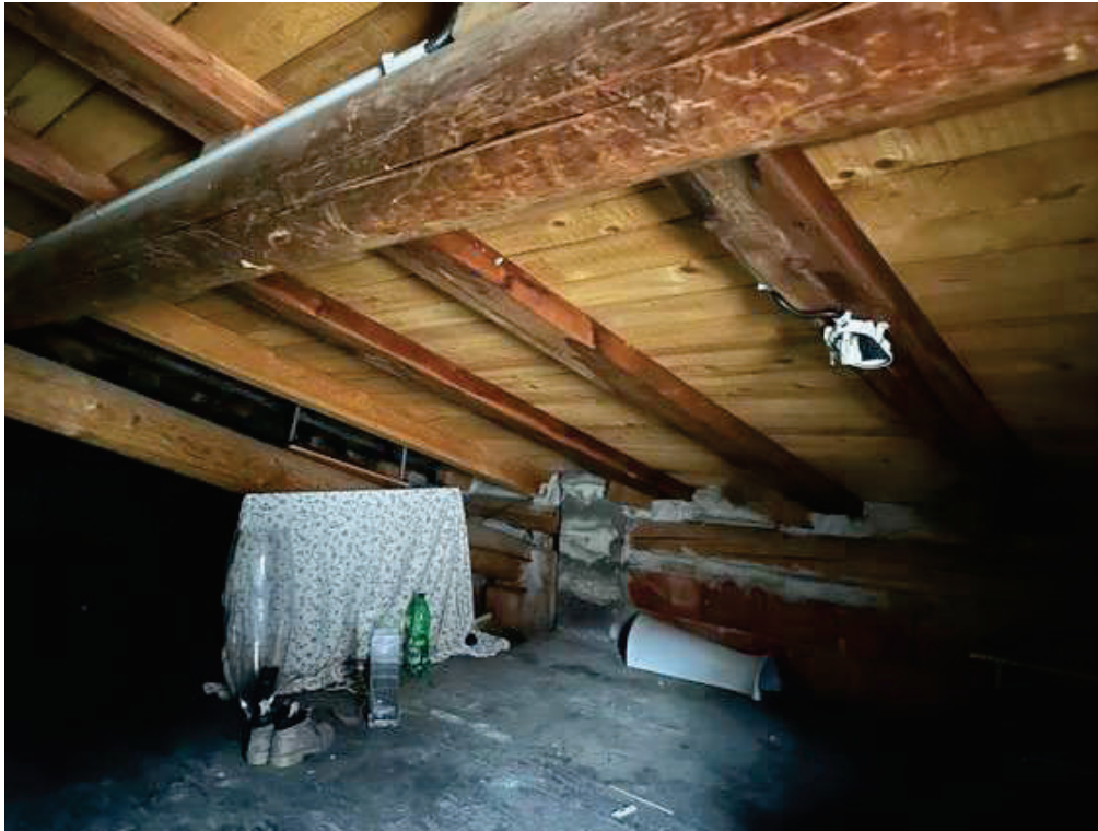
Fotografia E.37 - Solaio sottotetto_sub.15_a
