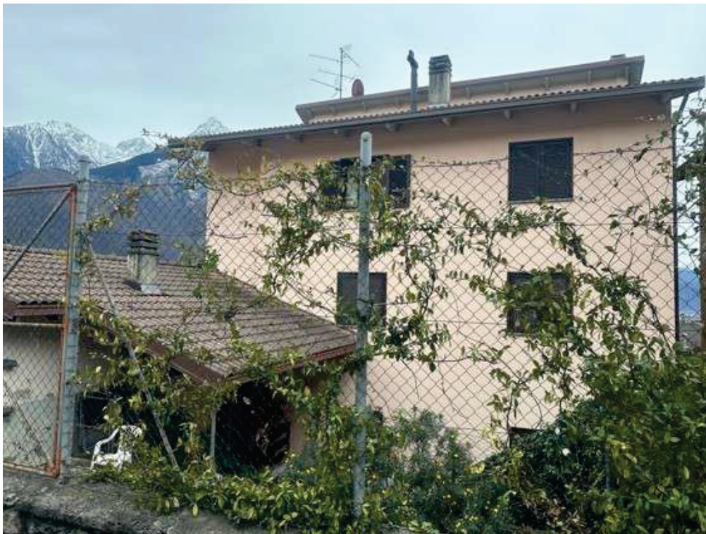
Fotografia E.4 - Fronte Nord-Ovest
