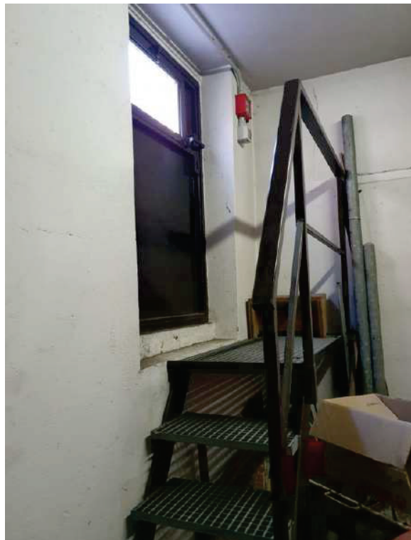
Fotografia E.54 - Centrale termica: bcnc sub.3_n
