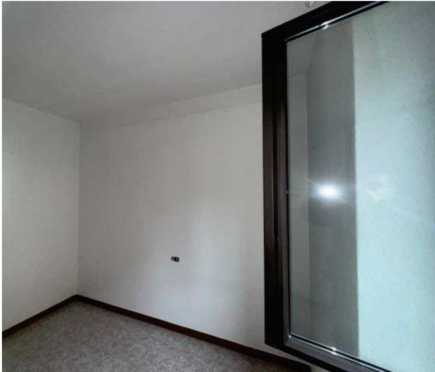
Fotografia E.17 - Appartamento piano primo: Camera_2_c
