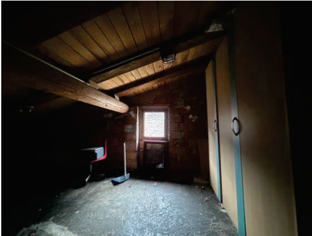
Fotografia E.39 - Solaio sottotetto_sub.15-c
