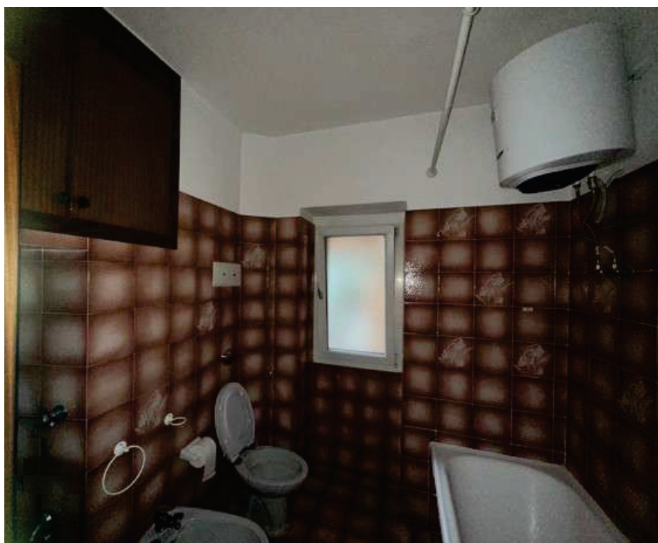
Fotografia E.28 - Appartamento piano primo: Bagno_b
