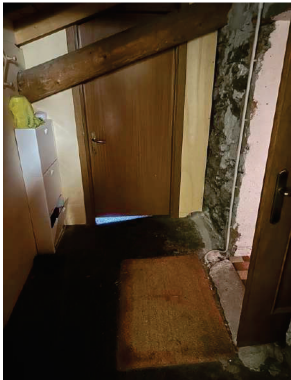
Fotografia E.36 - Disimpegno comune sub.14
