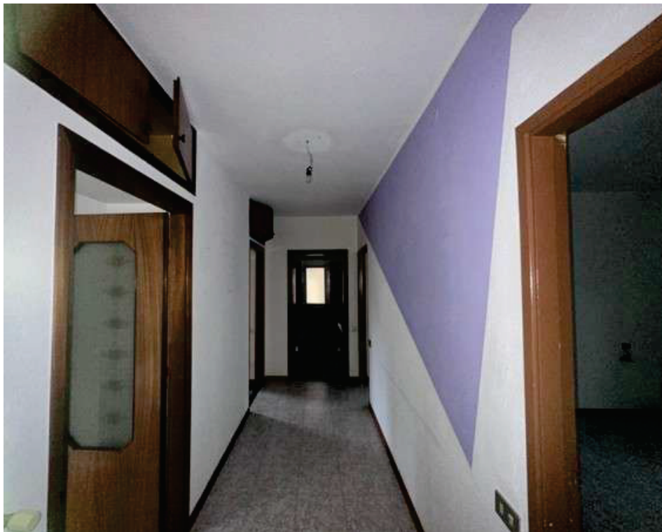
Fotografia E.10 - Appartamento piano primo: Ingresso - Disimpegno_2
