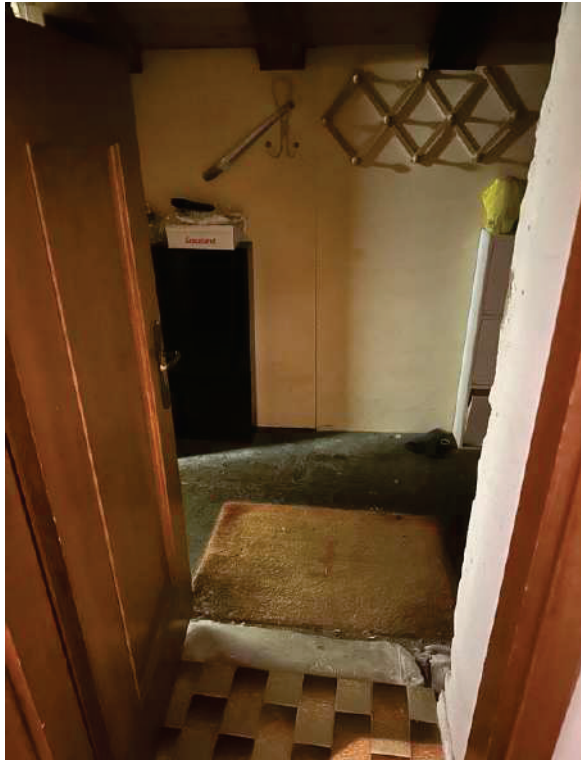
Fotografia E.35 - Ingresso solaio da vano scale (disimpegno comune sub.14)
