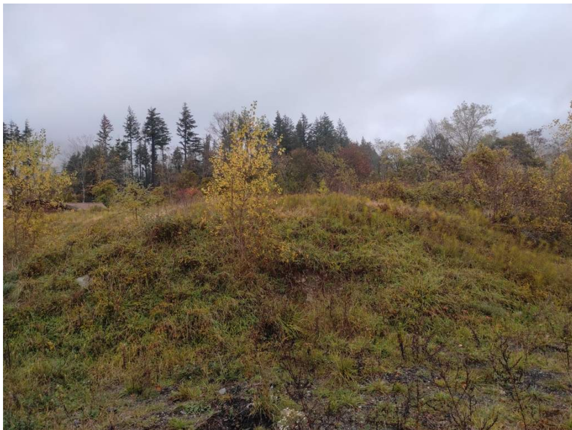
Foto 15 vista esterno – porzione terreno in esecuzione
