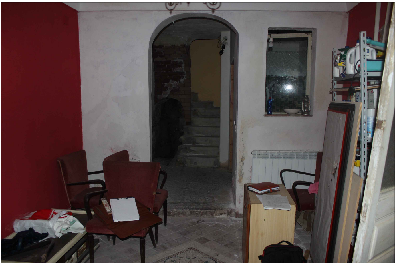
N.7 Vista Piano Terra (Ingresso)
