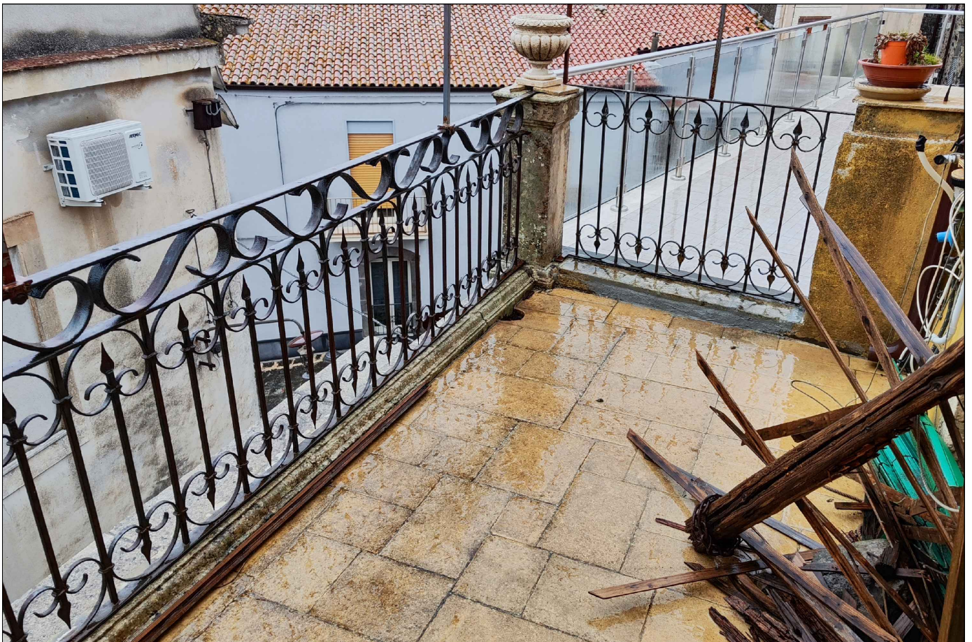
N.17 Vista Piano 2° (Terrazza)
