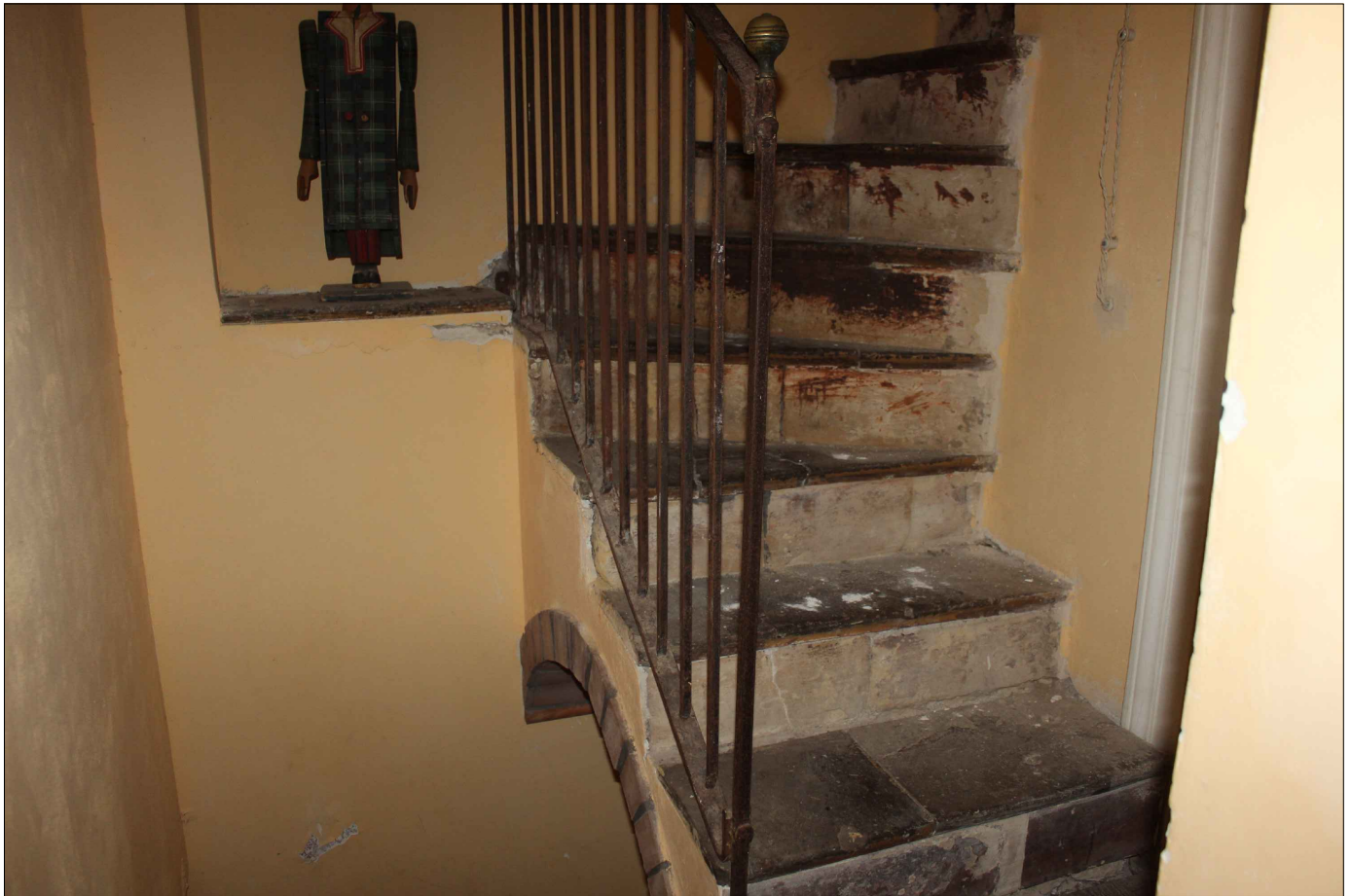
N.12 Vista Piano 1° (Vano Scala)
