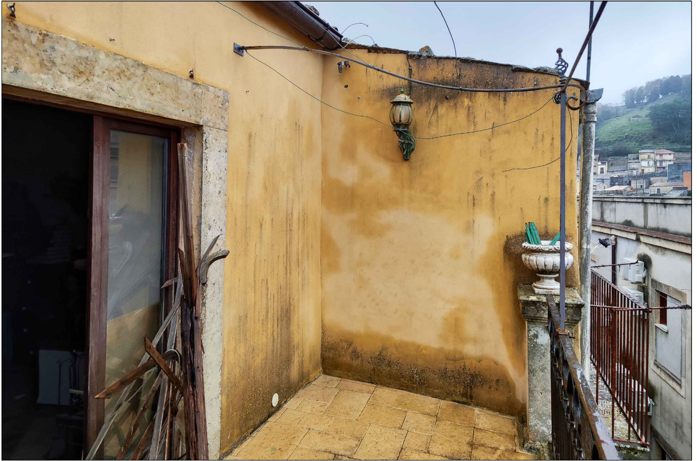
N.16 Vista Piano 2° (Terrazza)
