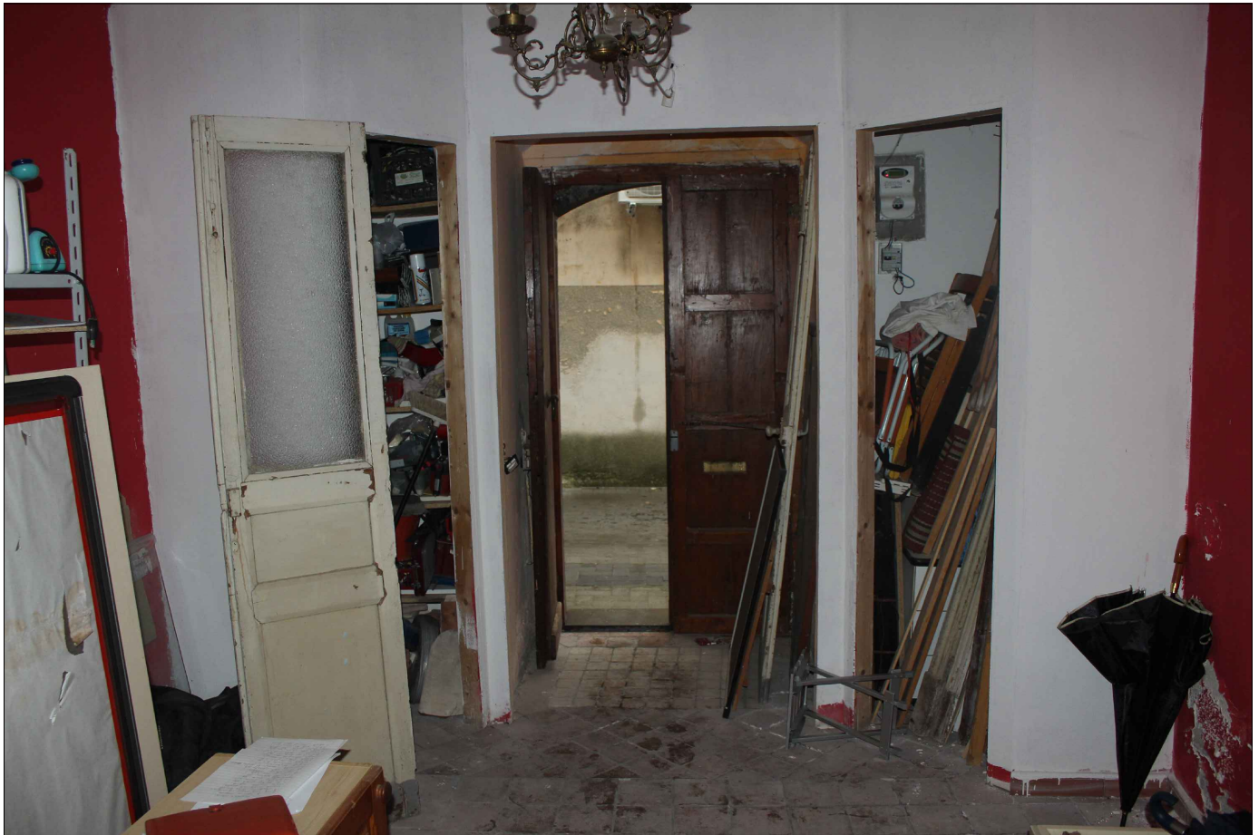
N.6 Vista Piano Terra (Ingresso)
