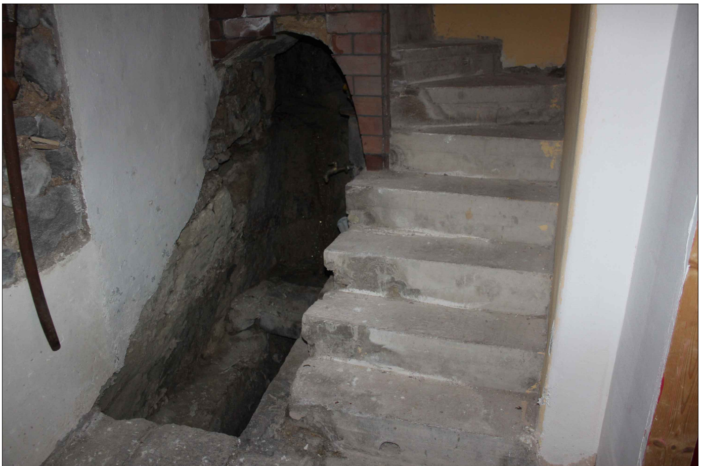
N.9 Vista Piano Terra (Vano Scala)
