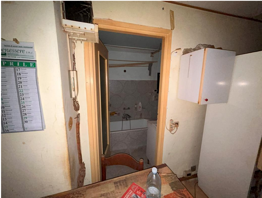
Piano Terreno - Ingresso bagno
