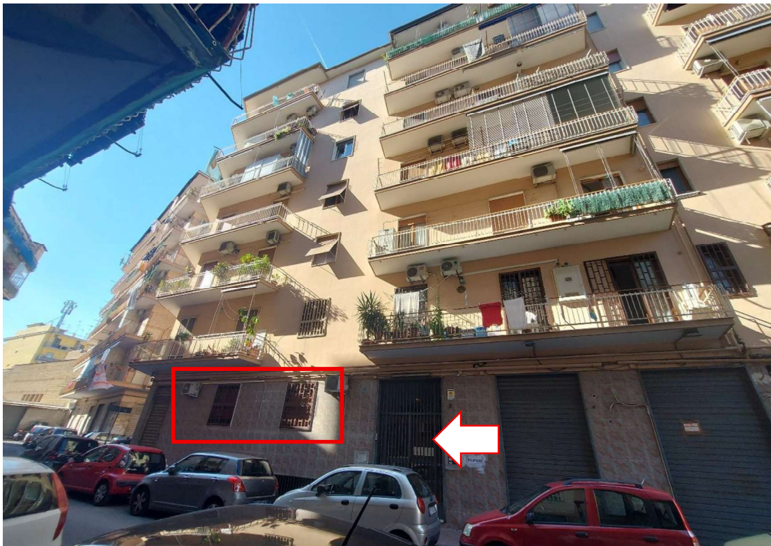
II Traversa Fosso del Lupo - Prospetto principale fabbricato – indicazione affacci cespite e accesso civ.8
