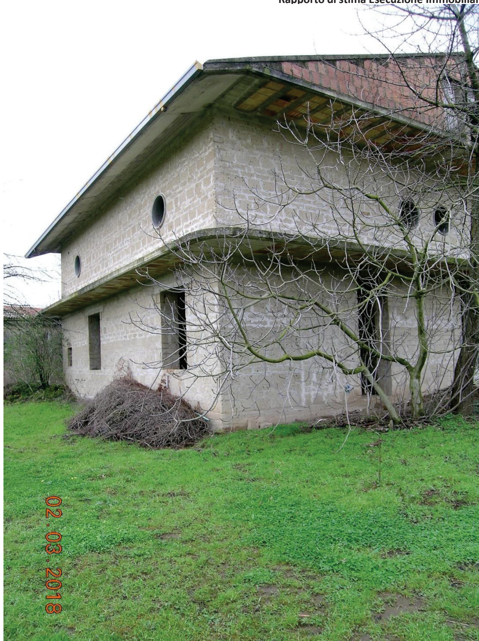
Lotto 2 Fabbricato in corso di costruzione in Airola a via Chianchetelle snc, foglio 16 p.lla 1572
