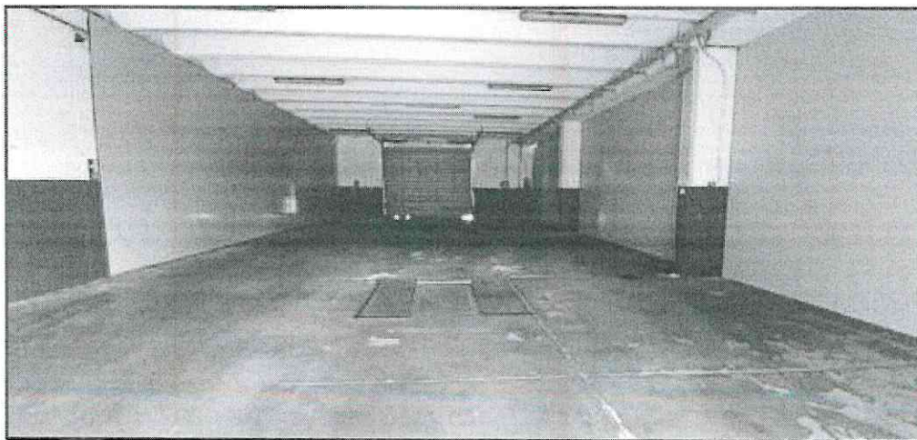
FOTO 24 INTERNO OFFICINA VUOTA SOPRALLUOGO DEL 12/11/2020
