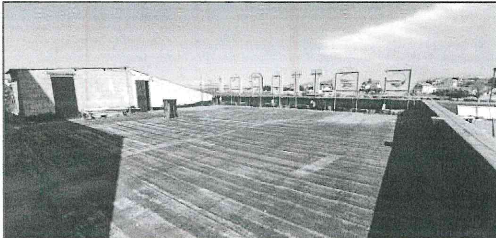
FOTO 18 TERRAZZO E MAGAZZINO AL PIANO PRIMO
