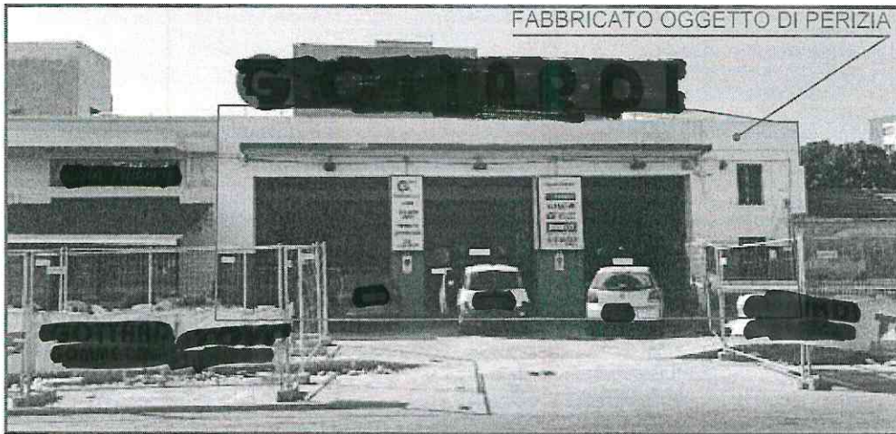
FOTO 01 OFFICINA INGRESSO DA VIA REDIPUGLIA
