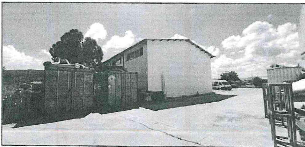
FOTO 36 CAPANNONE PICCOLO VISTA LATO OVEST
