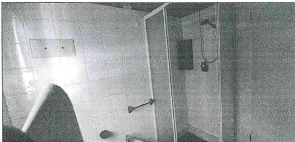
FOTO 11 BAGNO ALLOGGIO CUSTODE P.T.
