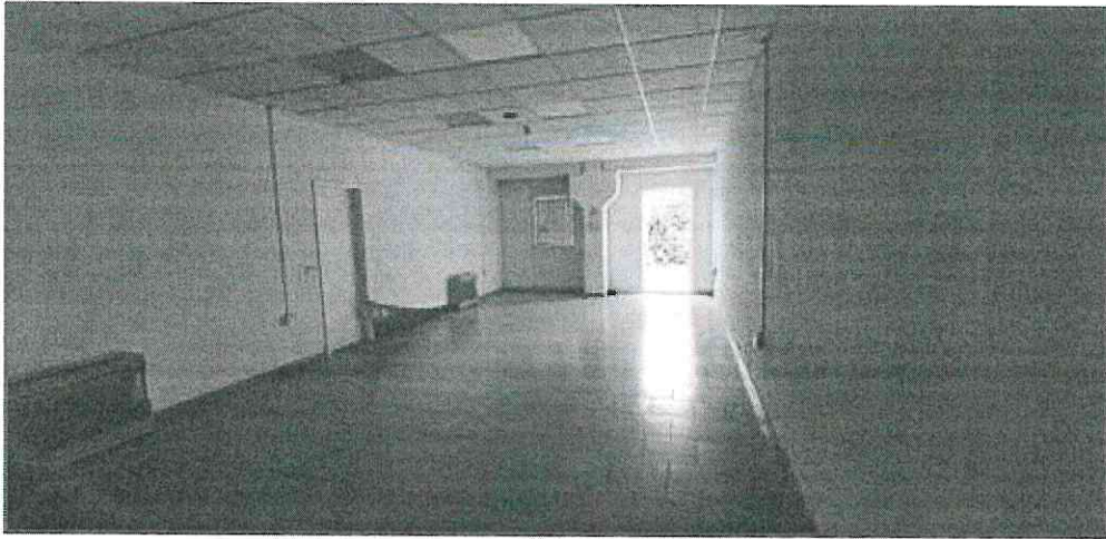
FOTO 16 EX SALA RIUNIONI P.T. SOPRALLUOGO DEL 12/11/2020
