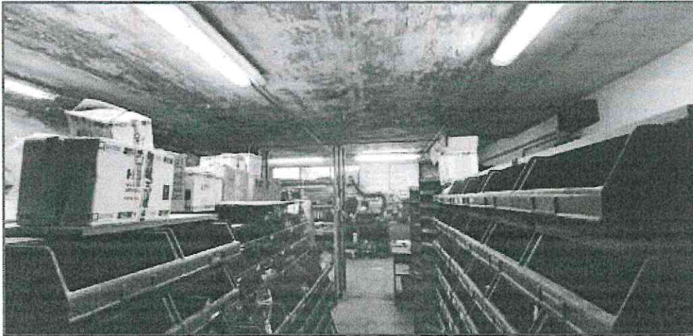
FOTO 10 LOCALE DI DEPOSITO
