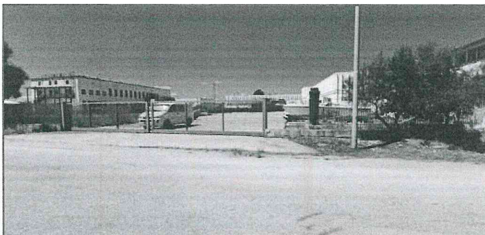
FOTO 04 INGRESSO ALL'OPIFICIO DA VIA SENEGAL N° 25 LATO EST
