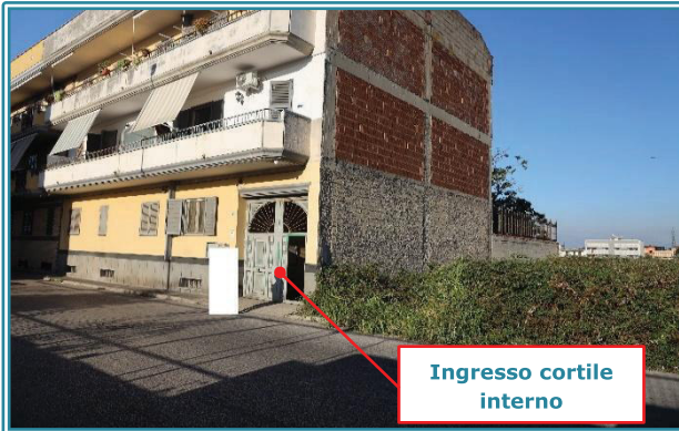
Figura 8 Vista fabbricato da Via Don Antonio Balsamo
