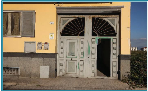
Figura 9 Ingresso al cortile comune del fabbricato
