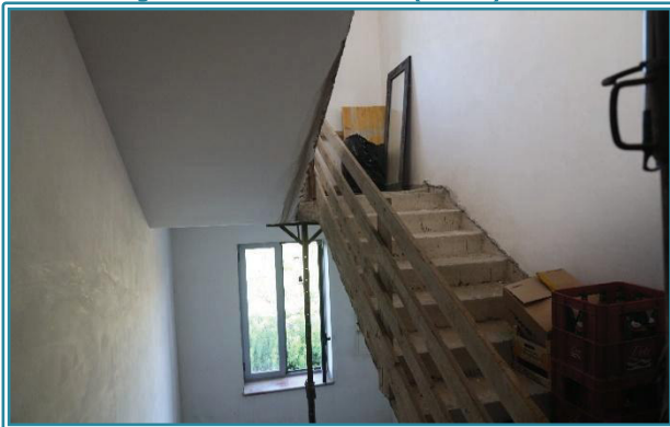
Figura 14 Scala comune allo stato grezzo (sub. 1)
