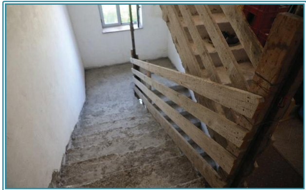
Figura 13 Scala comune allo stato grezzo (sub. 1)
