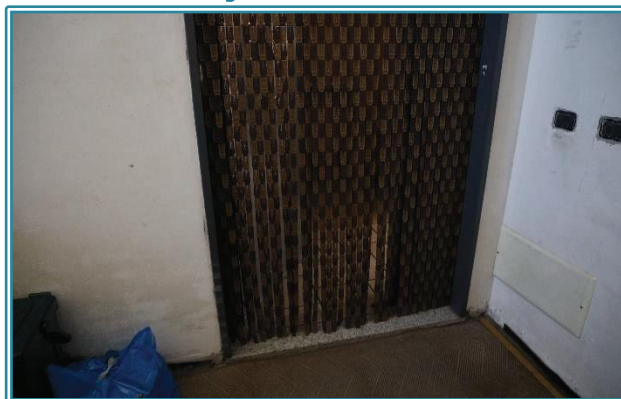
Figura 25 Accesso al terrazzo
