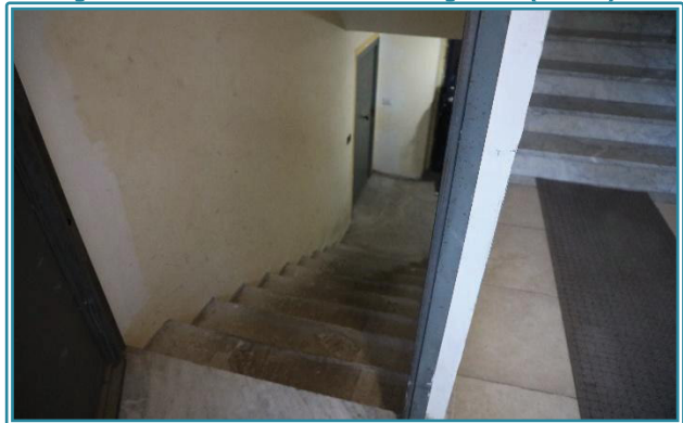
Figura 15 Scala di accesso al piano cantinato (sub. 1)
