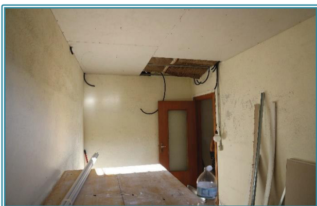
Figura 42 Cantina al piano seminterrato
