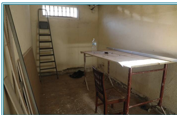
Figura 43 Cantina al piano seminterrato
