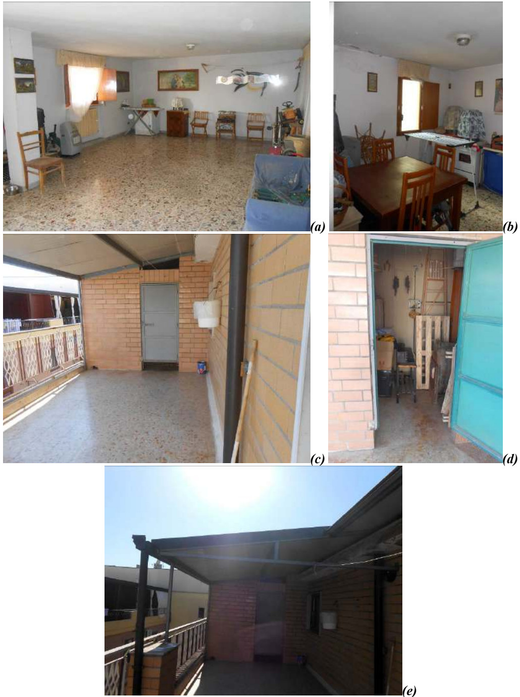
Figura n° 7. Fotografie del locale di sgombero in secondo piano: locale di sgombero (a); lavanderia (b); terrazzo (c); locale tecnico (d); copertura (e).
