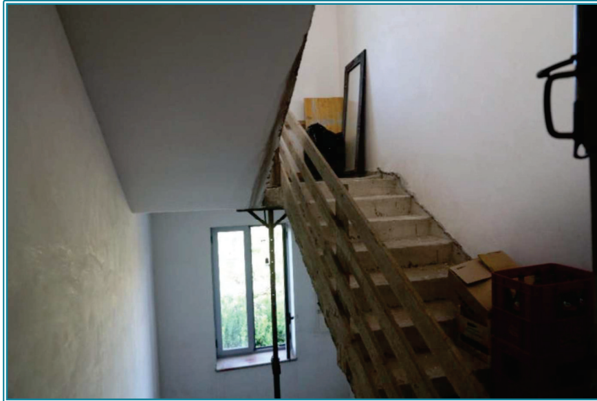
FOTO 7 - Scala comune allo stato grezzo (sub. 1)
