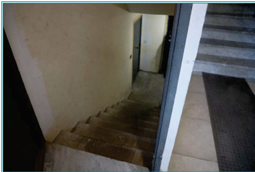
FOTO 8 - Scala comune di accesso al piano cantinato (sub. 1)
