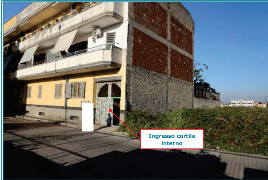
FOTO 1 - Vista fabbricato da Via Don Antonio Balsamo
