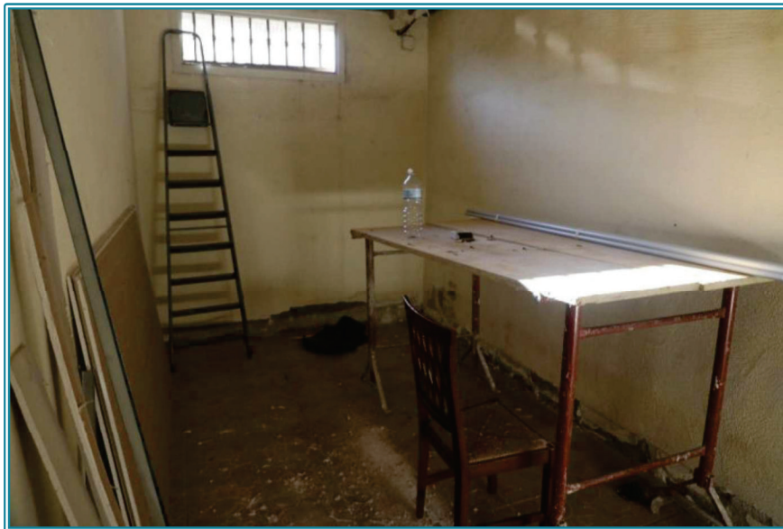
FOTO 32 - Cantina al piano seminterrato
