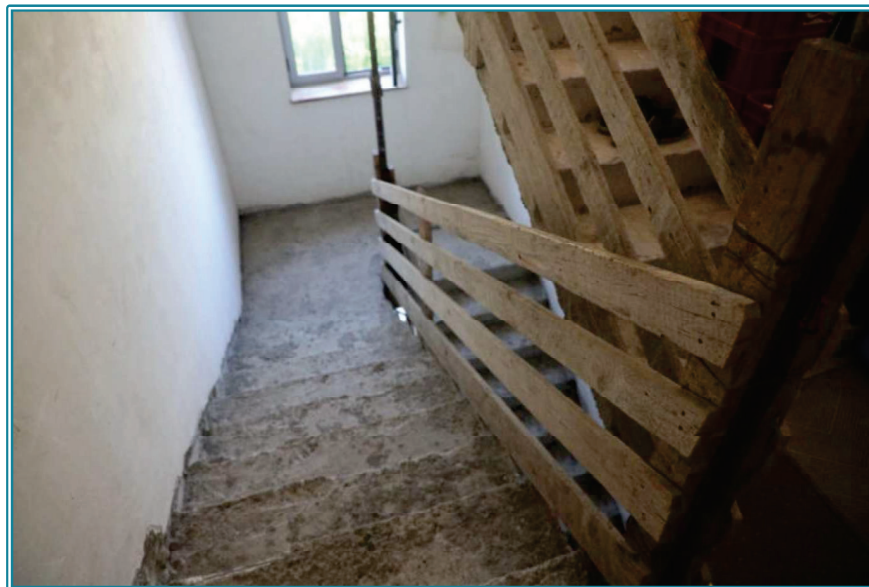
FOTO 6 - Scala comune allo stato grezzo (sub. 1)
