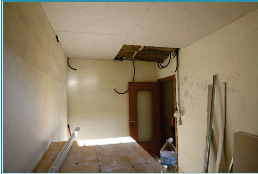
FOTO 31 – Cantina al piano seminterrato
