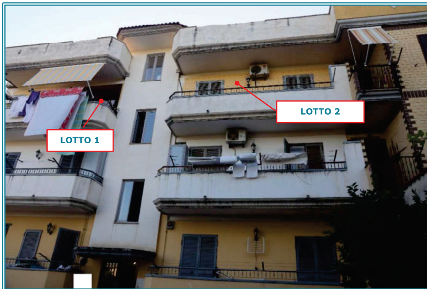
FOTO 4 - Vista dal cortile comune (sub. 1)
