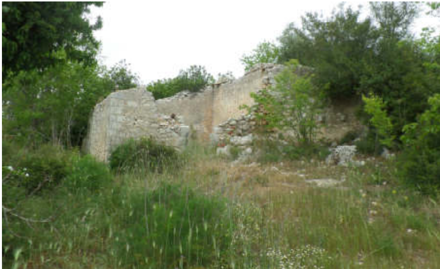
Foto n° 5.5. C.da Piana. Fg. 30, P.lla 105
