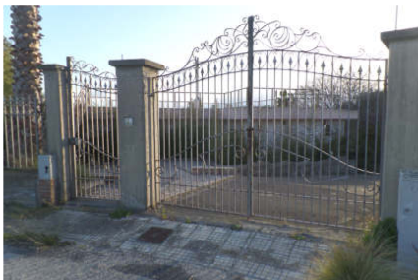
Foto n° 02. Augusta. Via Brenta n° 6
