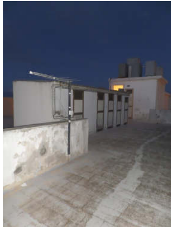
Foto n° 8.12. P. 4°: Terrazza posteriore: ripostigli
