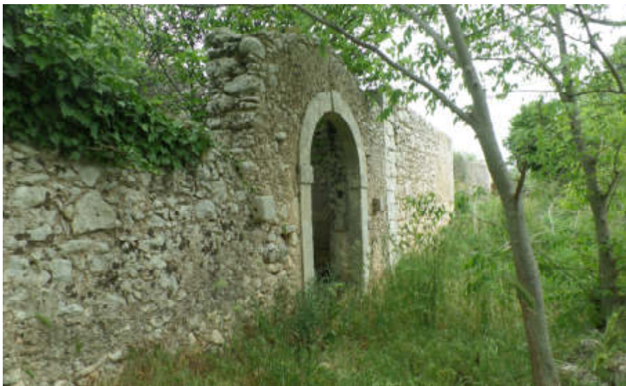
Foto n° 5.6. C.da Piana. Fg. 30, P.lla 105: Muro corte
