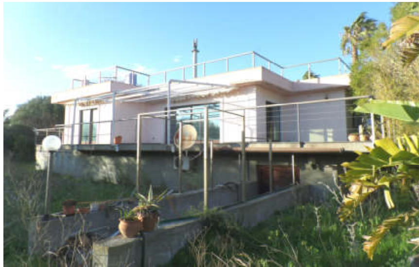
Foto n° 04. Villino: vista Sud-Est
