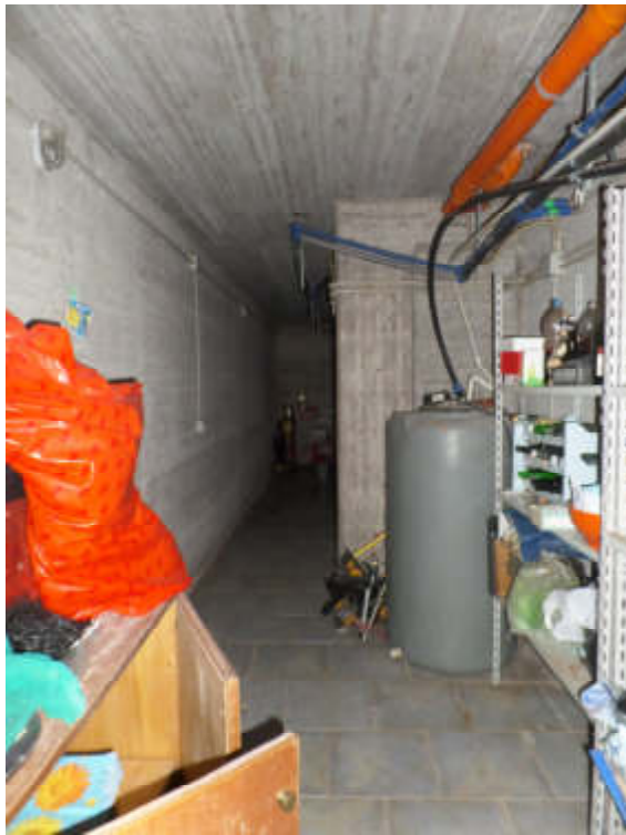
Foto n° 1.13. P. SI. Cavedio lato Est
