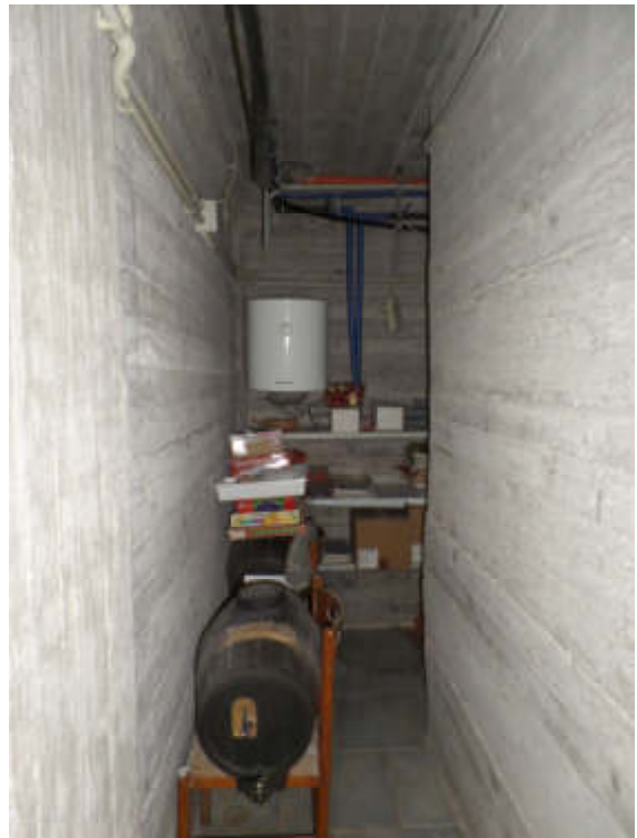
Foto n° 1.14. P. SI. Cavedio lato Est
