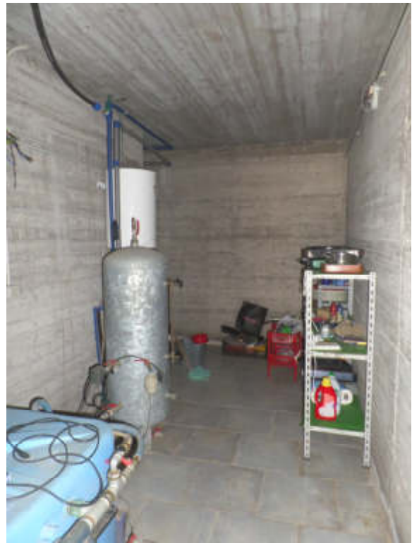
Foto n° 1.12. P. S1. Cavedio lato Sud
