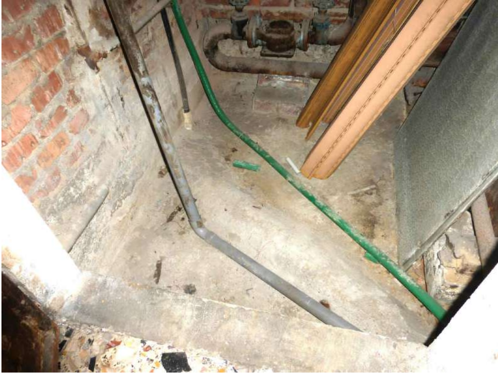
Ex centrale termica condominiale (PT)
