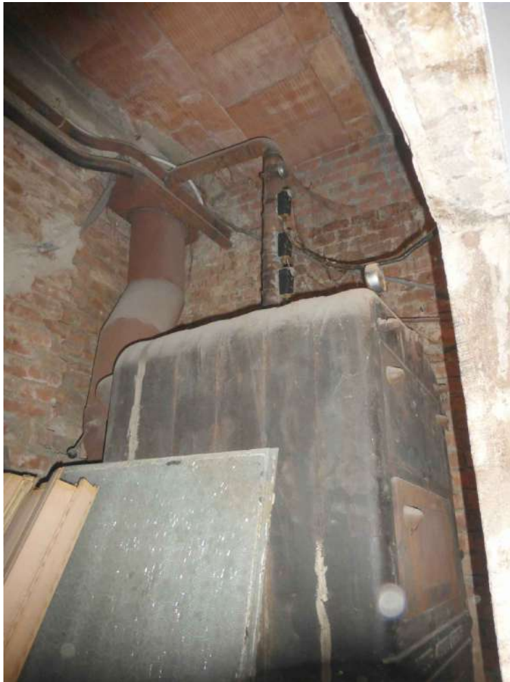
Ex centrale termica condominiale (PT)
