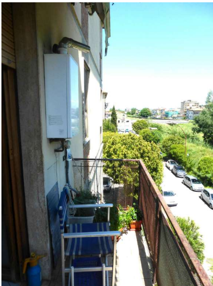
balcone lato strada
