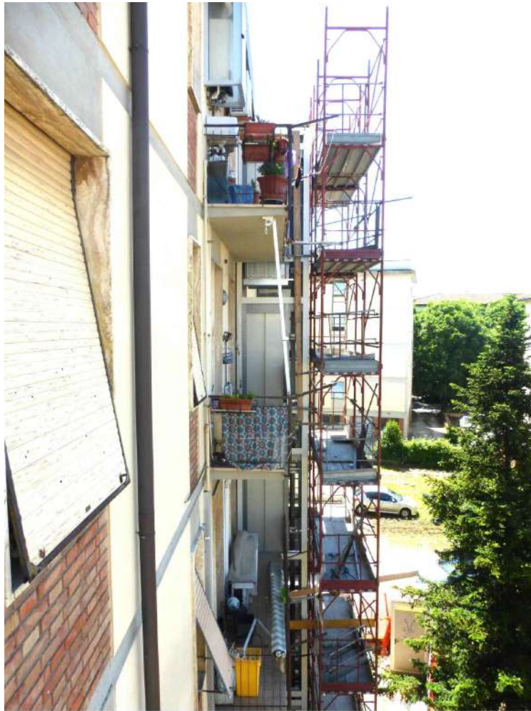
ascensore esterno in corso di installazione
