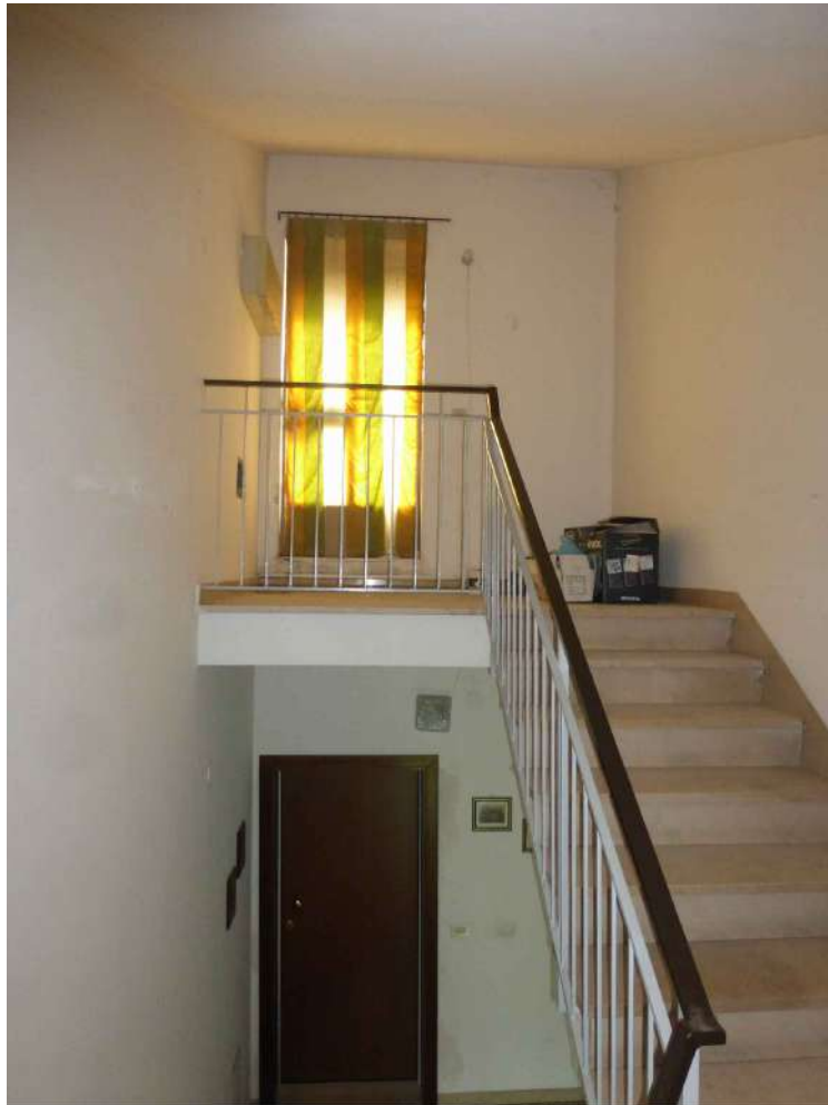
Vano scala (accesso al lastrico solare)
