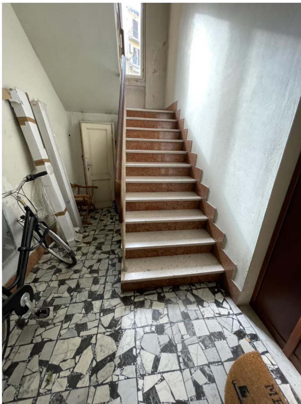
FOTO N. 2 – VISTA SSU VANO SCALA CONDOMINIALE
