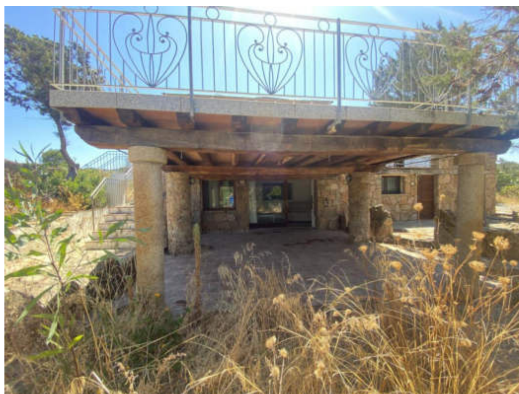
FOTO (12) prospetto Ovest
