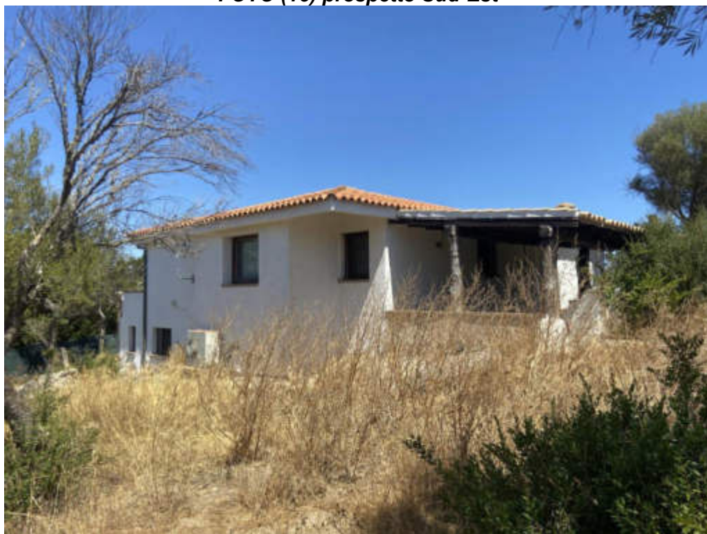
FOTO (15) prospetto Sud-Est
