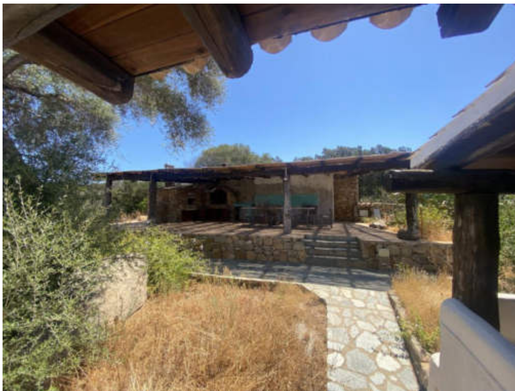
FOTO (17) prospetto Ovest
