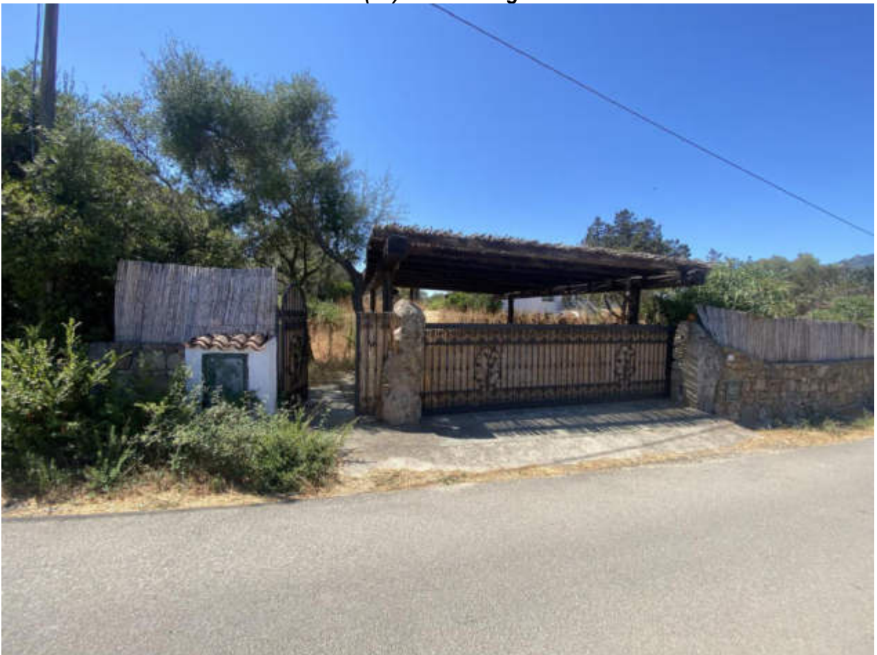
FOTO (23) Cancelli ingresso
