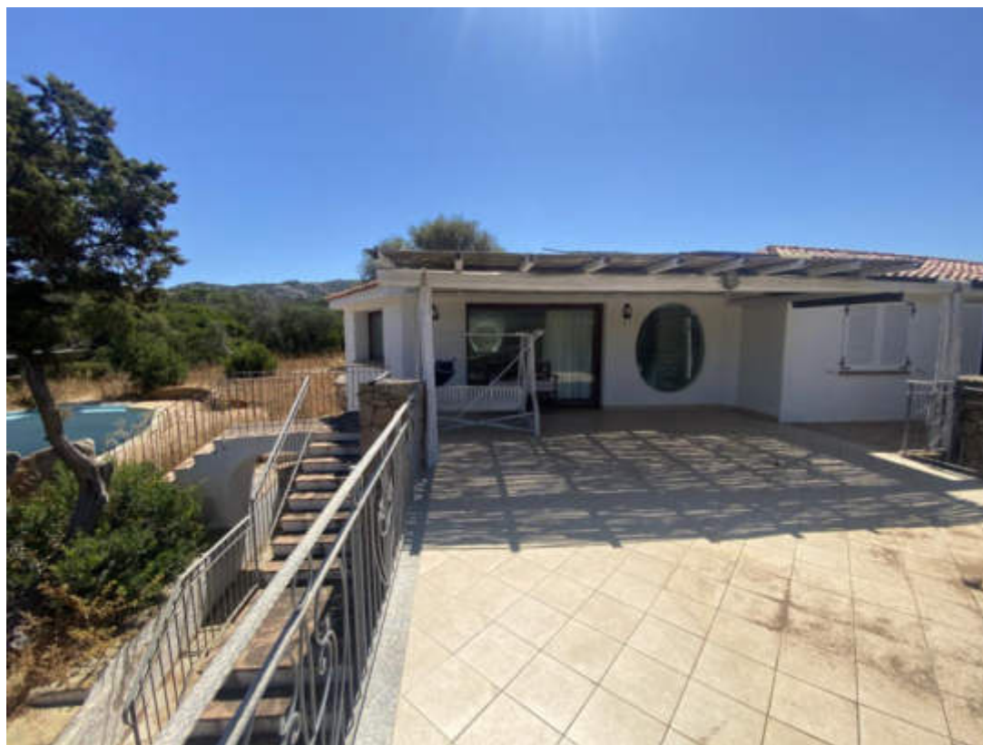
FOTO (19) prospetto Ovest
