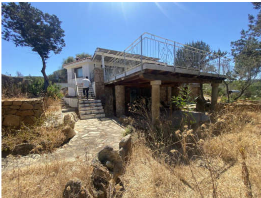
FOTO (11) prospetto Ovest
