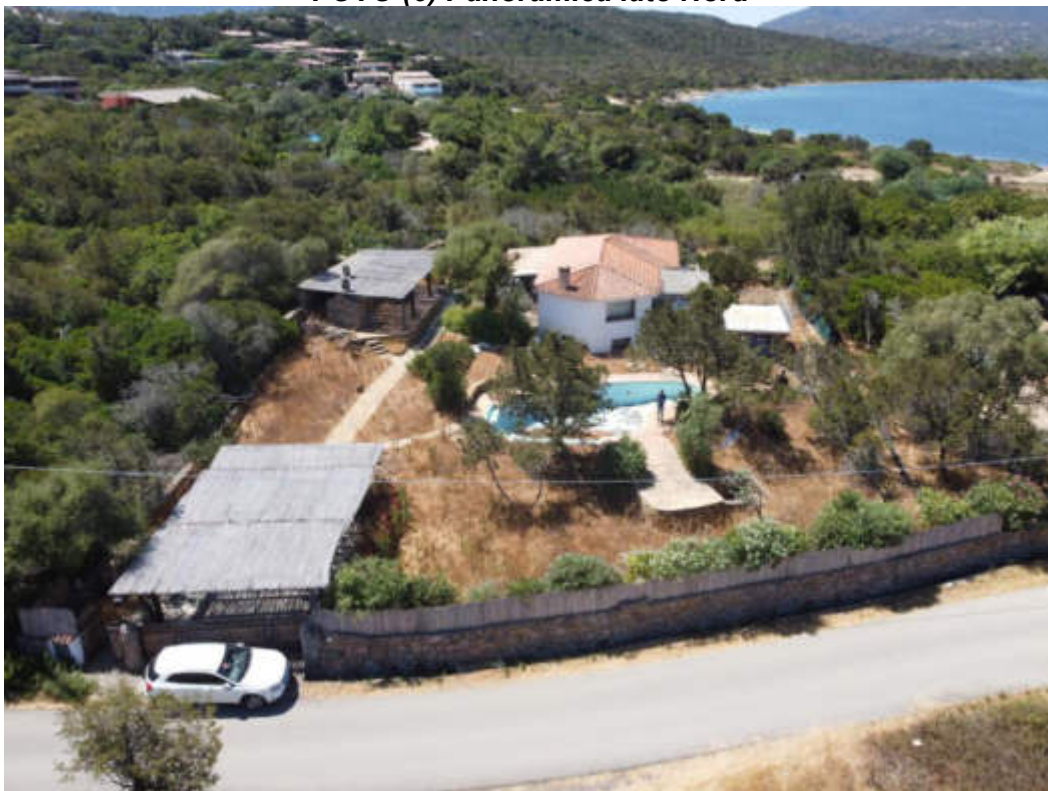
FOTO (6) Panoramica lato Nord
