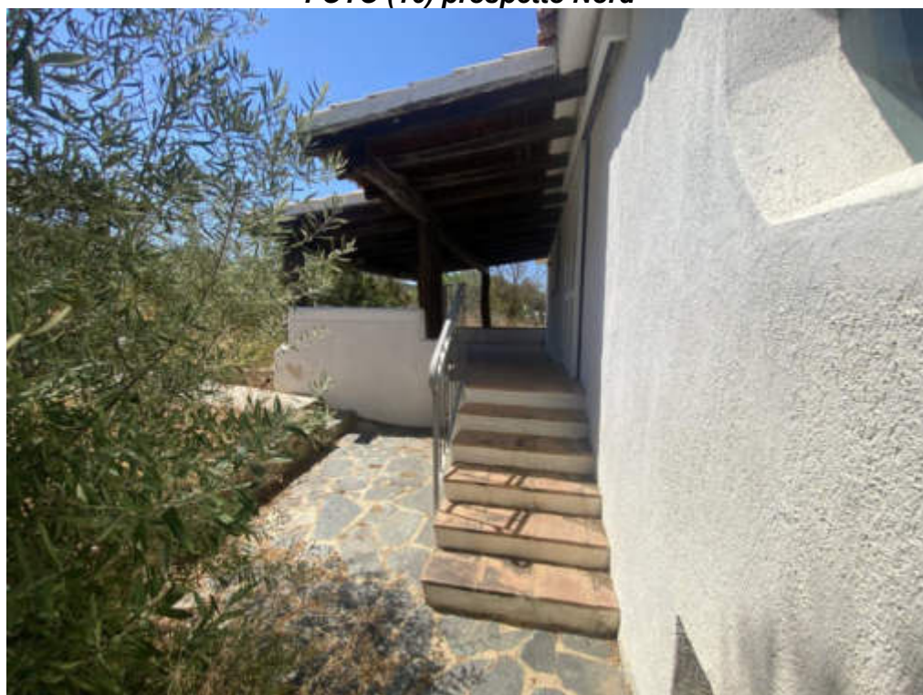
FOTO (16) prospetto Nord
