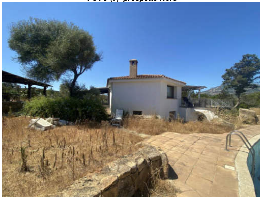
FOTO (7) prospetto Nord
