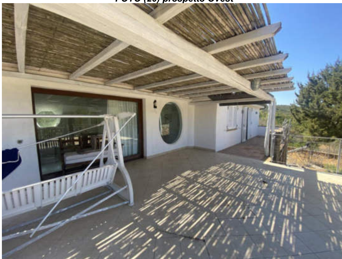
FOTO (20) prospetto Ovest
