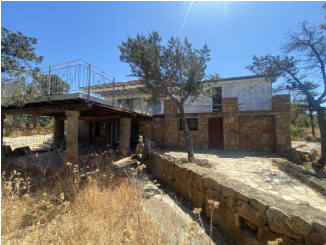
FOTO (13) prospetto Ovest
