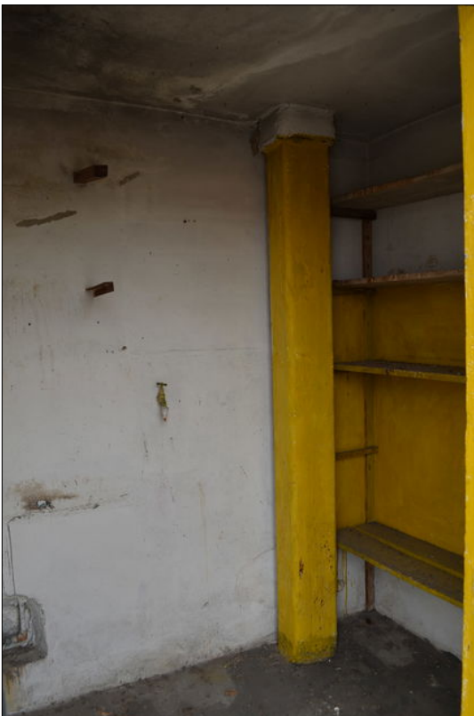
Vista N ripostiglio
