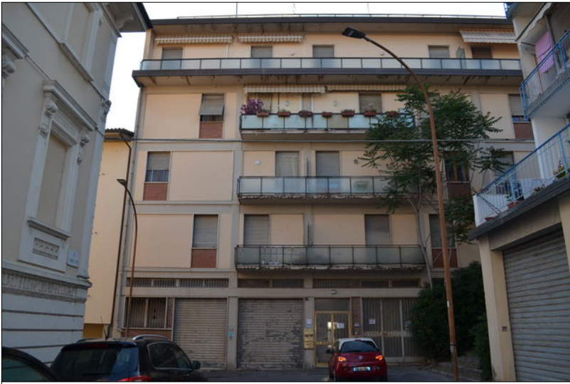
Vista A esterno del fabbricato in oggetto
