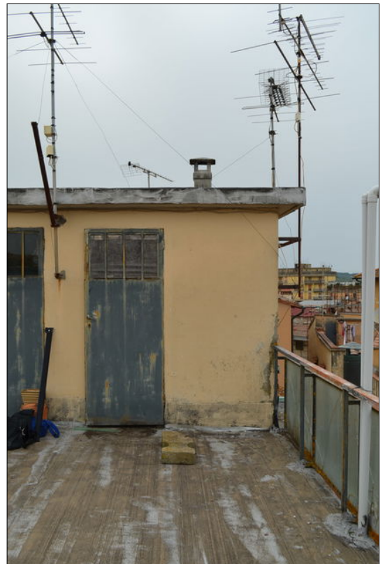
Vista M esterno del ripostiglio
