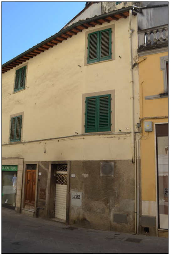
Vista B esterno del fabbricato in oggetto
