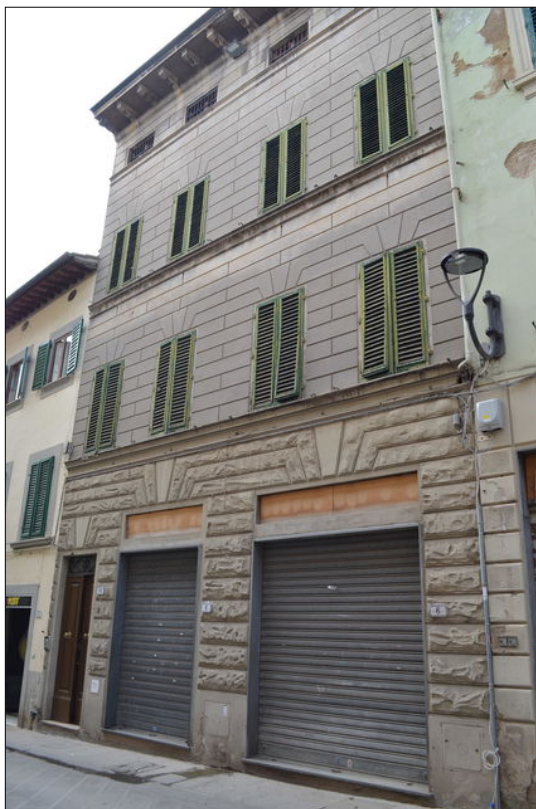
Vista A esterno del fabbricato in oggetto
