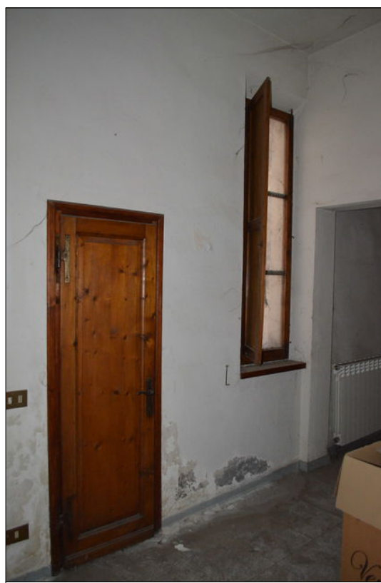
Vista B ingresso
