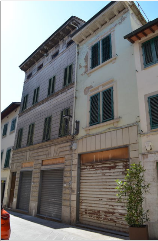
Vista A esterno del fabbricato in oggetto
