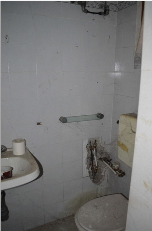
Vista D bagno
