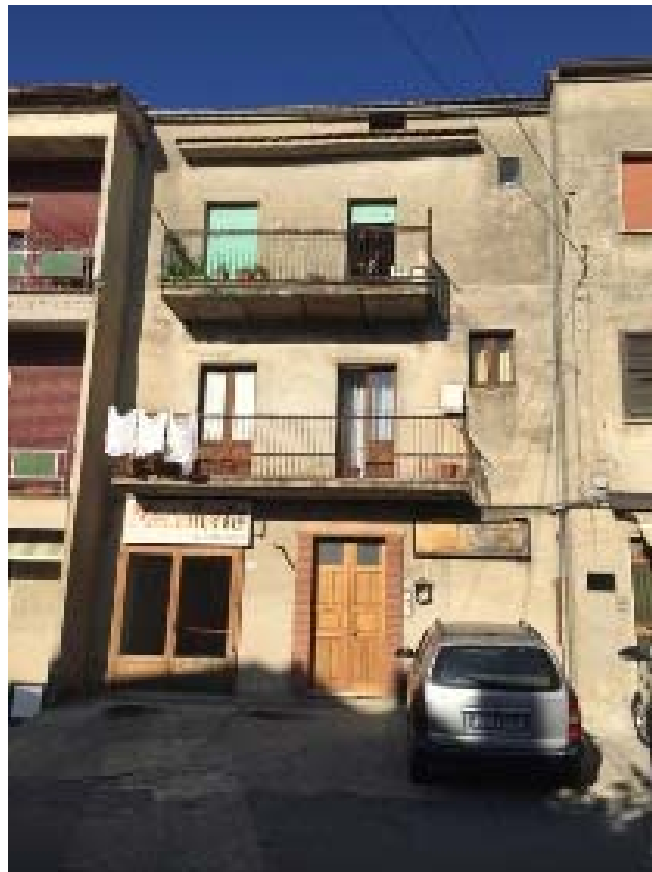
Prospetto su via Principe di Piemonte
