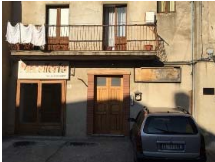
Prospetto su via Principe di Piemonte
