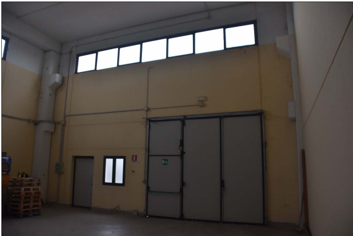
FOTO N.5: Particolare interno capannone (zona a doppia altezza)
