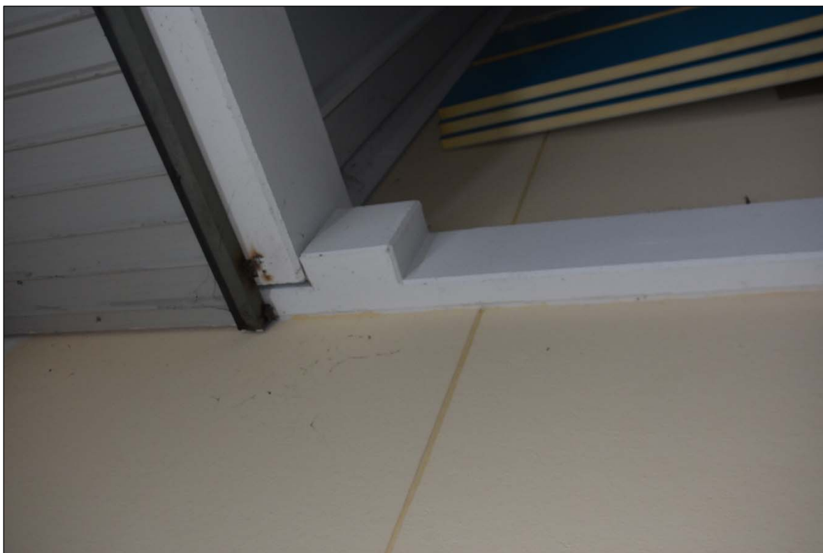
FOTO N. 9: Particolare struttura prefabbricata del capannone
