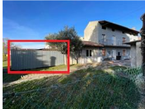
Box in lamiera a ridosso del fabbricato di abitazione.
