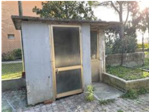
Accessorio staccato dal fabbricato principale.
