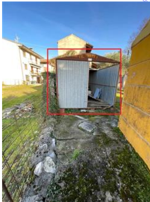
Box in lamiera a ridosso del fabbricato di abitazione.
