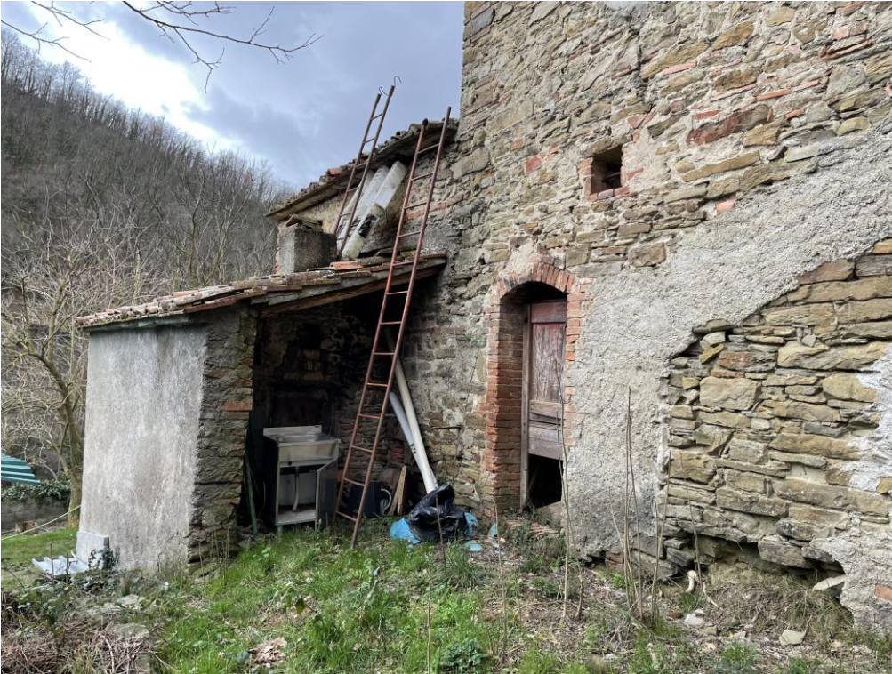
Fronte lato est dell'edificio per abitazione – accesso alla cantina piano terra
