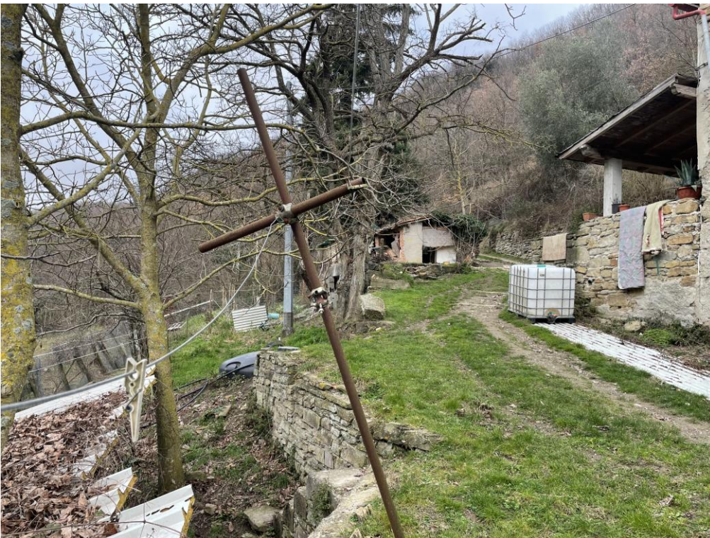
Resede antistante il lato sud dell'edificio per abitazione
