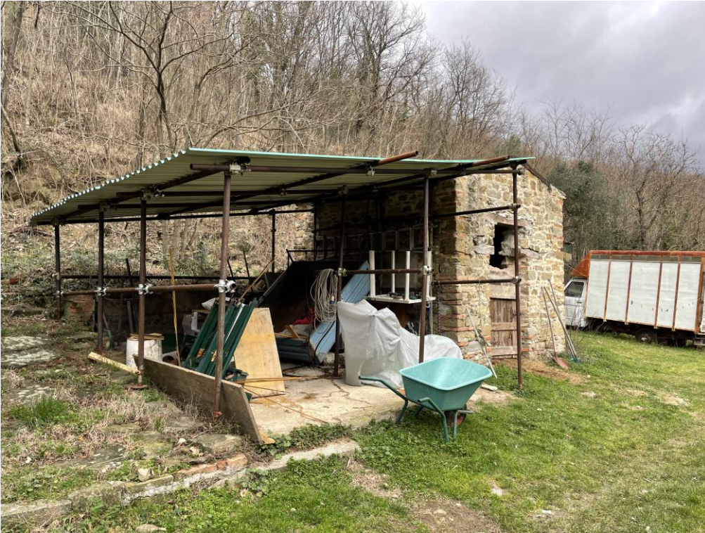
Fronte lato sud del fabbricato isolato (essicatoio)
