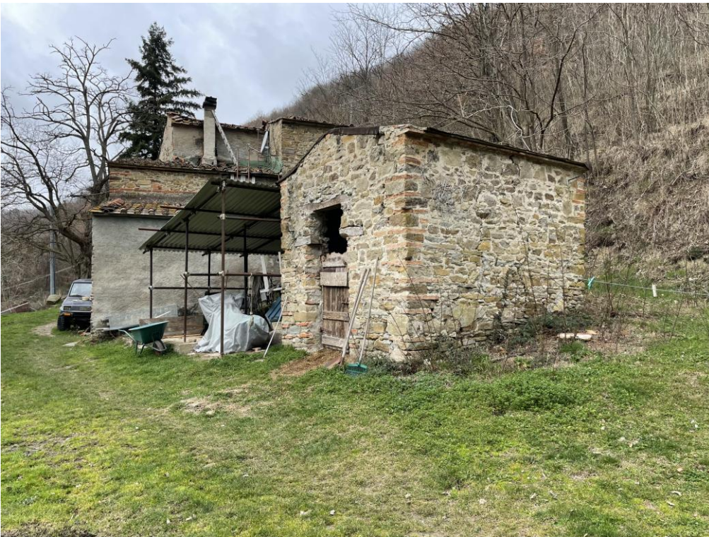
Complesso edilizio lato est
