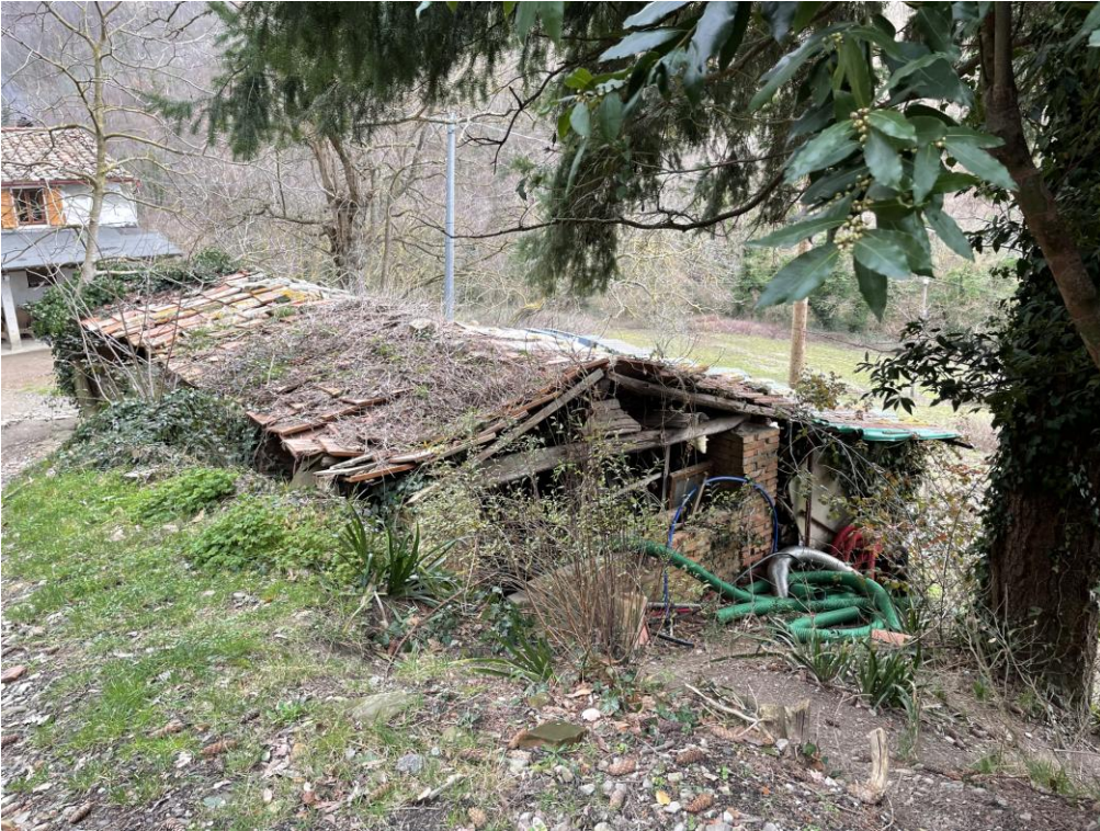
Loggia esterna vista dal cancello d'ingresso alla proprietà
