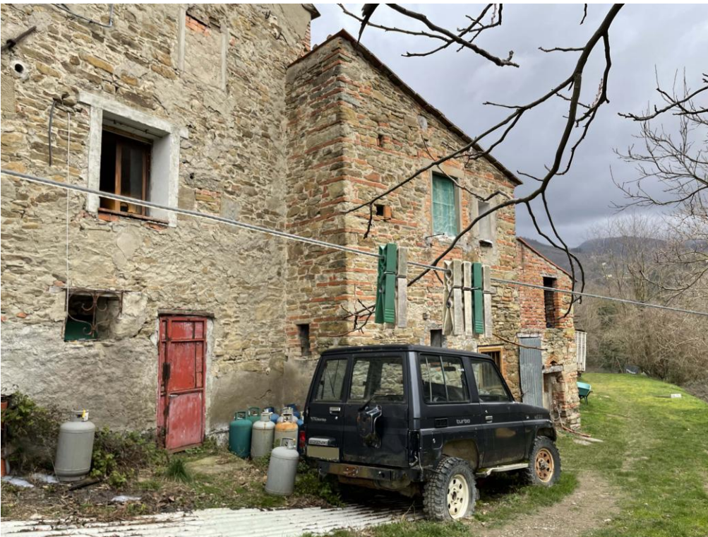
Fronte lato sud dell'edificio per abitazione – accessi alle cantine nel seminterrato
