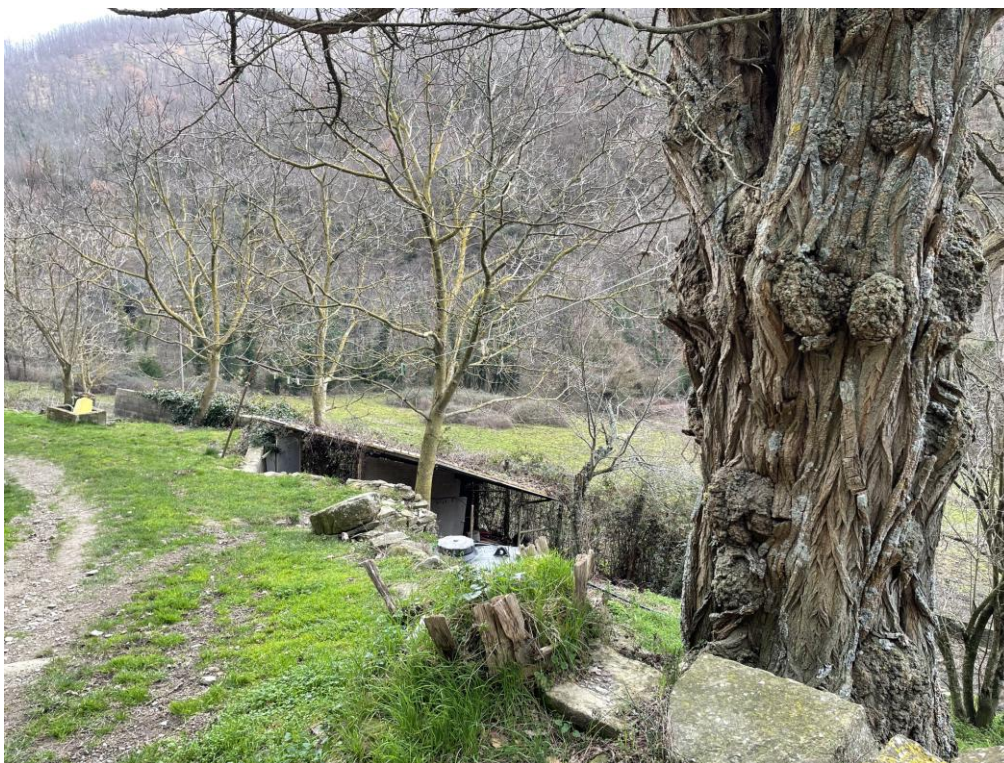
Resede antistante il lato sud dell'edificio per abitazione
