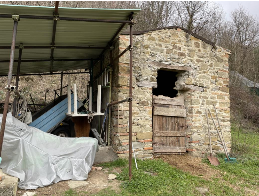
Fronte lato sud del fabbricato isolato (essicatoio)
