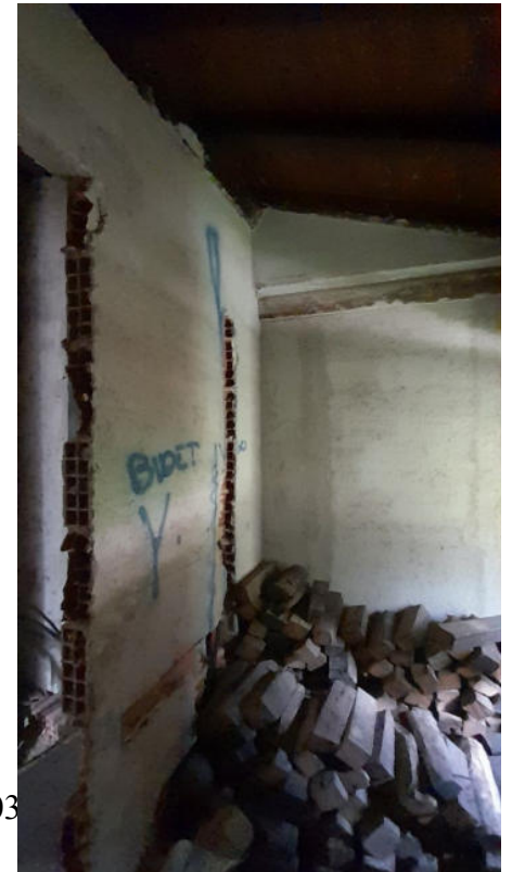
F.07 Bagno al grezzo
