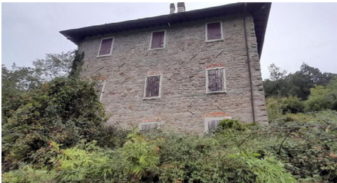
APPARTAMENTO ) Foto 1 – Fabbricato via di Bucigna nuova
