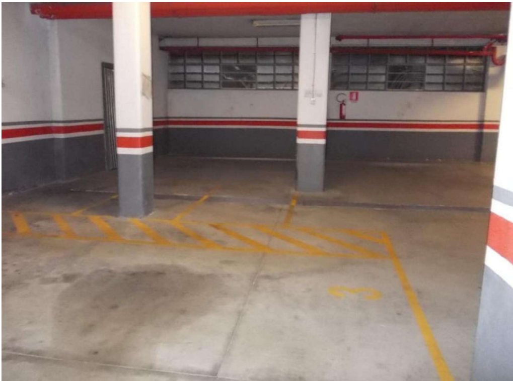
Foto 4 Interno Autorimessa mapp.5404 sub.51 p.S1
