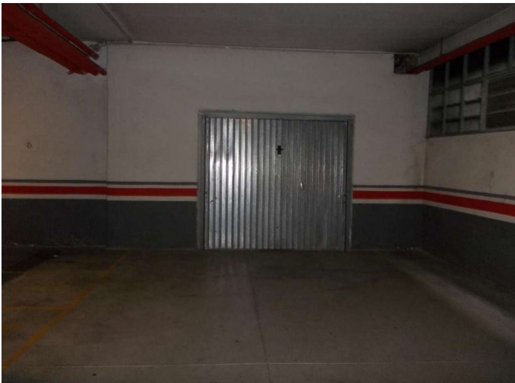
Foto 6 Interno Autorimessa mapp.5404 sub.51 p.S1
