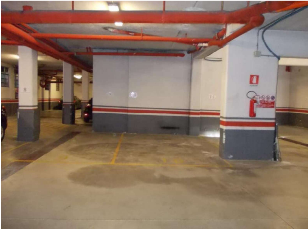
Foto 5 Interno Autorimessa mapp.5404 sub.51 p.S1
