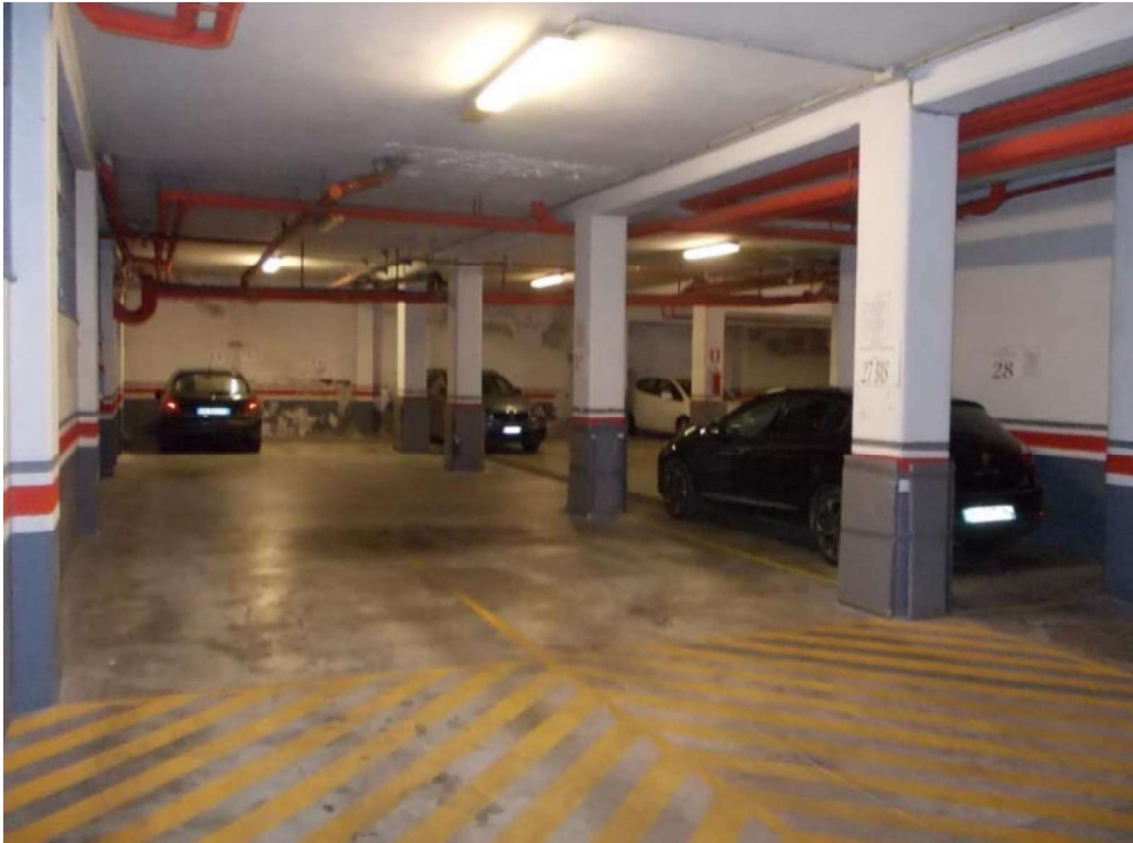
Foto 7 Interno Autorimessa mapp.5404 sub.51 p.S1
