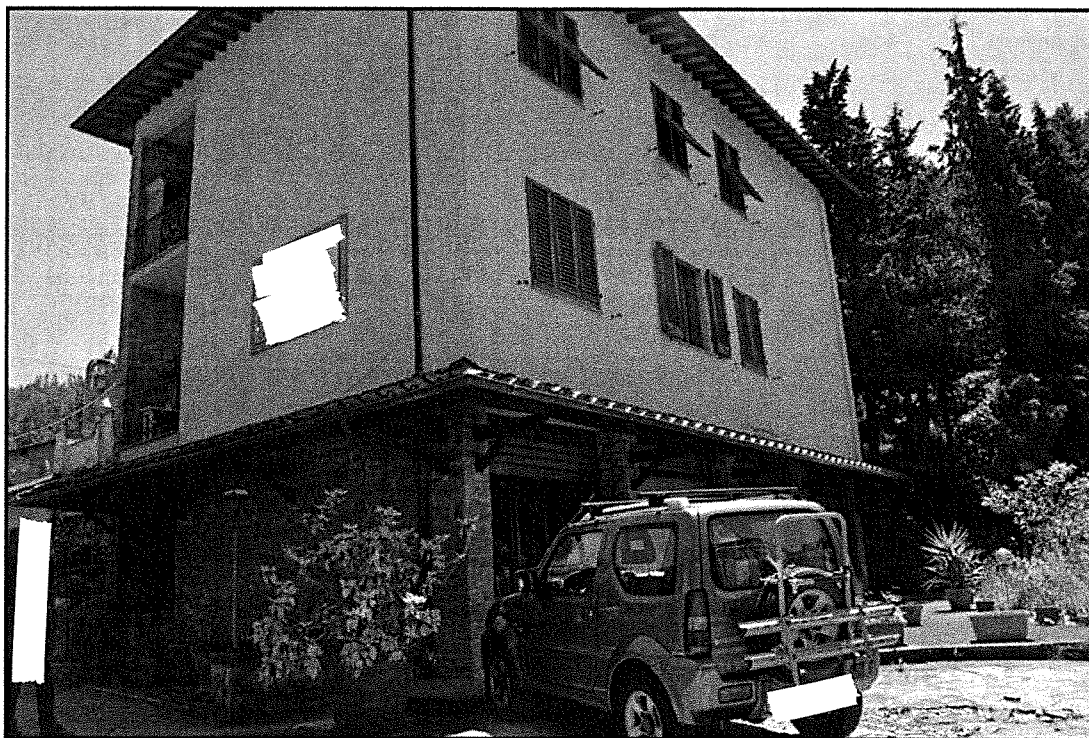
Fotografia n. 3 Particolare della facciata su via B. Berenson
