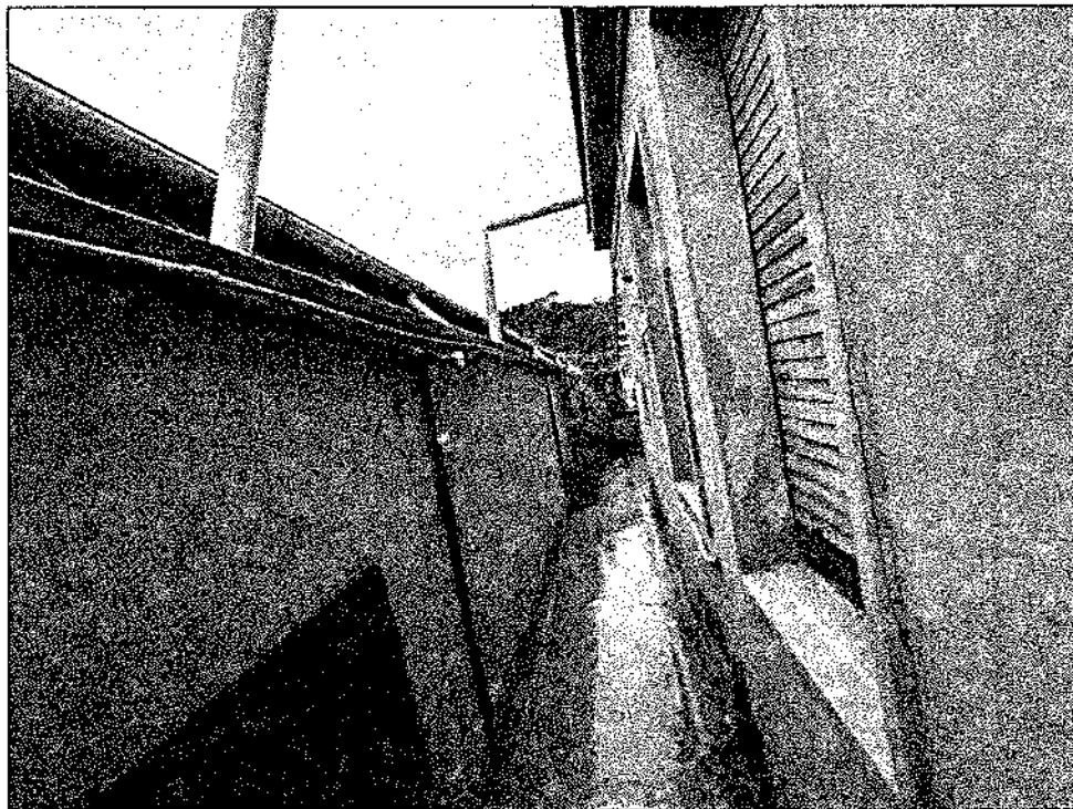
Fotografia 11: Sub. 510 - Corridoio esterno di accesso
