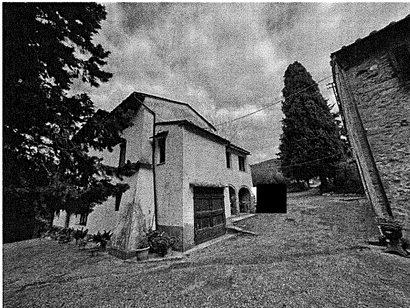
Foto n. 27, vista ingresso garage:
