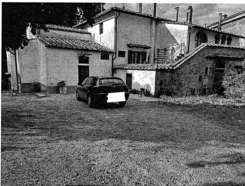
Foto n. 3, vista esterna del fabbricato e della resede comune;
