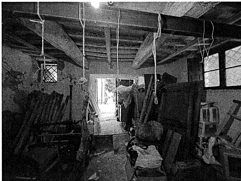
Foto n. 28, vista interna del garage:
