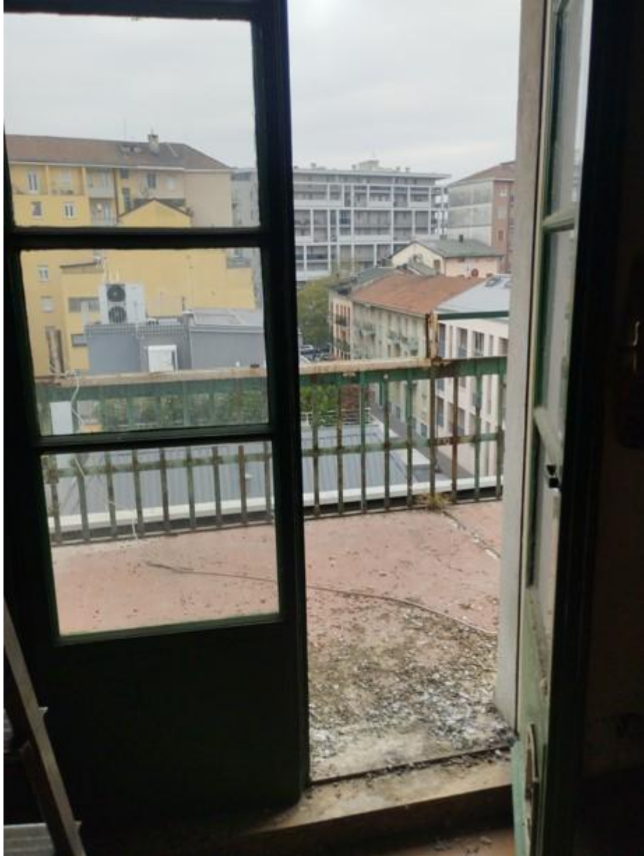
Accesso alla terrazza
