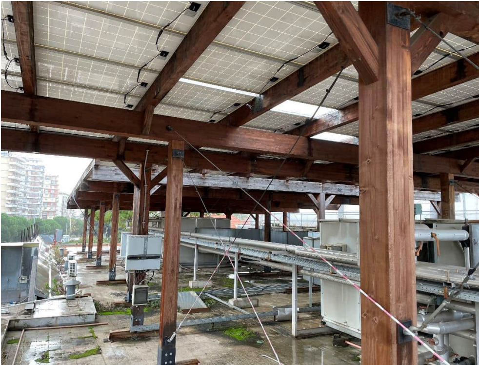
Figura 7: Porzione su tettoia
