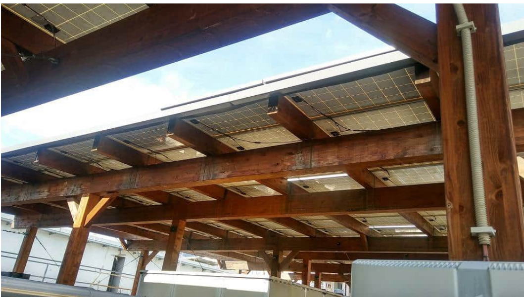
Figura 6: Porzione su tettoia
