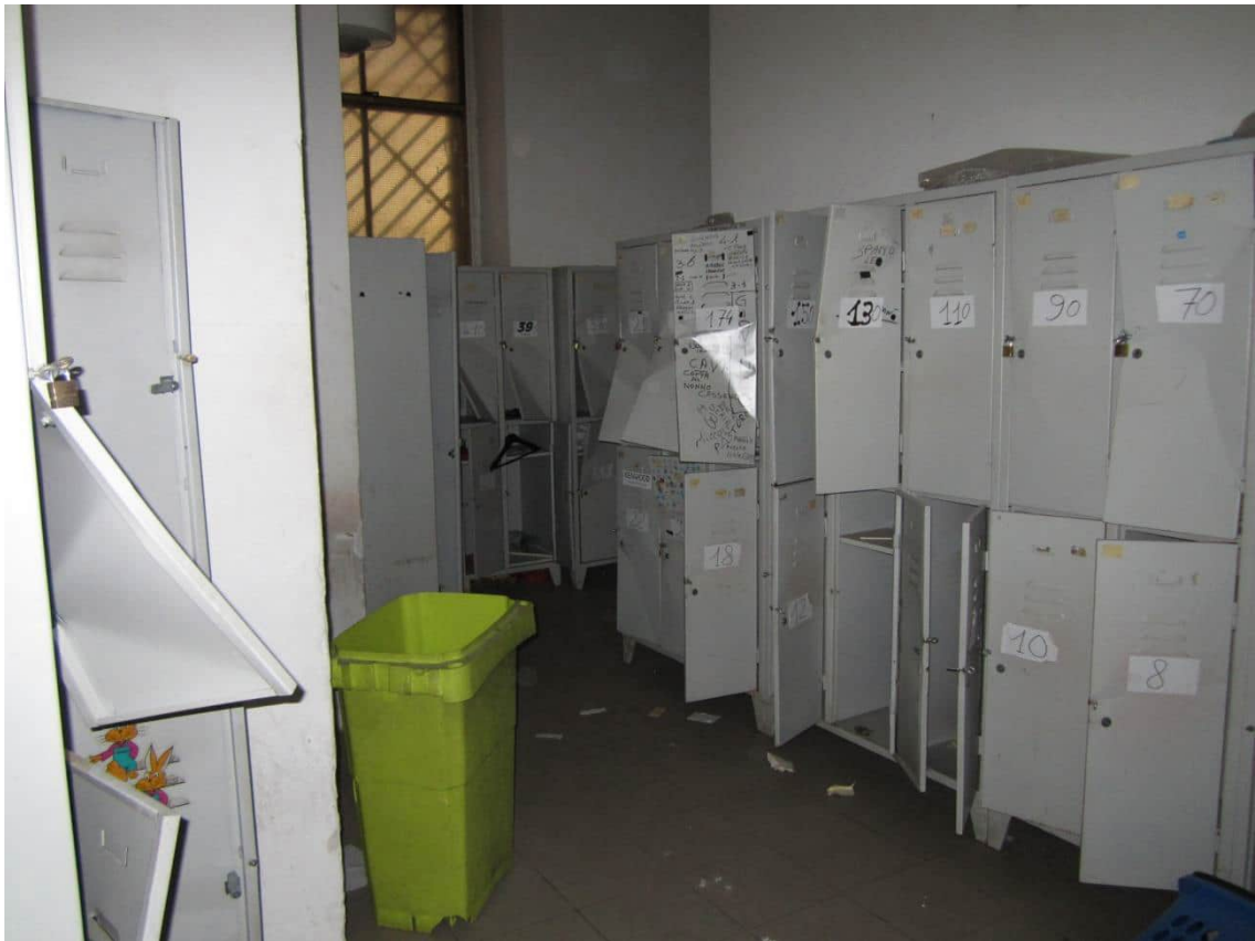
Foto 9: gli spogliatoi, nell'area di servizio a sinistra dell'area d'ingresso
