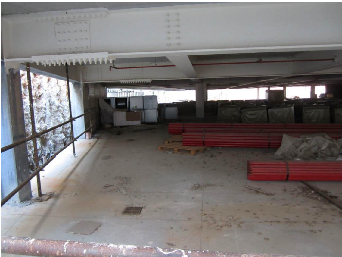
Foto 106: il primo livello di sosta, sottostante il parcheggio a raso; si nota la parte impiantistica, parzialmente realizzata
