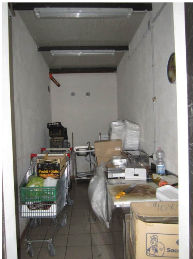
Foto 66: il "locale tecnico", limitrofo all'area destinata ad "attività commerciale", ubicata sul lato ovest dell'immobile
