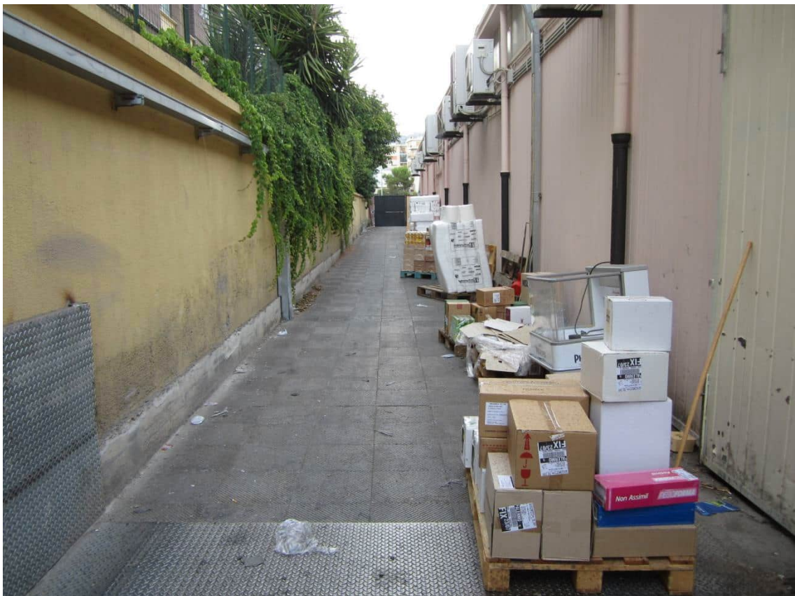
Foto 72: l'intercapedine, lungo il confine nord, cui si accede dal civ. 38 della via Emanuele Mandalà Olivieri
