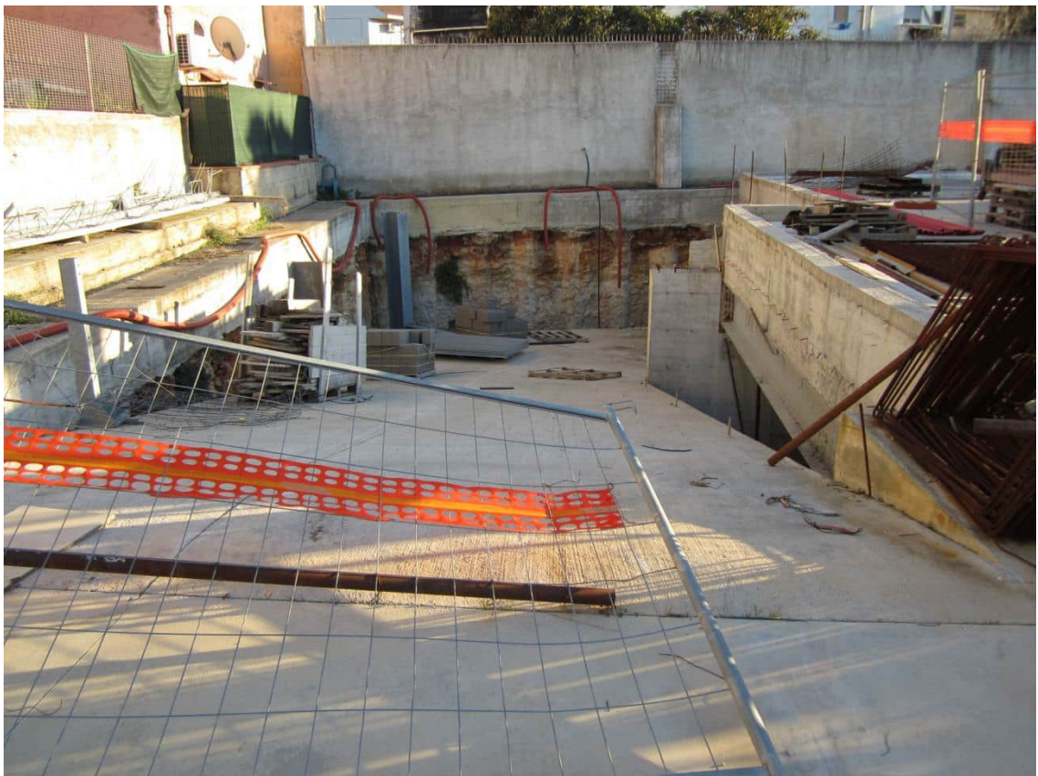
Foto 104: una delle due rampe che, dal parcheggio a raso, conducono ai tre livelli di sosta sottostanti
