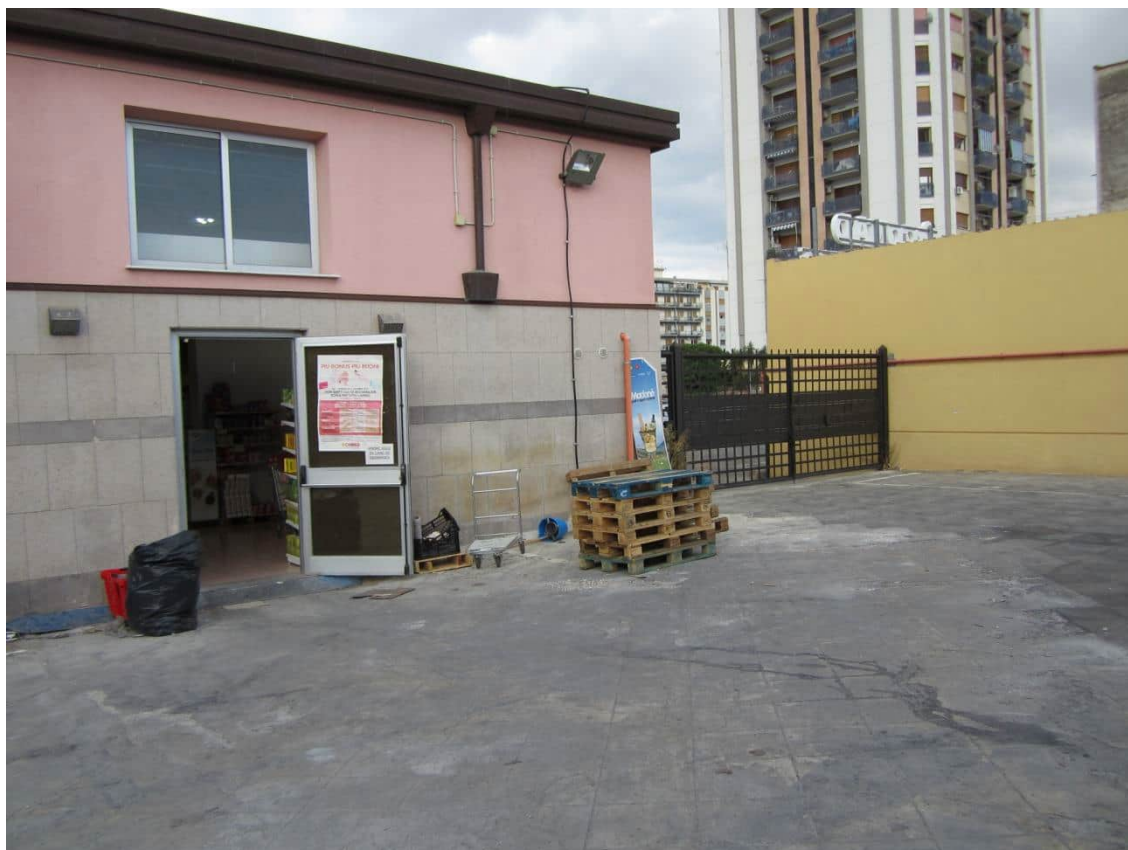
Foto 75: altra panoramica dell'area di movimentazione merci sul retro dell'immobile; al centro l'accesso al retro dell'immobile, all'area commerciale lato ovest; a destra il varco di collegamento al parcheggio antistante l'immobile, chiuso da un cancello metallico a doppia anta
