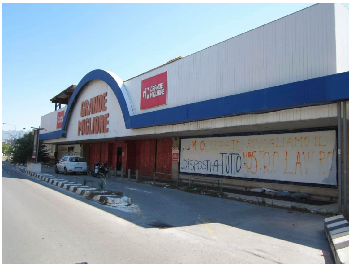
Foto 5: inquadratura del civico 4452 del Viale Regione Siciliana, da cui accede all'immobile denominato "Grande Migliore", individuato catastalmente, nel foglio 39 di Palermo, dalla particella 1015 sub. 5
