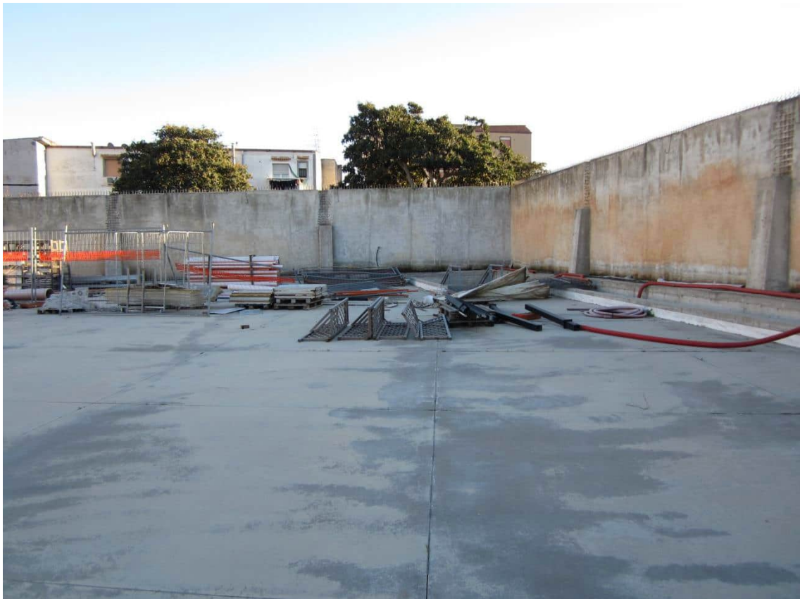
Foto 101: inquadratura, verso sud-ovest, del parcheggio a raso del multipiano parzialmente realizzato
