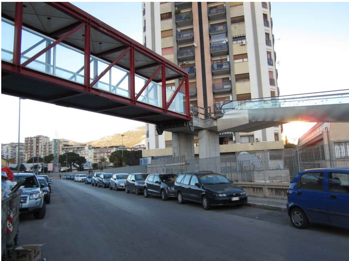
Foto 112: il nodo di attestamento tra la pensilina proveniente dal parcheggio e il sistema di tappeti mobili che sbarcano alla quota del piano terra della struttura "Grande Migliore"
