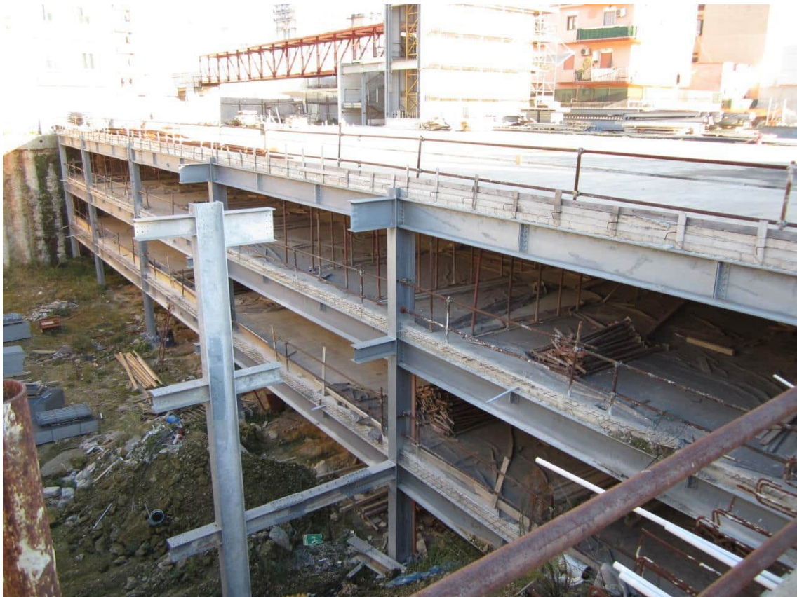
Foto 105: la struttura, in corso di realizzazione, della seconda rampa di collegamento tra il parcheggio a raso ed i tre livelli di sosta sottostanti
