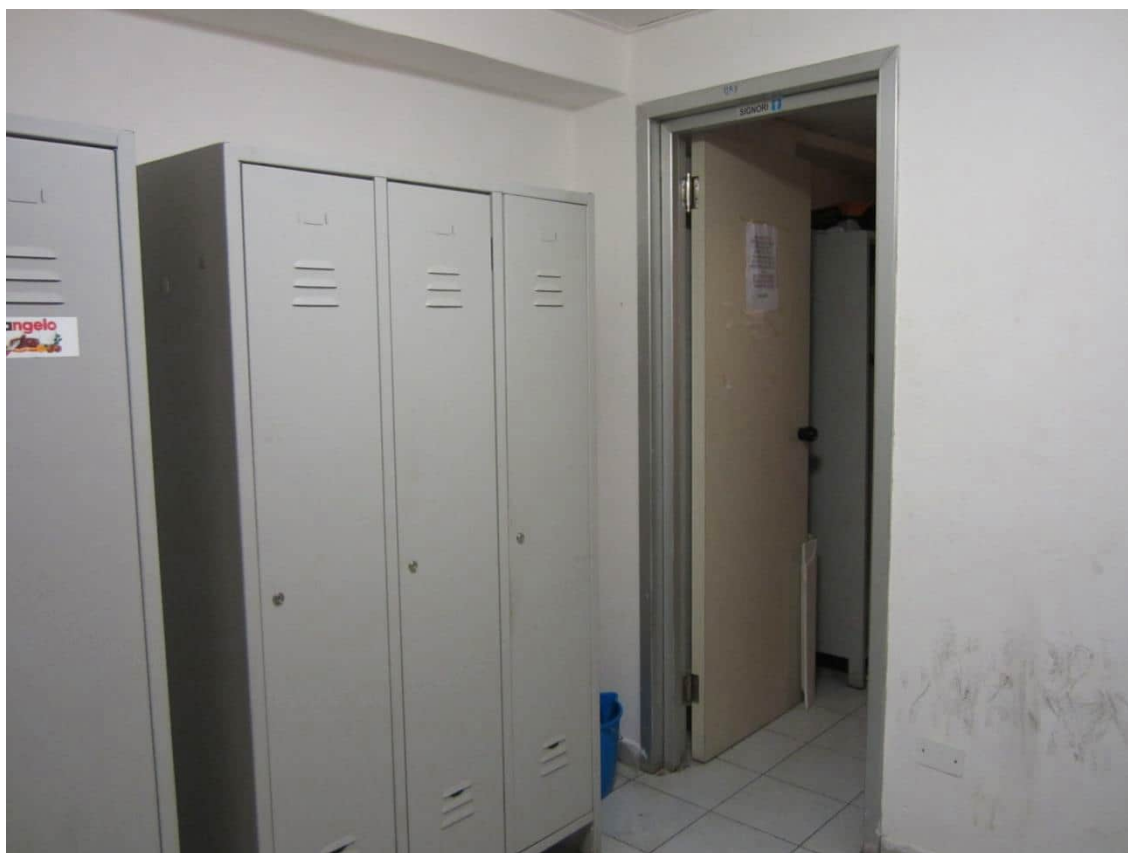
Foto 64: i locali destinati a servizi, ubicati al piano “ammezzato”
