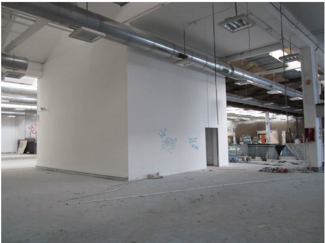
Foto 16: il blocco scale che collega verticalmente il piano terra al sottostante piano cantinato
