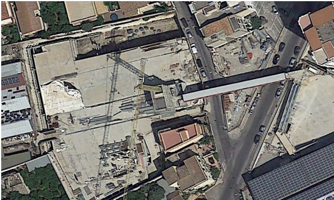
Foto 99: vista, dall'alto, del parcheggio interrato multipiano, di proprietà della Migliore Parcheggi e Servizi S.r.l., parzialmente realizzato, insistente sull'area identificata catastalmente, nel foglio 39 di Palermo, dalla particella 3700 sub. 3, cui si accede dal civico 74/c della via Buzzanca, e del sistema di passerelle aeree, e tappeti mobili, parzialmente realizzate, per il collegamento tra il parcheggio e la struttura denominata "Grande Migliore"
