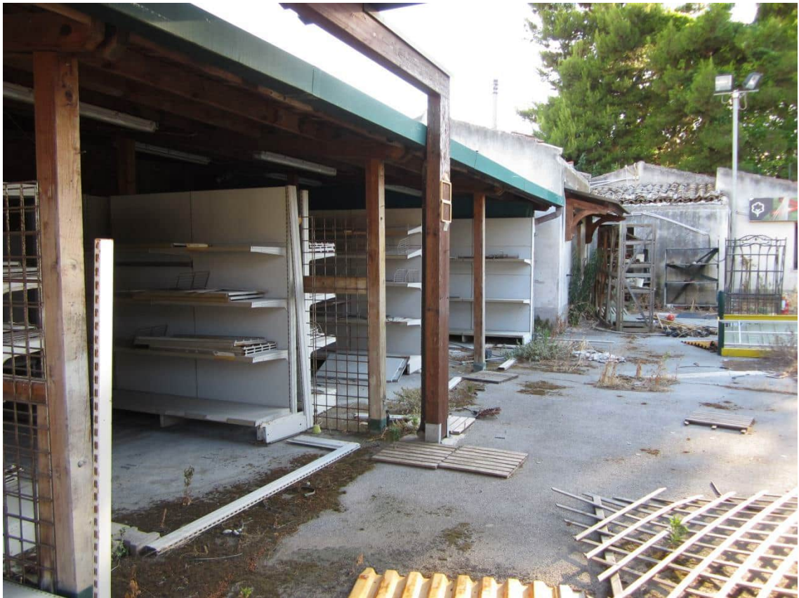
Foto 81: il tratto terminale della "teffoia", subito a sinistra entrando nell'area in cui insiste il complesso denominato "Arredo & Verde", indicata con il n. 6 nella planimetria catastale
