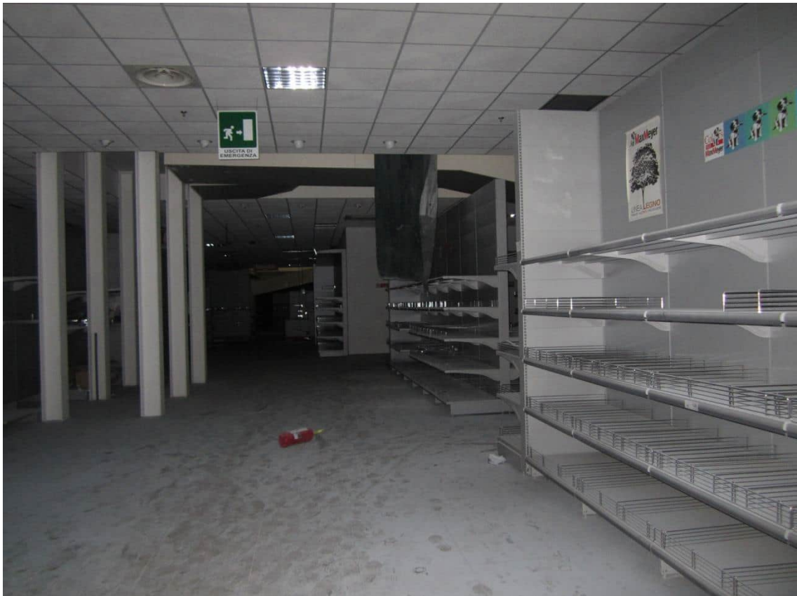
Foto 43: panoramica del piano cantinato
