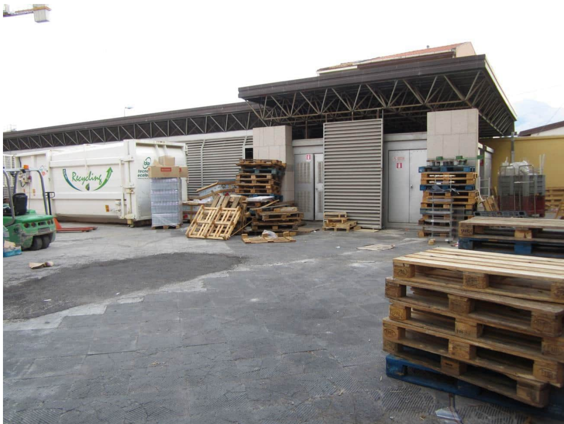
Foto 73: panoramica dell'area di movimentazione merci sul retro dell'immobile e della tettoia, destinata a deposito, che ospita la cabina elettrica (visibile sulla destra) e la riserva idrica
