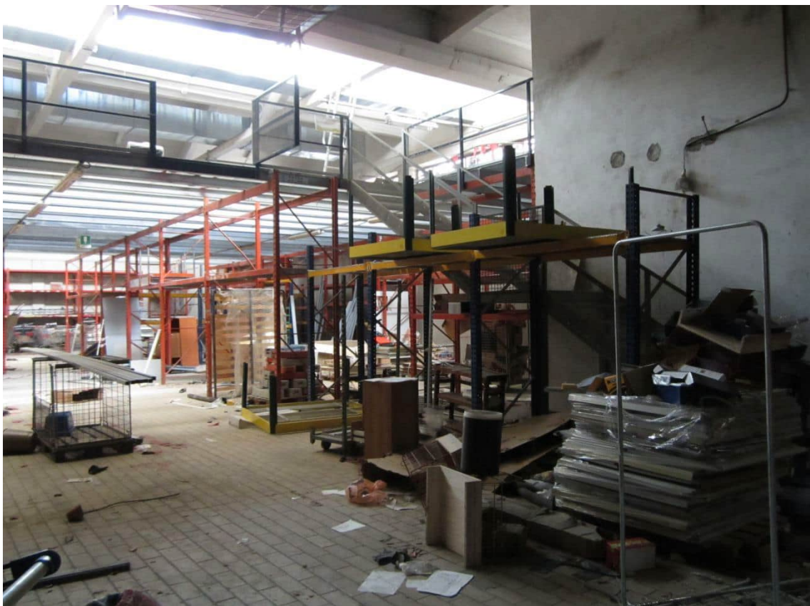
Foto 18: l'area destinata a deposito, che si trova nella porzione dell'immobile opposta all'ingresso; l'area è parzialmente soppalcata con una struttura non rappresentata catastalmente
