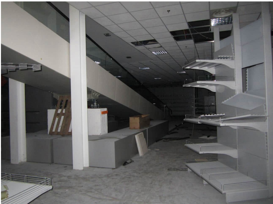
Foto 44: altra panoramica del piano cantinato, in corrispondenza dello sbarco del tappeto mobile di collegamento al soprastante piano terra
