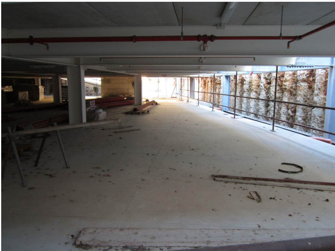
Foto 108: altra inquadratura del primo livello di sosta, sottostante il parcheggio a raso
