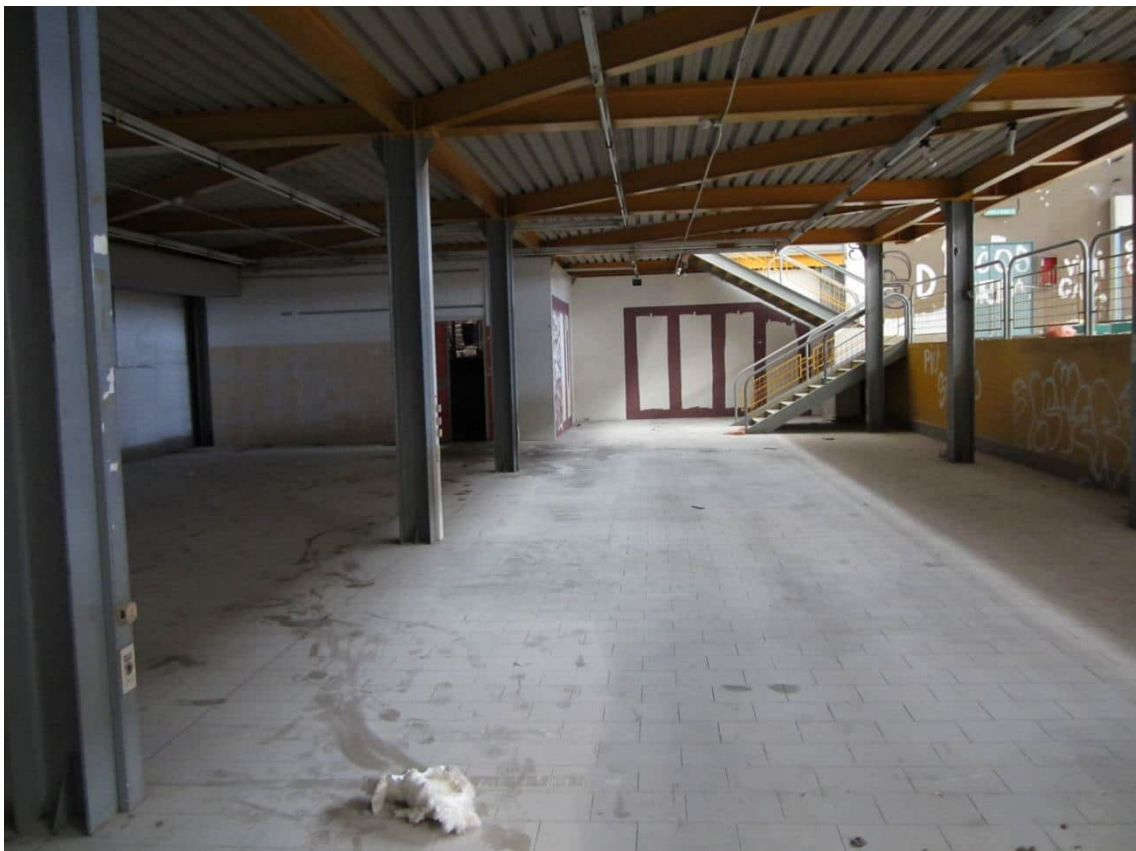
Foto 22: l'area sottostante la "zona soppalcata", che si sviluppa per oltre mq. 500
