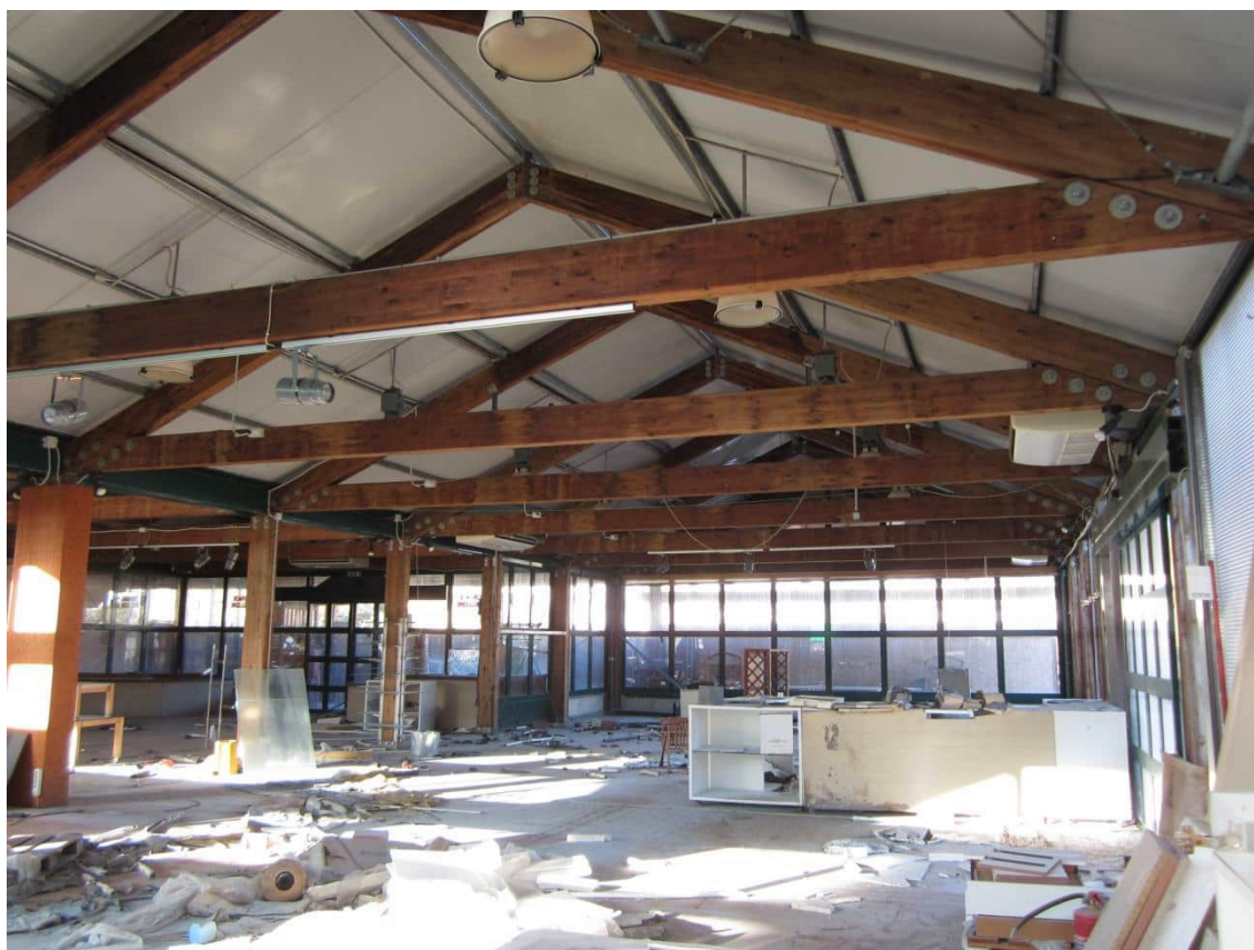
Foto 94: l'interno di uno dei prefabbricati in struttura lamellare, destinati alla "esposizione", indicati con il n. 1 nella planimetria catastale
