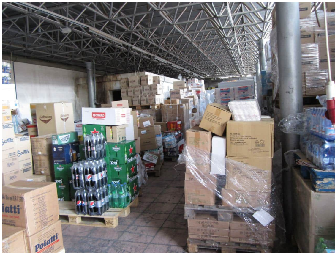
Foto 76: panoramica della "fettoia" destinata a "deposito", che si sviluppa sul retro dell'immobile
