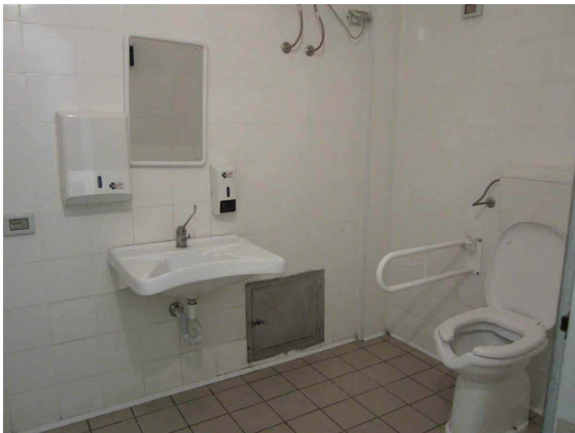
Foto 59: il w.c. per disabili, a servizio del piano terra
