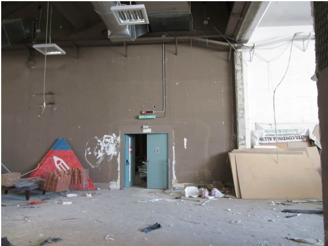
Foto 17: la parete opposta all'ingresso, nella quale si apre la porta che conduce ad un'area destinata a deposito
