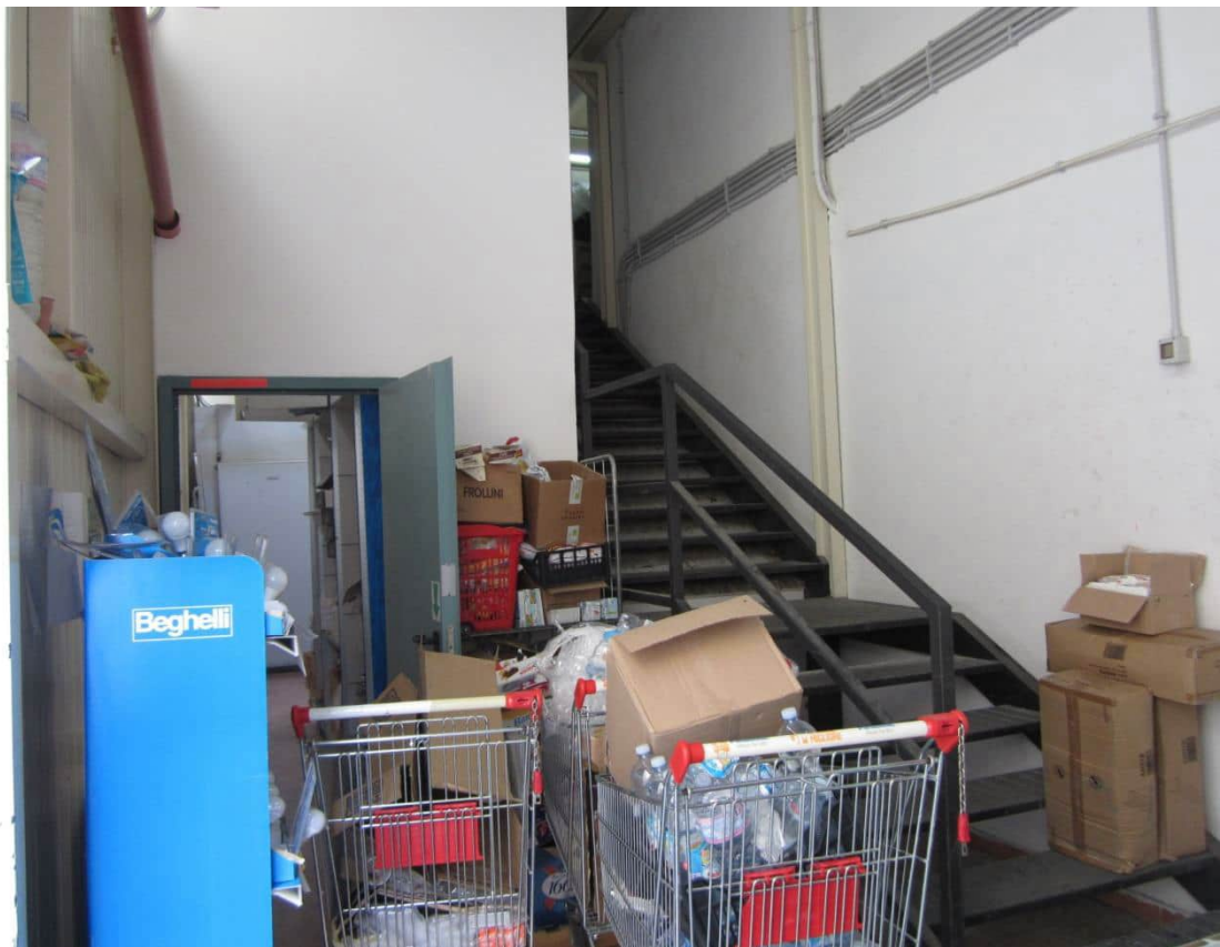
Foto 68: a sinistra dell'immagine, la porta che conduce ad una delle celle frigorifere a servizio dell'immobile
