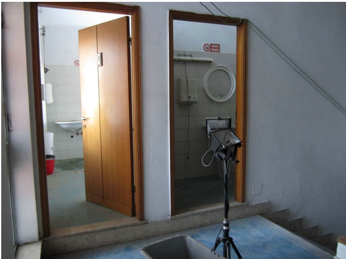
Foto 36: i w.c. a servizio della batteria di uffici ricavati nel soppalco; a destra la scala che conduce ai locali tecnici, al piano cantinato
