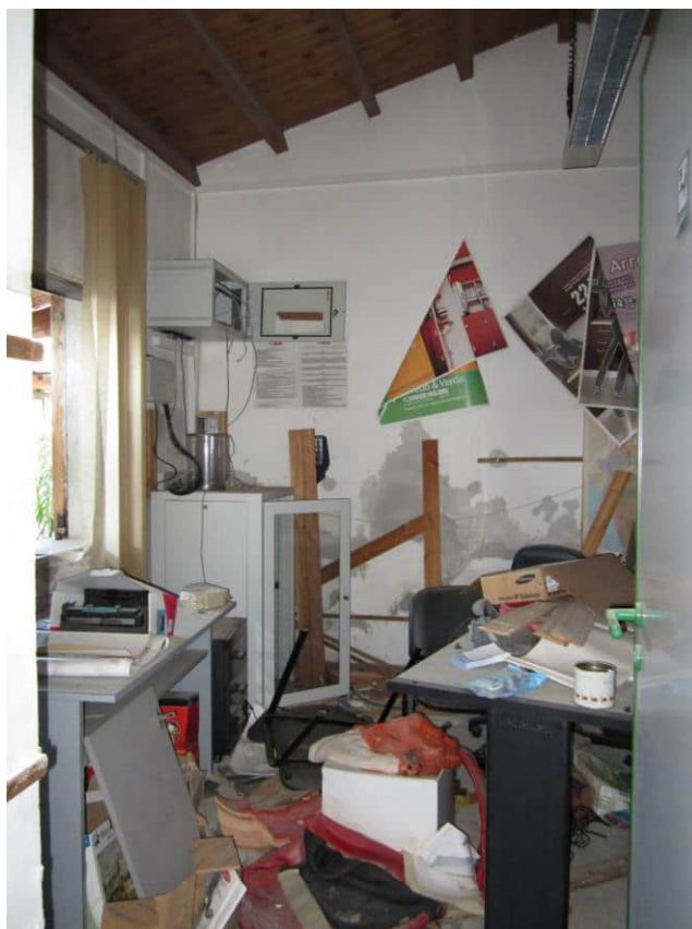
Foto 85: il locale ufficio ricavato nei manufatti in muratura, indicati nella planimetria catastale con i numeri 3 e 4
