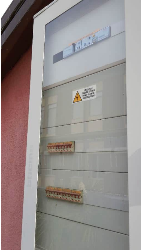
Figura 8: quadro inverter
