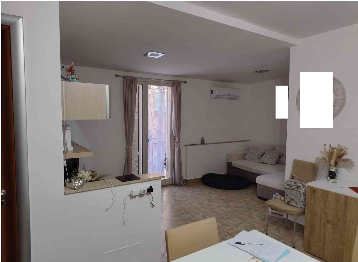
F.22 – Piano secondo, veduta dell'attuale soggiorno (vano 7) ex terrazzo.
