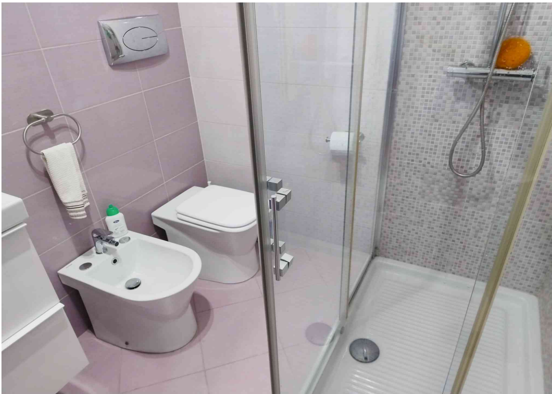
F.17 – Piano primo, altra veduta del bagno.
