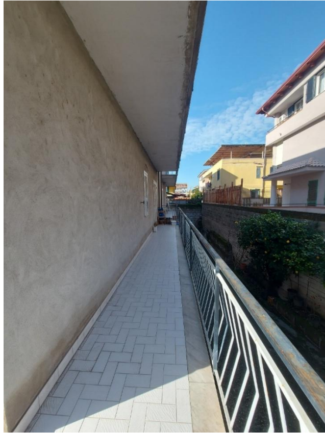
Balconata prospiciente nord (cortile comune)
