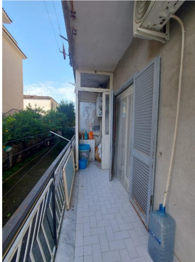
Balconata prospiciente sud (ingresso fabbricato)
