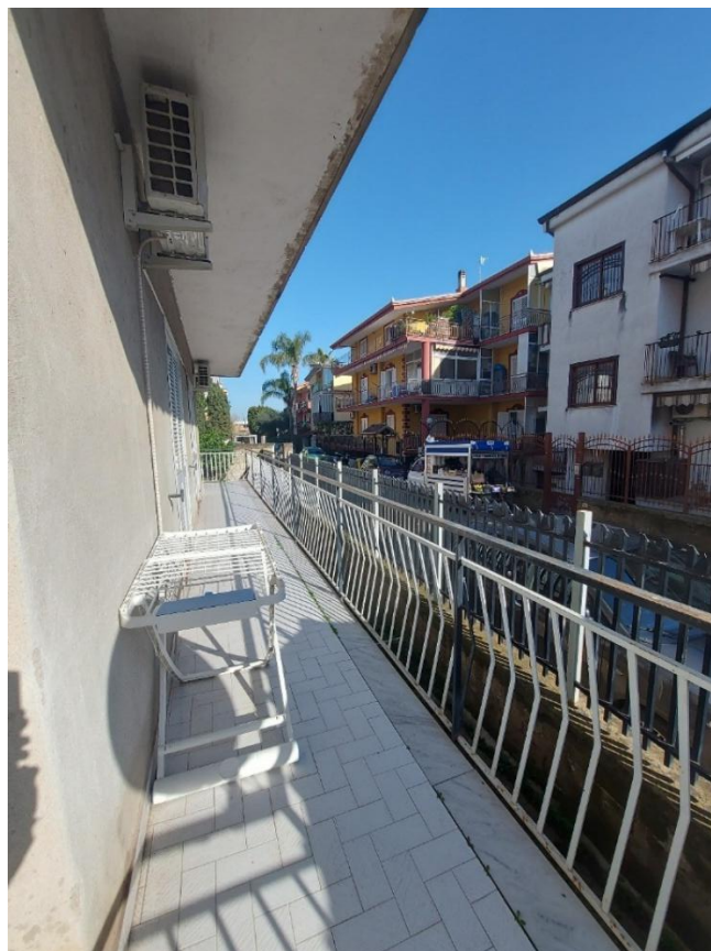
Balconata prospiciente est (via dei Glicini)
