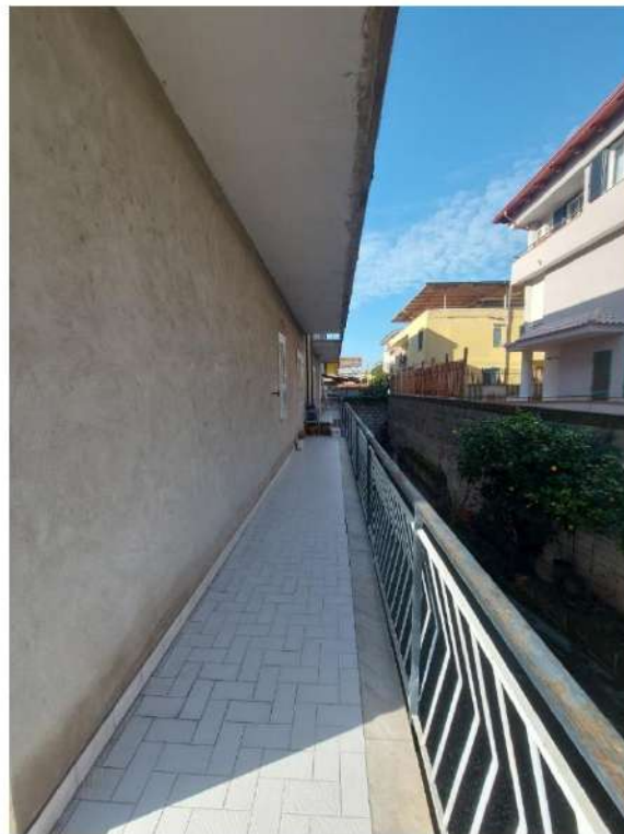
Balconata prospiciente nord (cortile comune)
