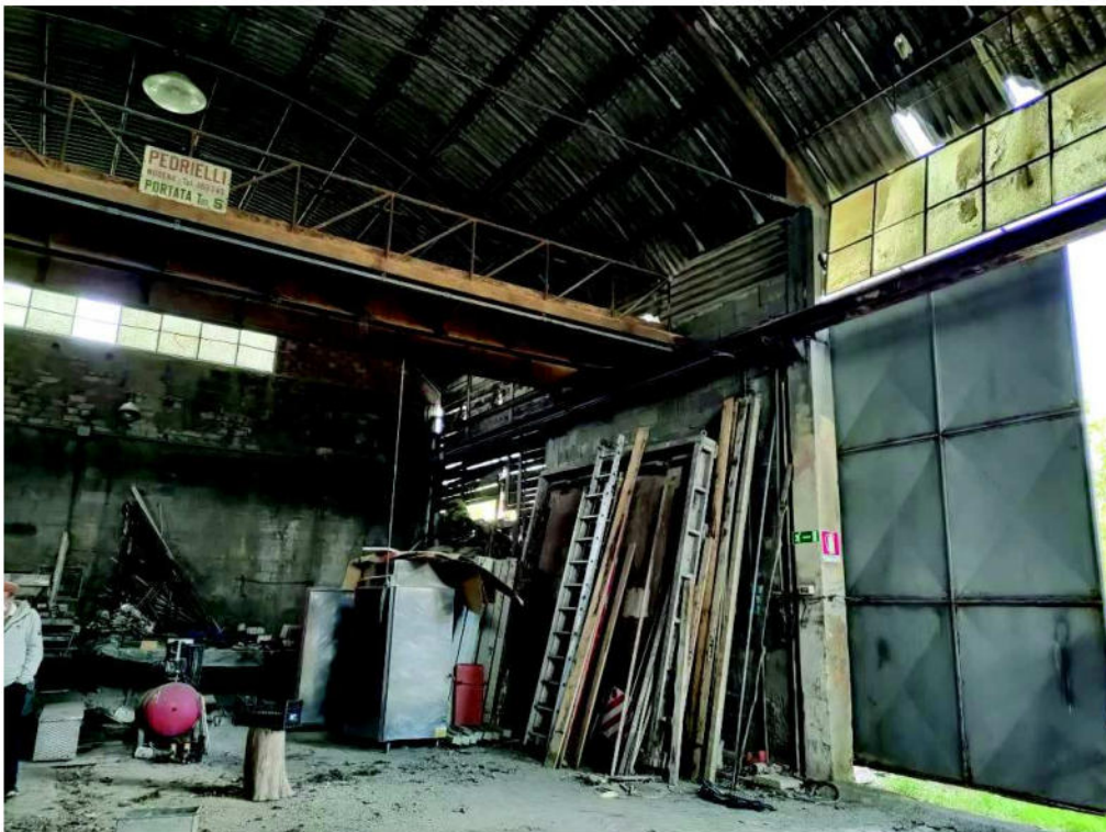
Foto 25_Ala di fabbricato con accesso da via della Ca' Rossa (Piazza del Mercato) interno
