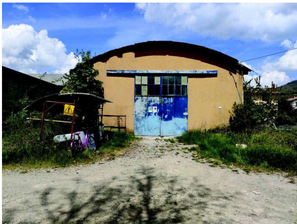
Foto 2_Unità Immobiliare uso Laboratorio artigianale prospetto su via dei Magazzini, 11
