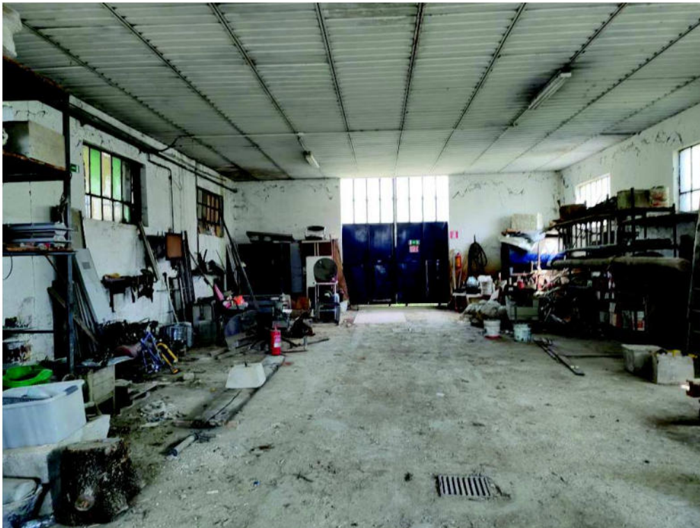
Foto 13_Fabbricato con accesso da via dei Magazzini prospetto tergale interno
