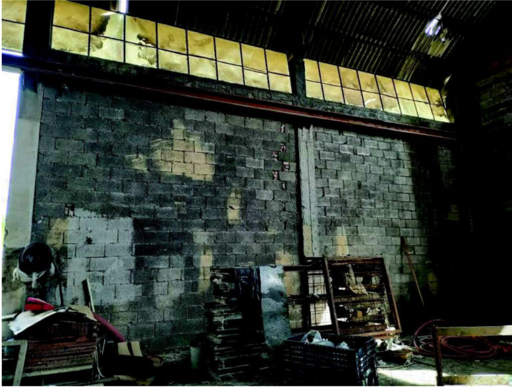
Foto 22_Ala di fabbricato con accesso da via della Ca' Rossa (Piazza del Mercato) interno
