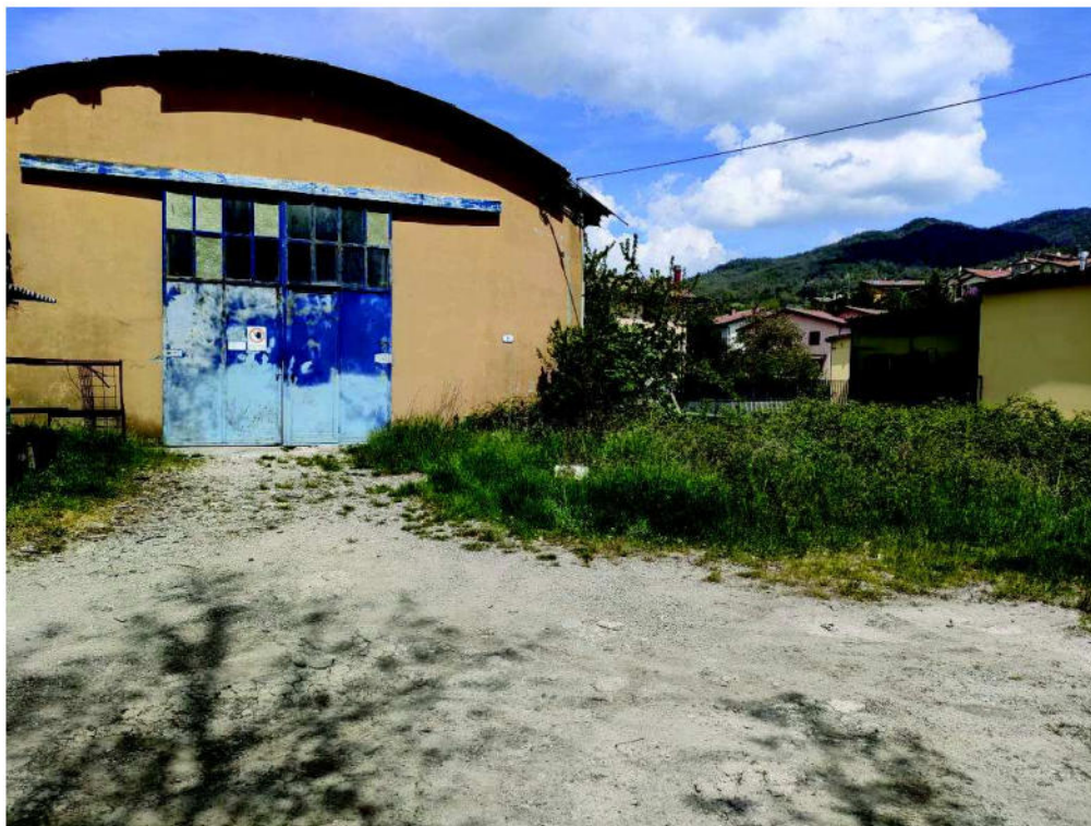
Foto 3_ U.I. uso Laboratorio artigianale prospetto su via dei Magazzini, 11 e resede anteriore (lato destro)
