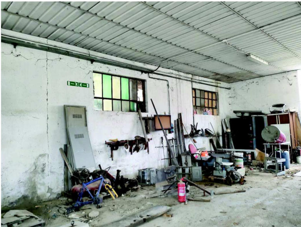
Foto 10_U.I. uso Laboratorio artigianale prospetto interno lato verso l'altra ala del fabbricato
