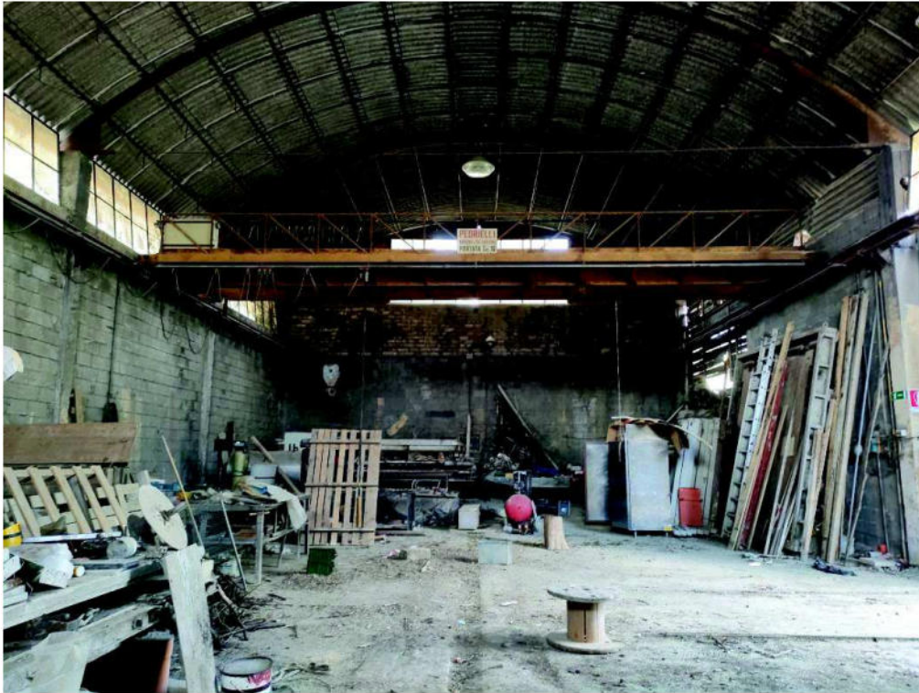
Foto 18_Ala di fabbricato con accesso da via della Ca' Rossa (Piazza del Mercato) interno
