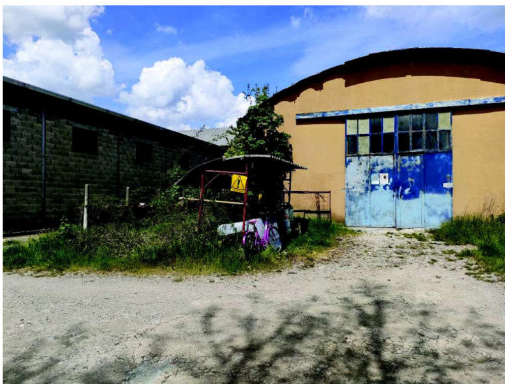
Foto 4_ U.I. uso Laboratorio artigianale prospetto su via dei Magazzini, 11 e resede anteriore (lato sinistro)
