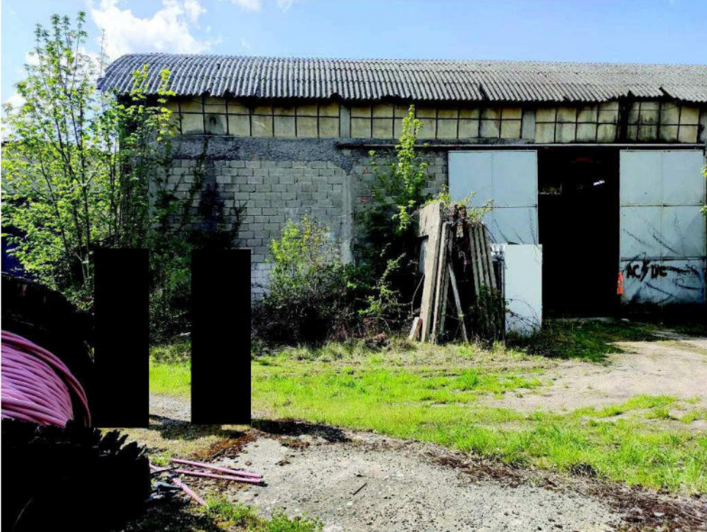
Foto 16_Ala di fabbricato con accesso da via della Ca' Rossa (Piazza del Mercato)
