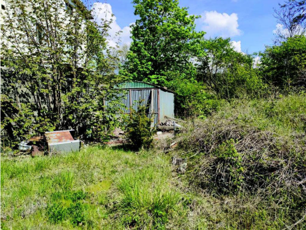
Foto 30_Piccolo prefabbricato abbandonato nella resede tergale esclusiva, da rimuovere
