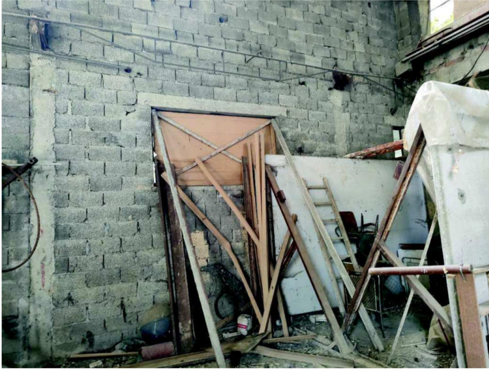
Foto 24_Ala di fabbricato con accesso da via della Ca' Rossa (Piazza del Mercato) interno
