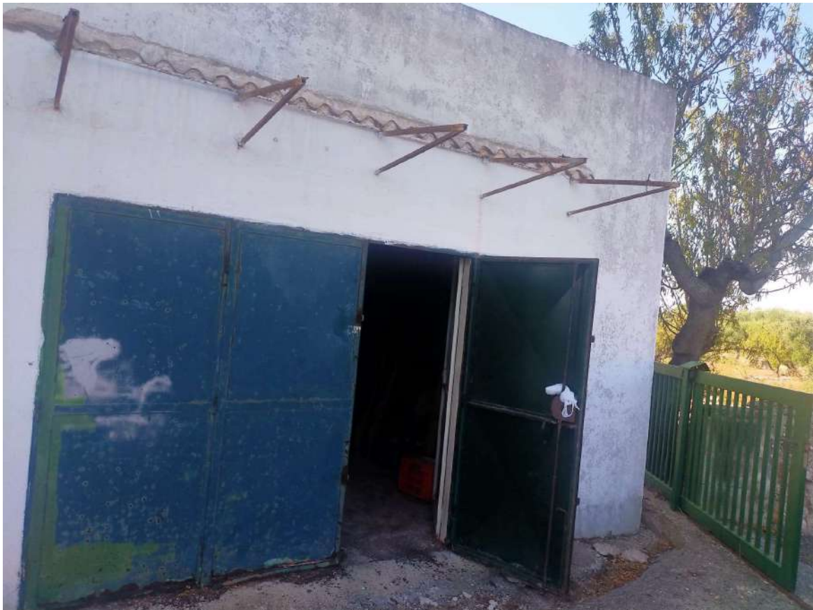
Foto n. 26 – Garage vista esterna.
