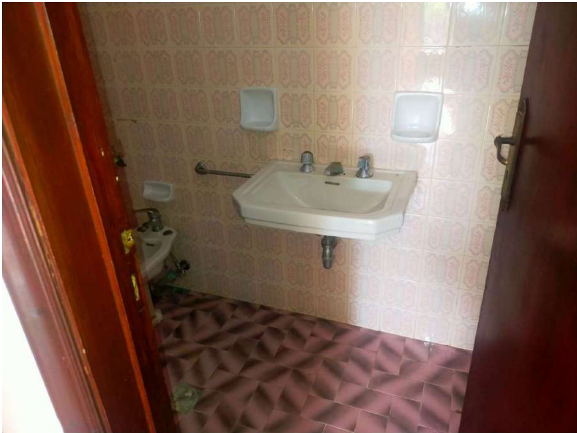
Foto n. 17 – Bagno dell'edificio adiacente il trullo.
