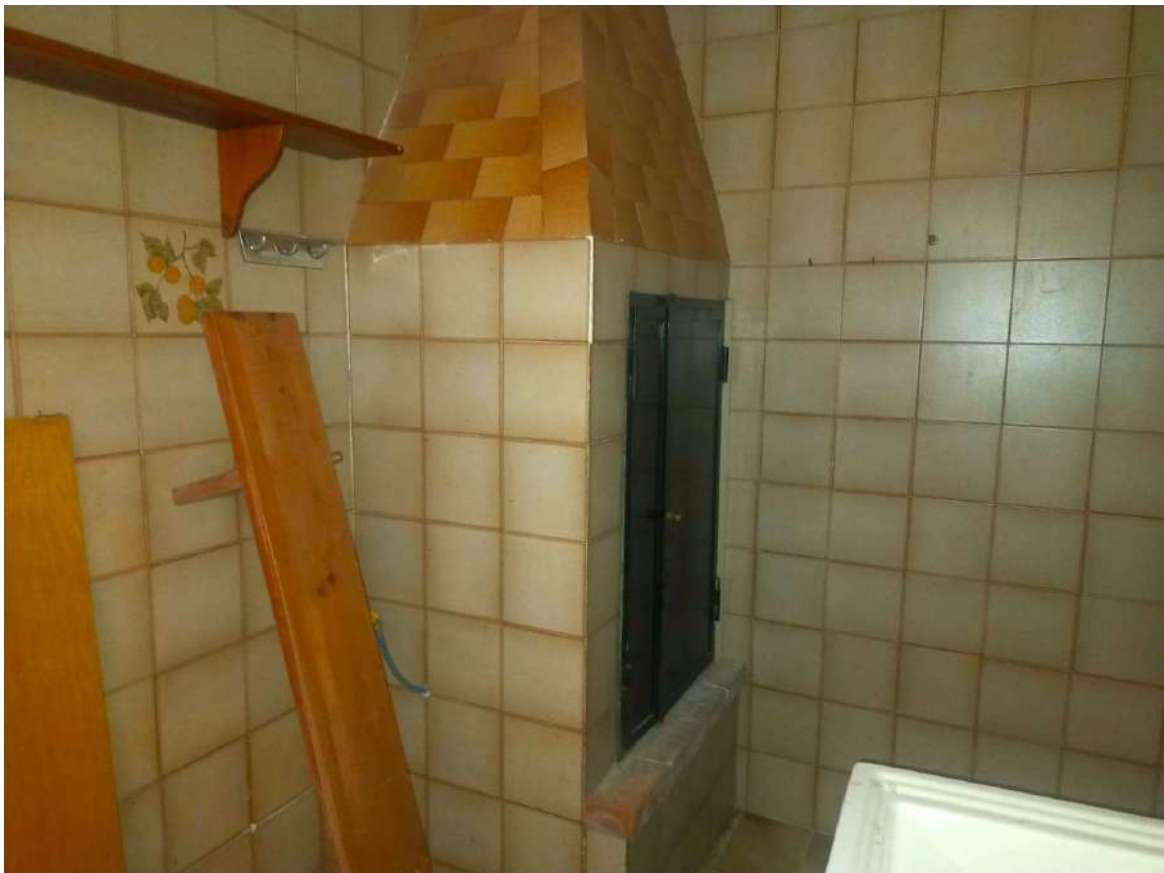
Foto n. 12 – Caminetto ubicato nel vano cucina.
