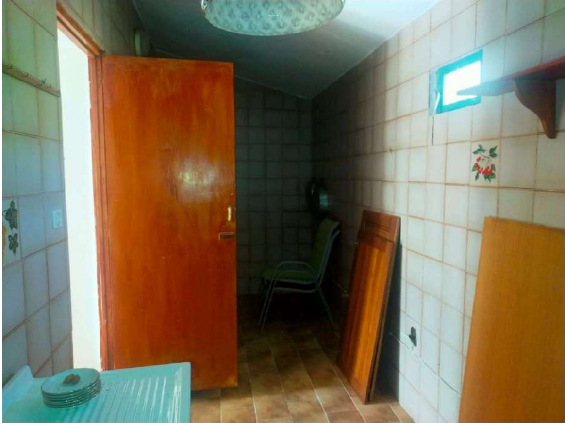
Foto n. 11 – Vista del Vano cucina.
