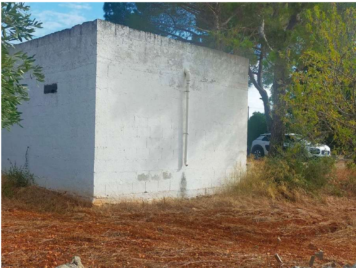
Foto n. 27 – Prospetto posteriore garage.
