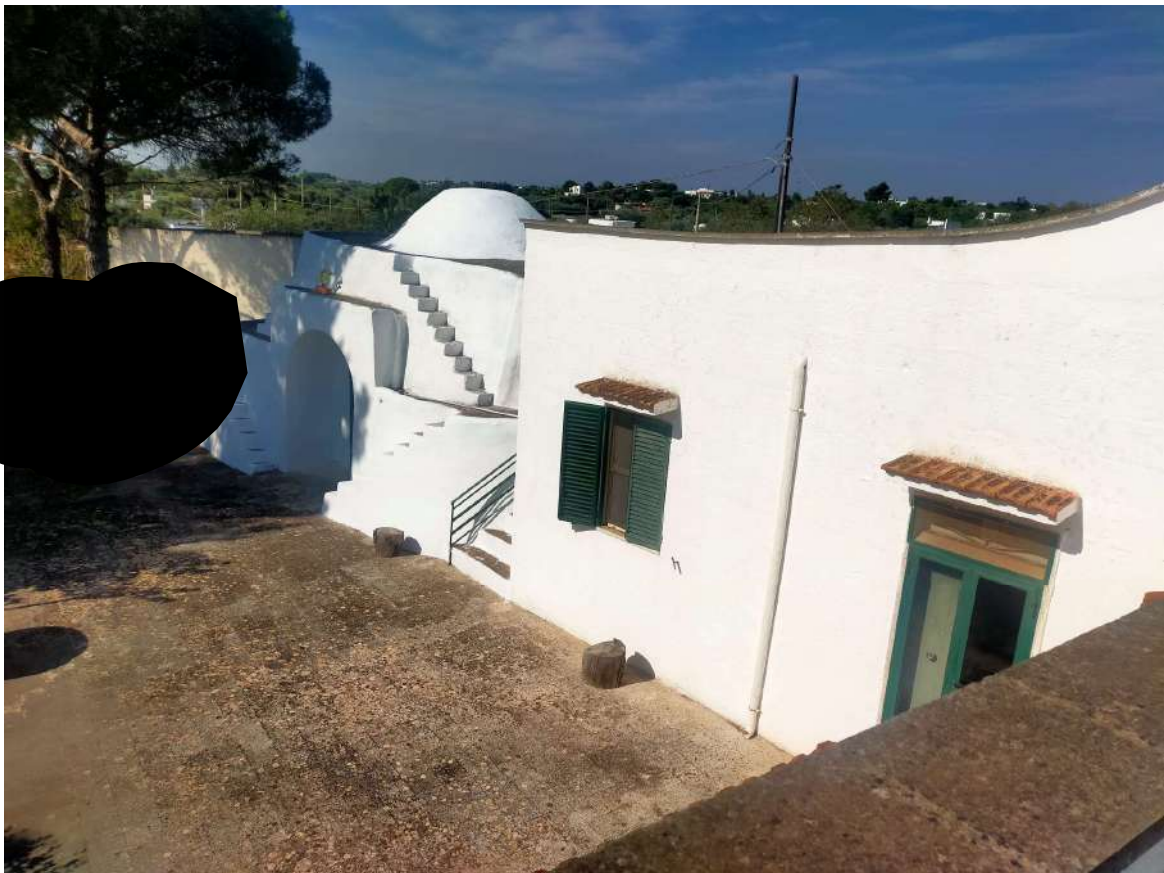
Foto n. 6 – Vista d'insieme del trullo con abitazione adiacente.
