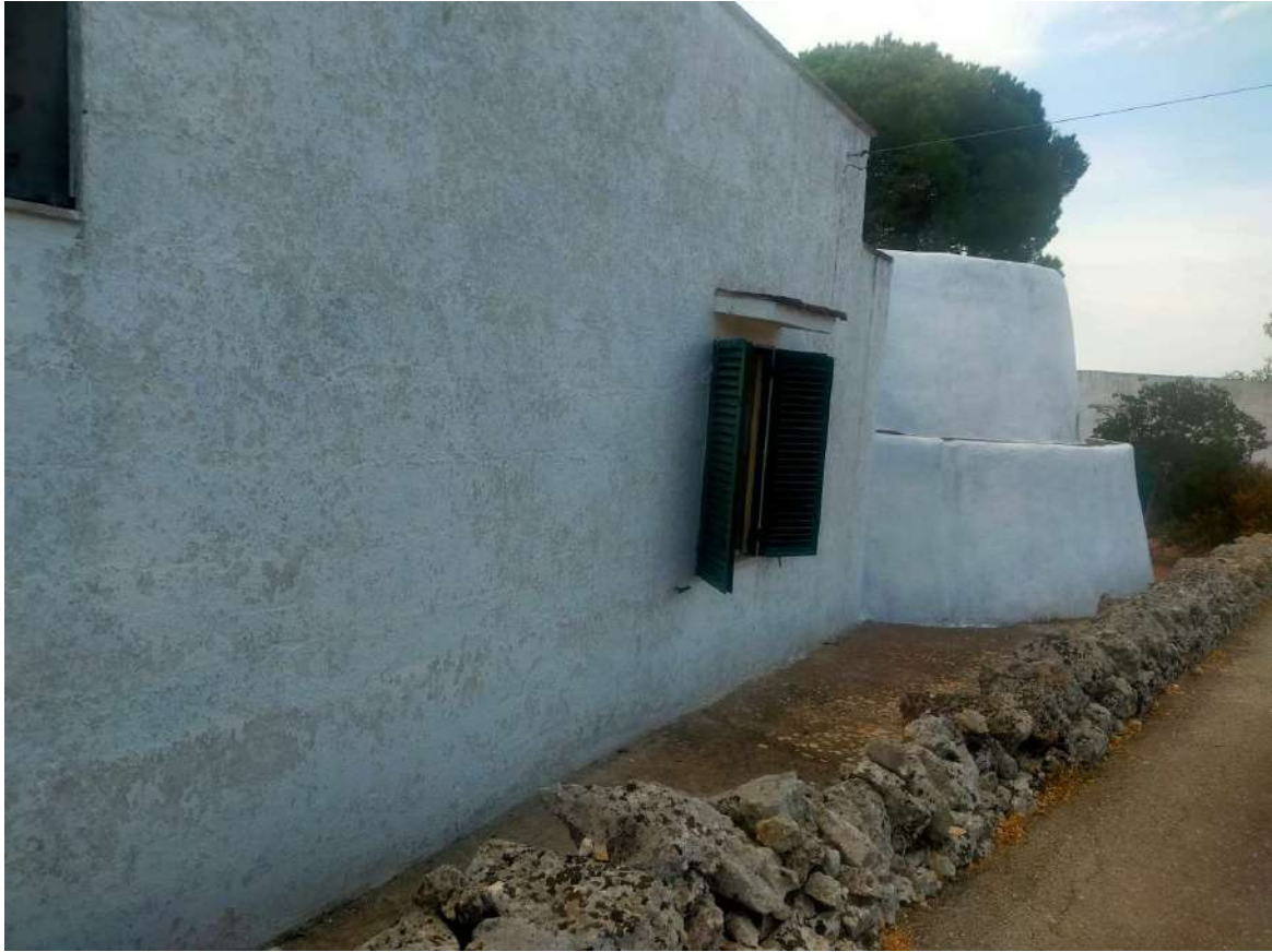
Foto n. 3 – Vista del prospetto laterale del Trullo prospiciente la strada vicinale.
