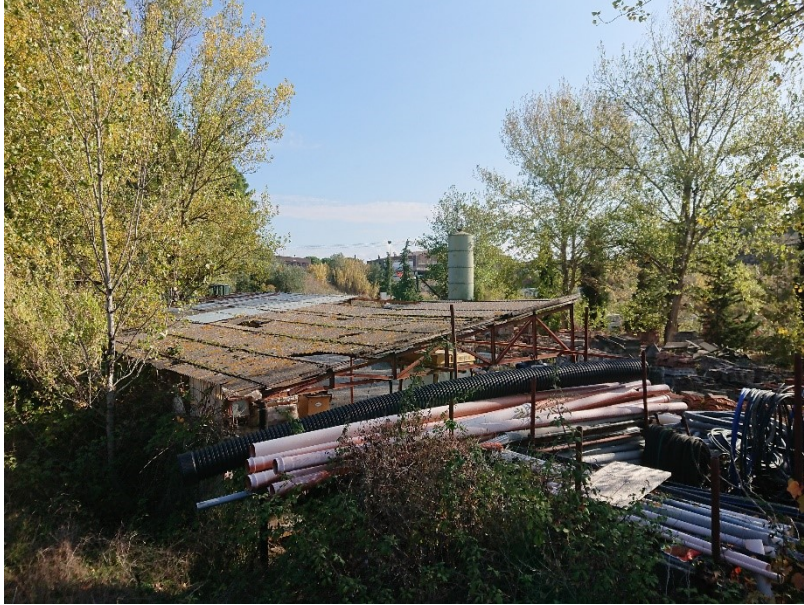
Figura 3 – Contributi fotografici (sopralluogo 2021)
