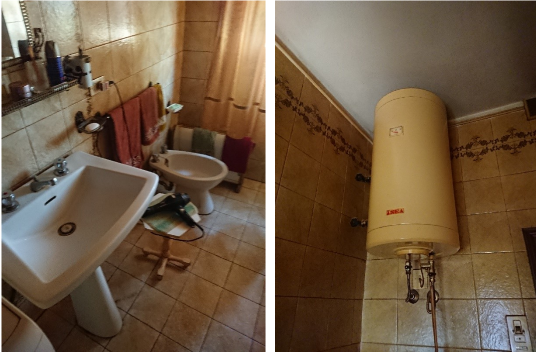
Figura 6 – Contributi fotografici dei Locali interni (sub3) - (sopralluogo 2019)
