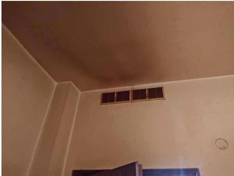
Figura 7 – Contributi fotografici dei Locali interni (sub3) - (sopralluogo 2019)
