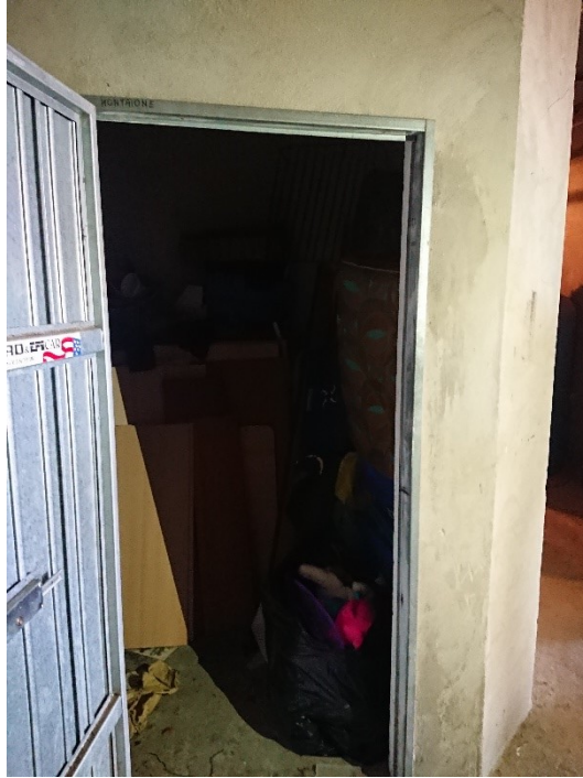
Figura 10 – Contributi fotografici del locale cantina - (sopralluogo 2019)
