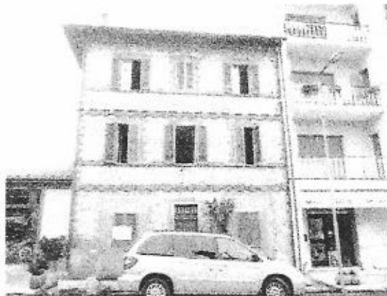
FOTO 3 - Fabbricato/appart. visto da via Buozzi
