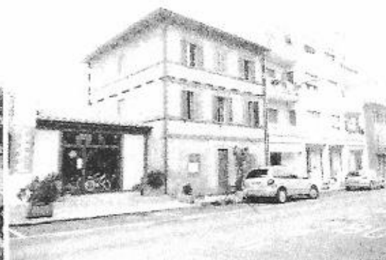
FOTO 2 - Fabbriato/appart. visto da via Buozzi
