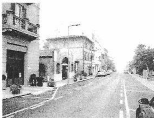
FOTO 1 - Fabbriato visto da via Buozzi
