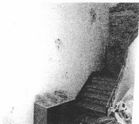
FOTO 5 - Vano scala condominiale
