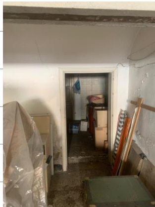
Vano Garage -porta accesso deposito-
