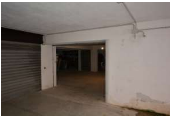
Foto 7 - Ingresso magazzino da corsia di manovra
